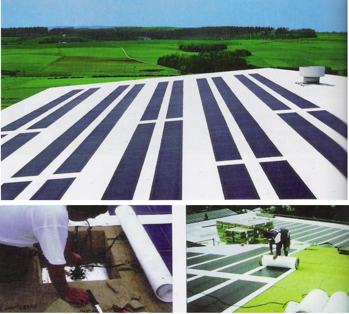
Şekil 5.16 Düz çatı üzerine ince film güneş pili uygulaması (German SES, 2005)
