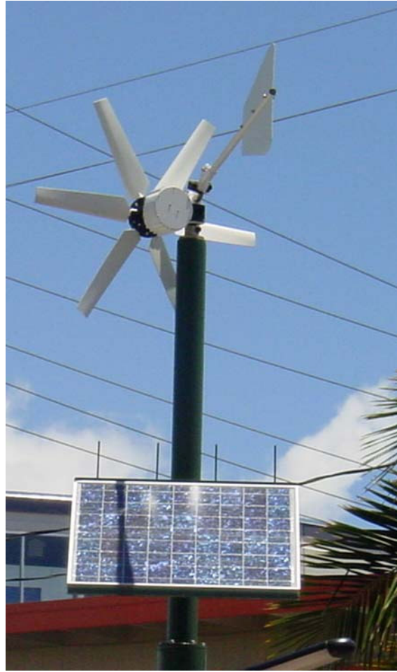
Şekil 4.8 Rüzgar türbini ve PV modülün birlikte kullanıldığı bir hibrid sistem [8]
