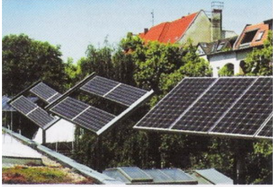
Şekil 2.13 İki eksenli güneş takip sistemi (German SES, 2005)
