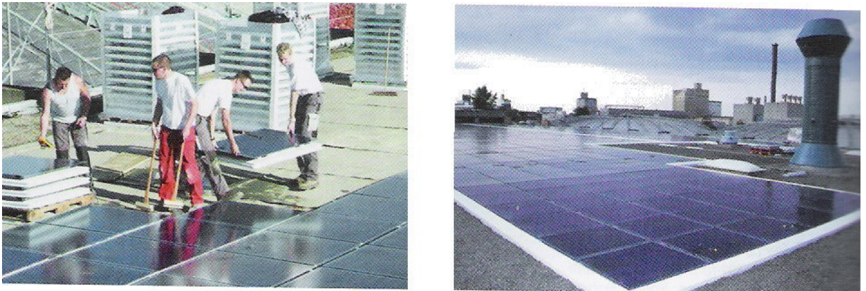
Şekil 5.17 Düz çatının bir kısmının güneş piliyle kaplanması (German SES, 2005)
