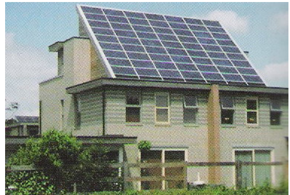
Şekil 5.8 Eğimli çatıda çatıyla bütünleşik uygulama (German SES, 2005)
