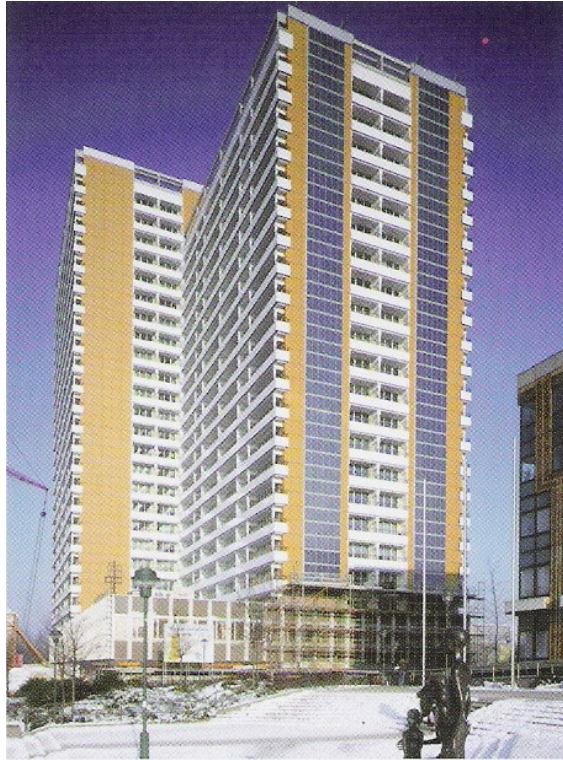
Şekil 5.22 Yüzeyin kısmen güneş panelleriyle kaplanması (Helene Weigel Plaza, Berlin) (German SES, 2005)
