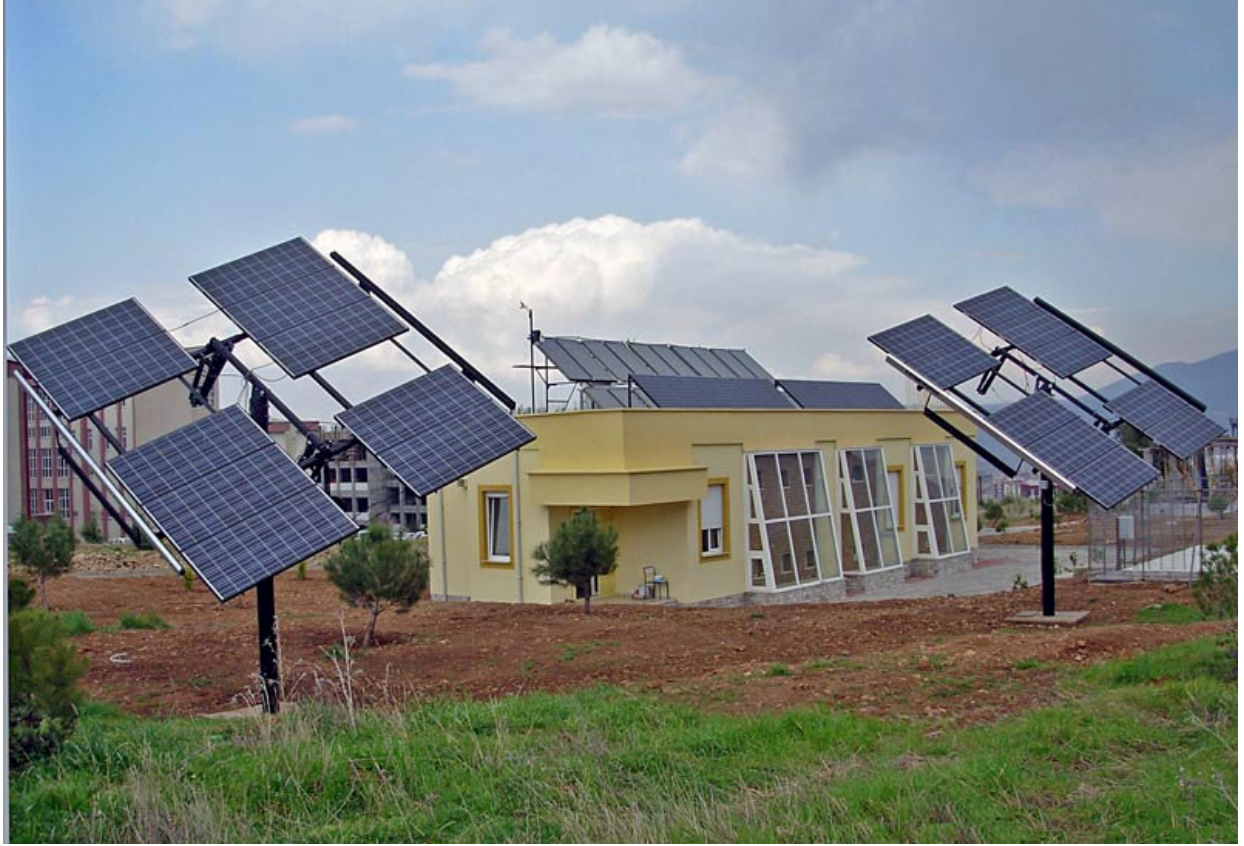
Şekil 6.10 Sistemdeki sabit ve hareketli güneş panellerin görünümü [4]
