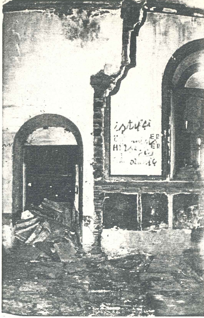
Foto 163- Sağ yan duvar K4 kapısı.
