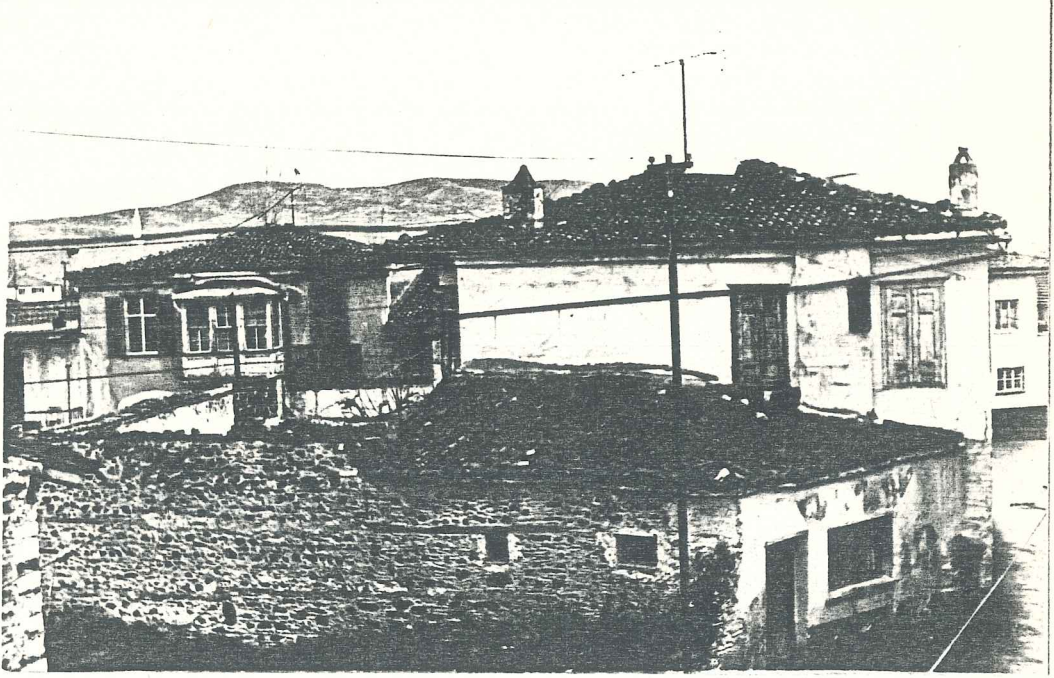
Foto 5- Kula'dan genel görünüş. Zaferiye mahallesi, Aya Stefanos Kilisesi civarı.
