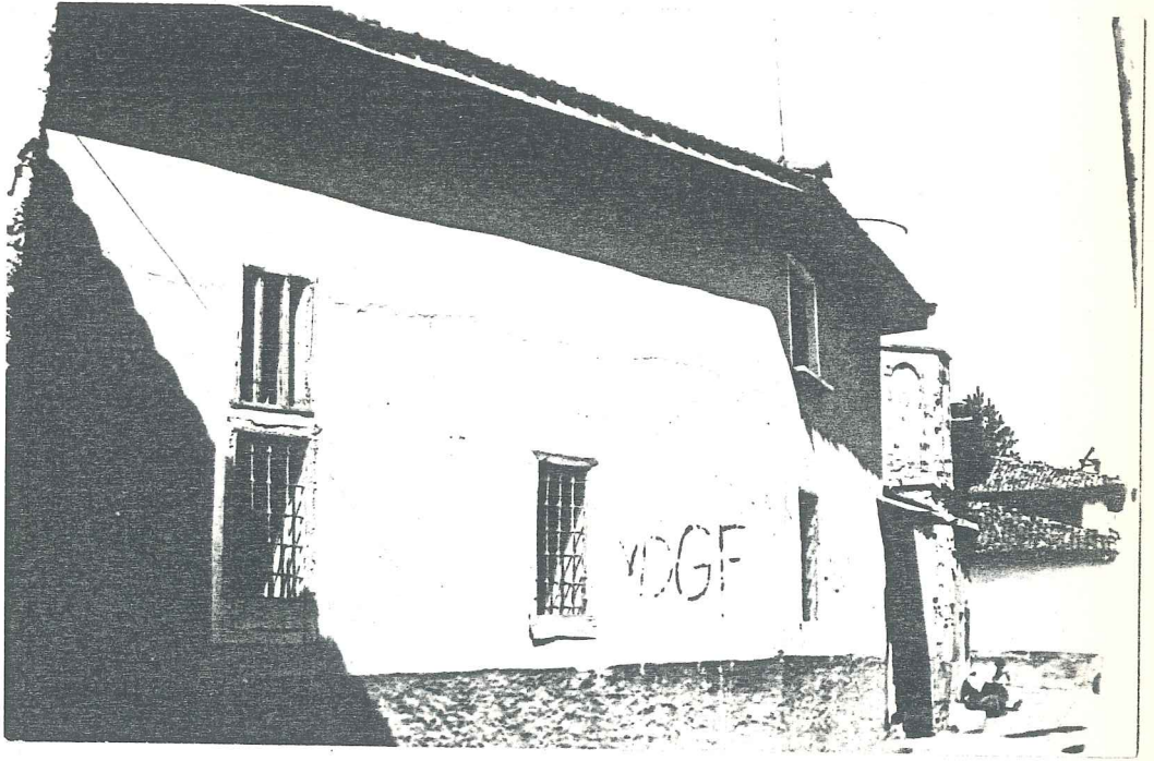
Foto 63- Taş Mahalle Camii. Dış Görünüş.
