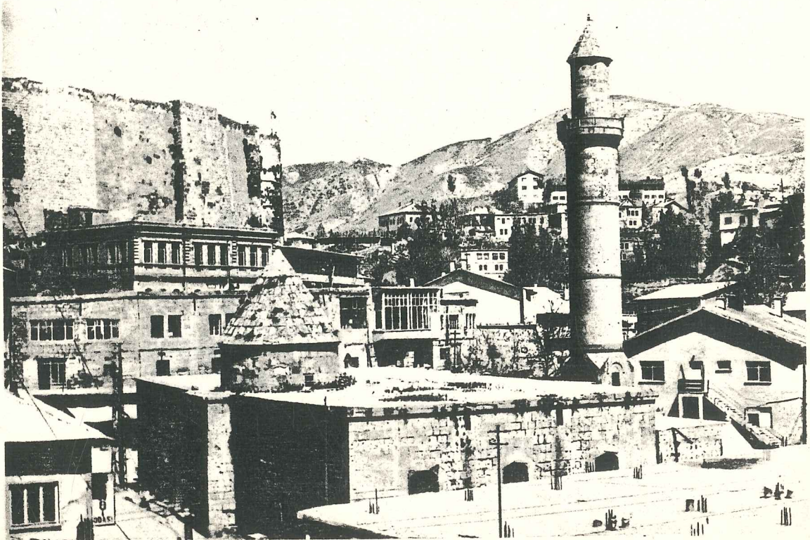
F.20- Ulu Cami minaresi onarımdan sonra
