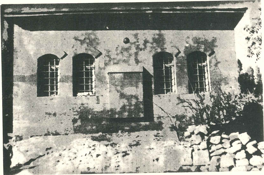
F.26- Yeni yapılardan Hersan Camii
