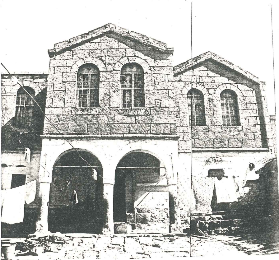
F.226 Giriş yüzünün görünüşü
