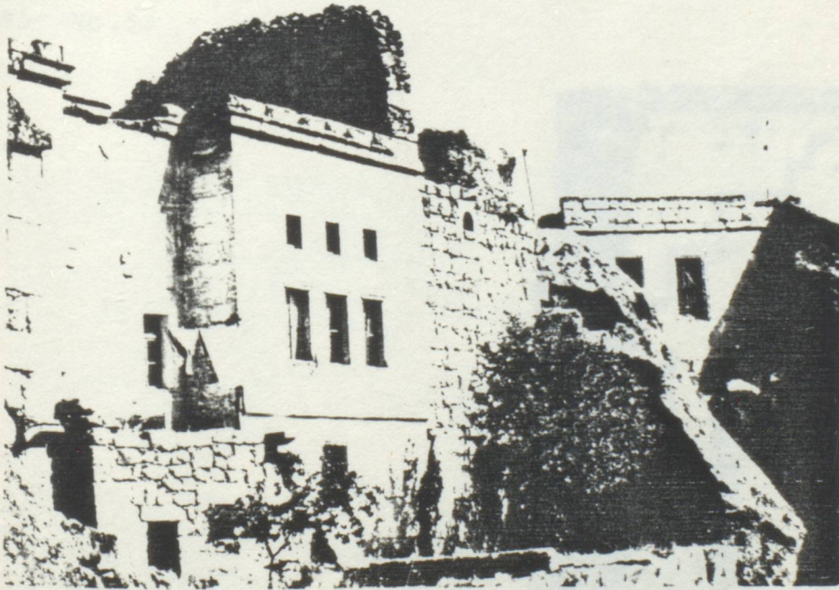
Resim No.52: Yukarı mahalle yar üzerinde yiöma yapı
