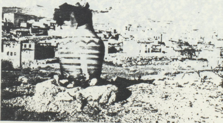
Resim No.21: Toorak küpün baca olarak kullanımı
