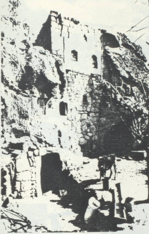
Resim No.45: Yarıklı kaya üzerine gelişmiş yiğma yapı
