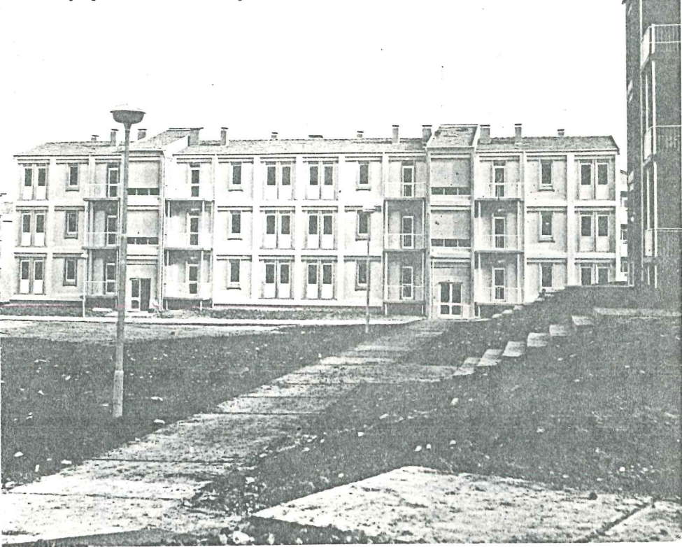
Şekil-50 Hücre birimleri ile yığma sistemi yolu ile yapılmış konutlar.
