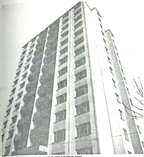
İSTANBUL KOZYATAGI OYAK TOPLU KONUT İNŞAATI
