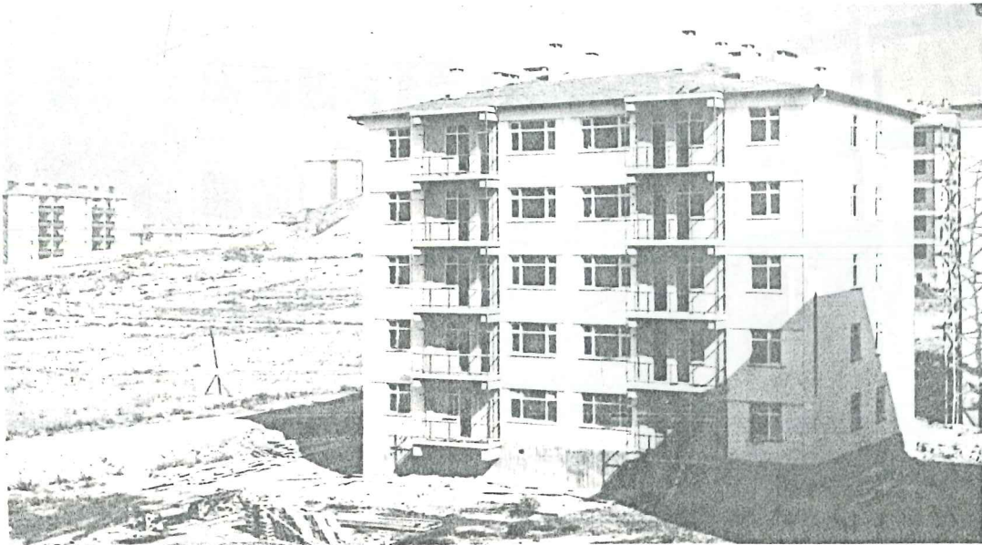
İskelet sistemlerle uygulanmış yapı örnekleri
