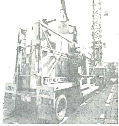
Şekil-29 Eleman büyüklüğüne her üç boyutta da taşıma sınırları vardır.
