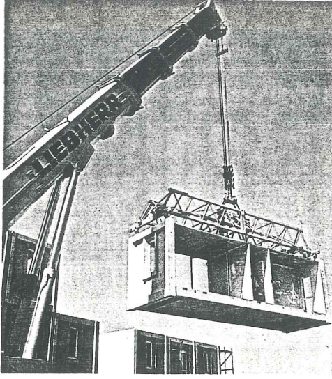
Şekil:74 YÜBETAŞ uygulamalarında montaj aşaması
