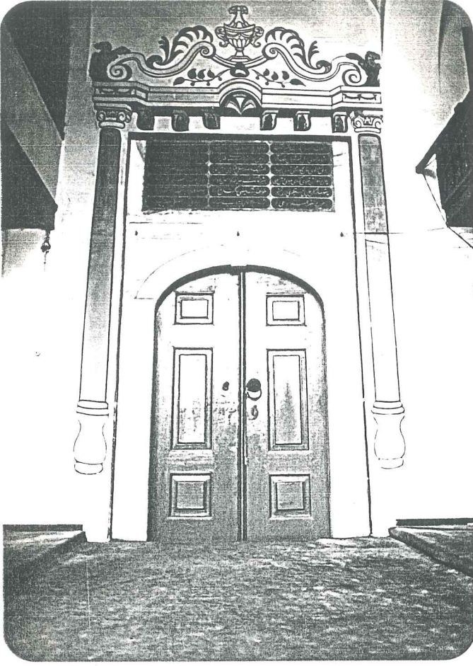
Resim 14: Cami Giriş Kapısı ve Kitabesi
