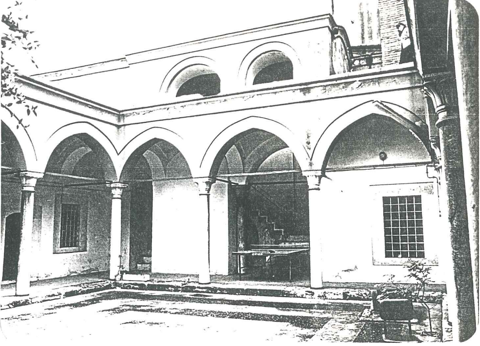
Resim 56: Tekke Avlu Güney Cephesi.
