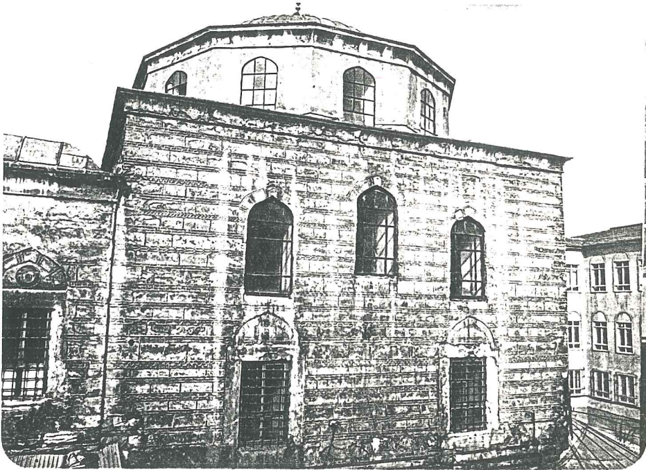
Resim 17: Şengül Hamamı Yokuşu Cephesi.
