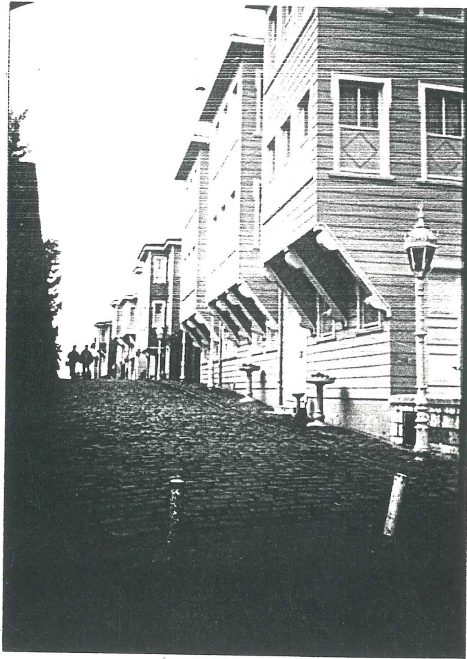
Günümüzde Soğukçeşme Sokağı'ndaki evlerin durumu
