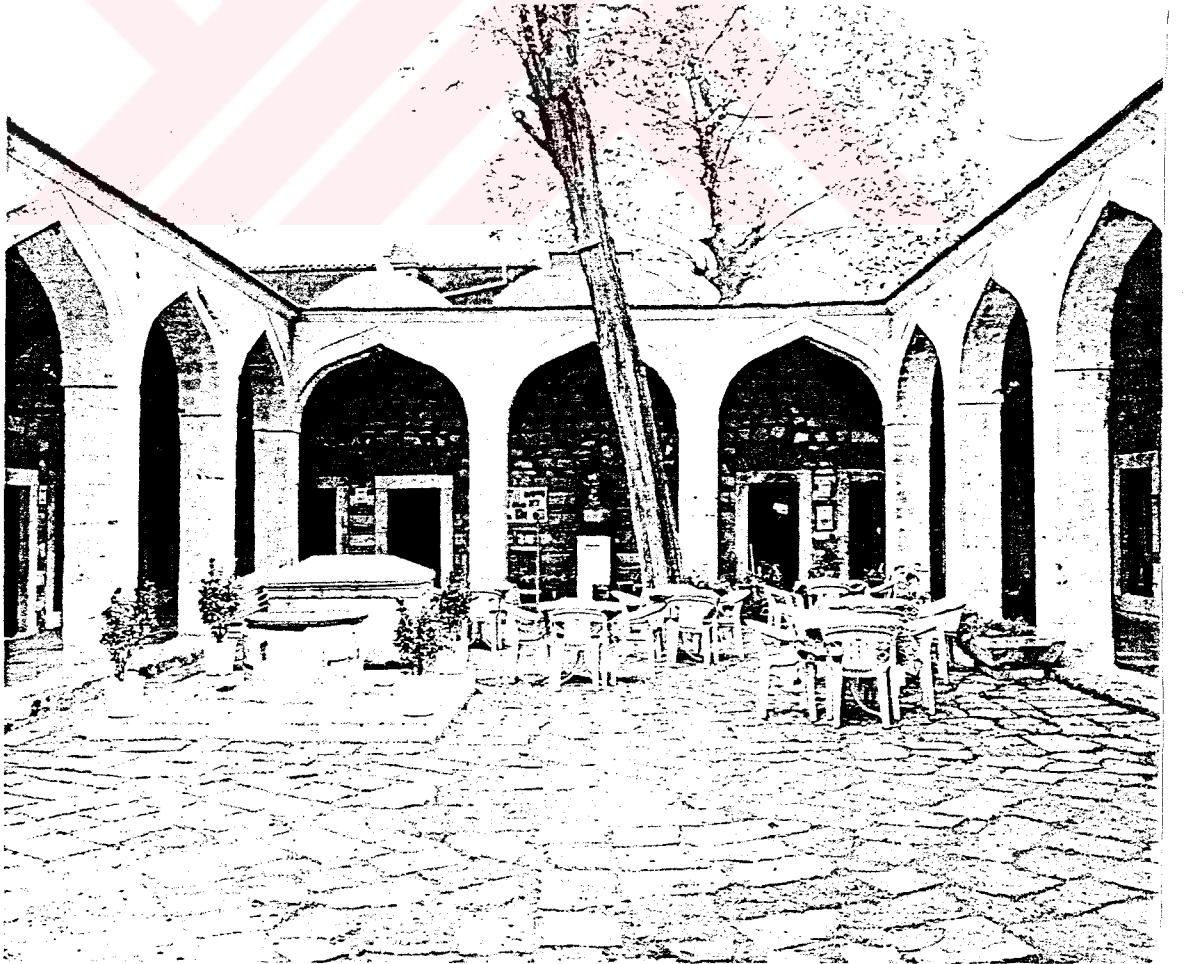
Resim 91 - Restorasyon Sonrası Cafer Ağa Medresesi
