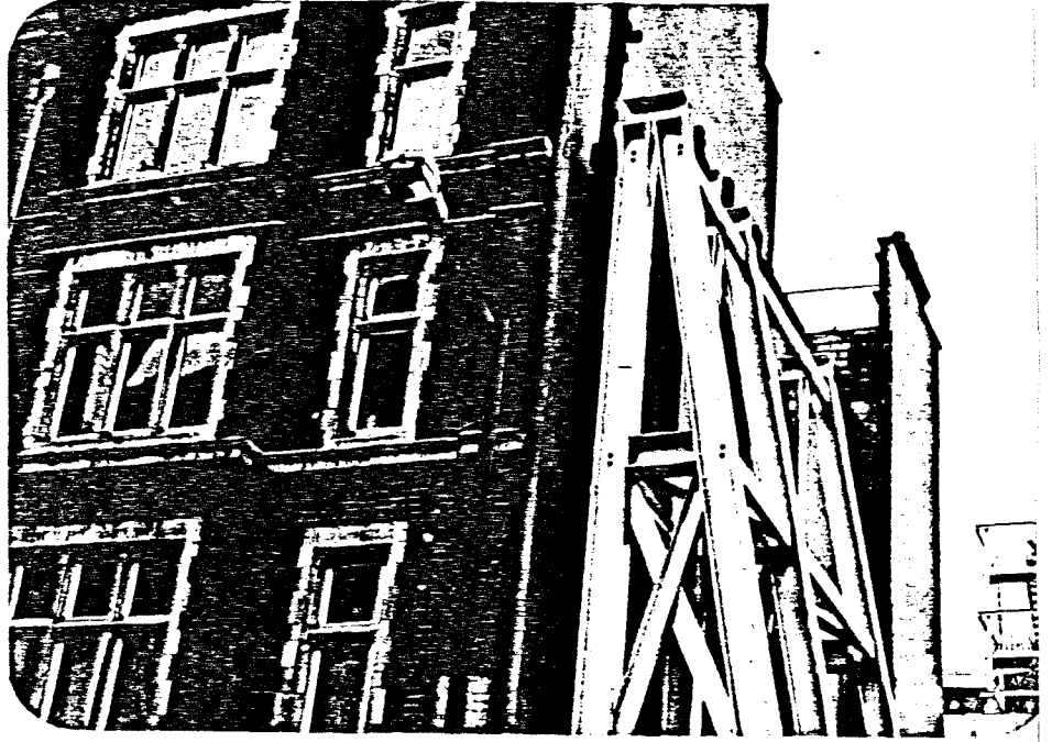
Resim 101 -Binanın Desteklenmesi
