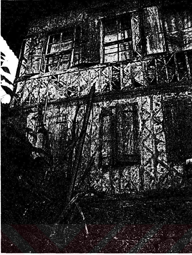
Resim 36 : Muskalı Dolma Sistem
