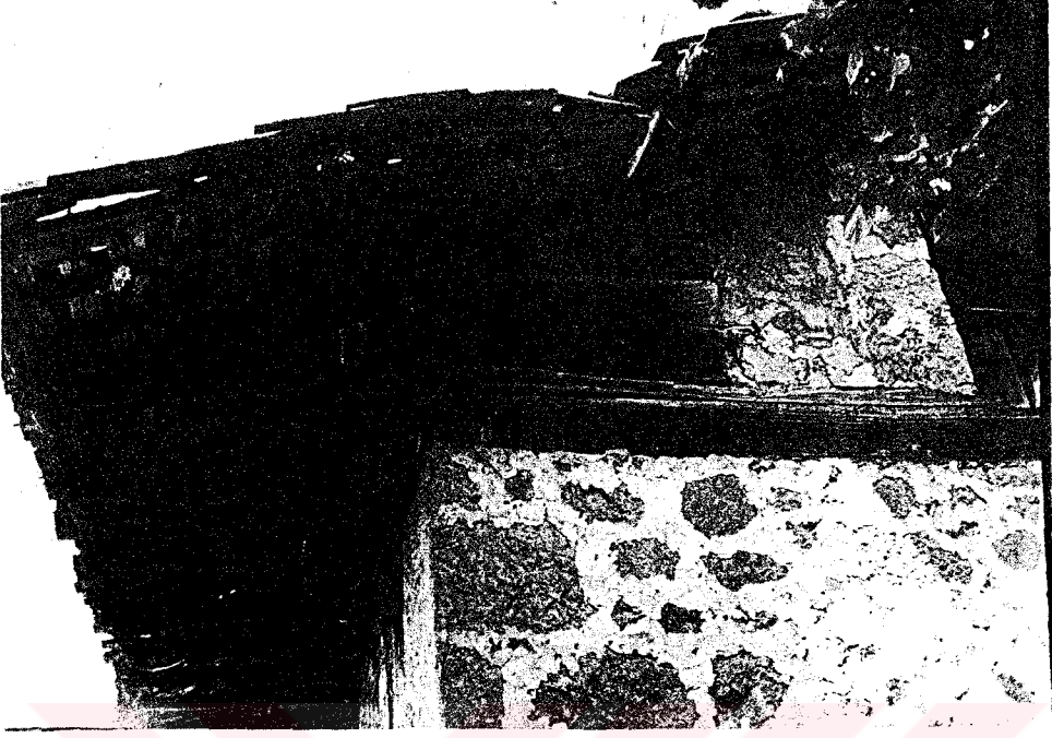
Resim 55 : Sacak Taş Duvar Birleşimi
