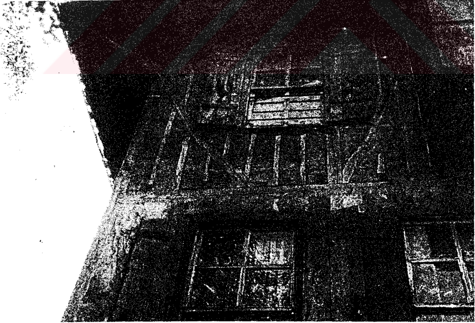
Resim 56 : Köşe Direğine Saplanmış "Yanğalma" (Payanda)
