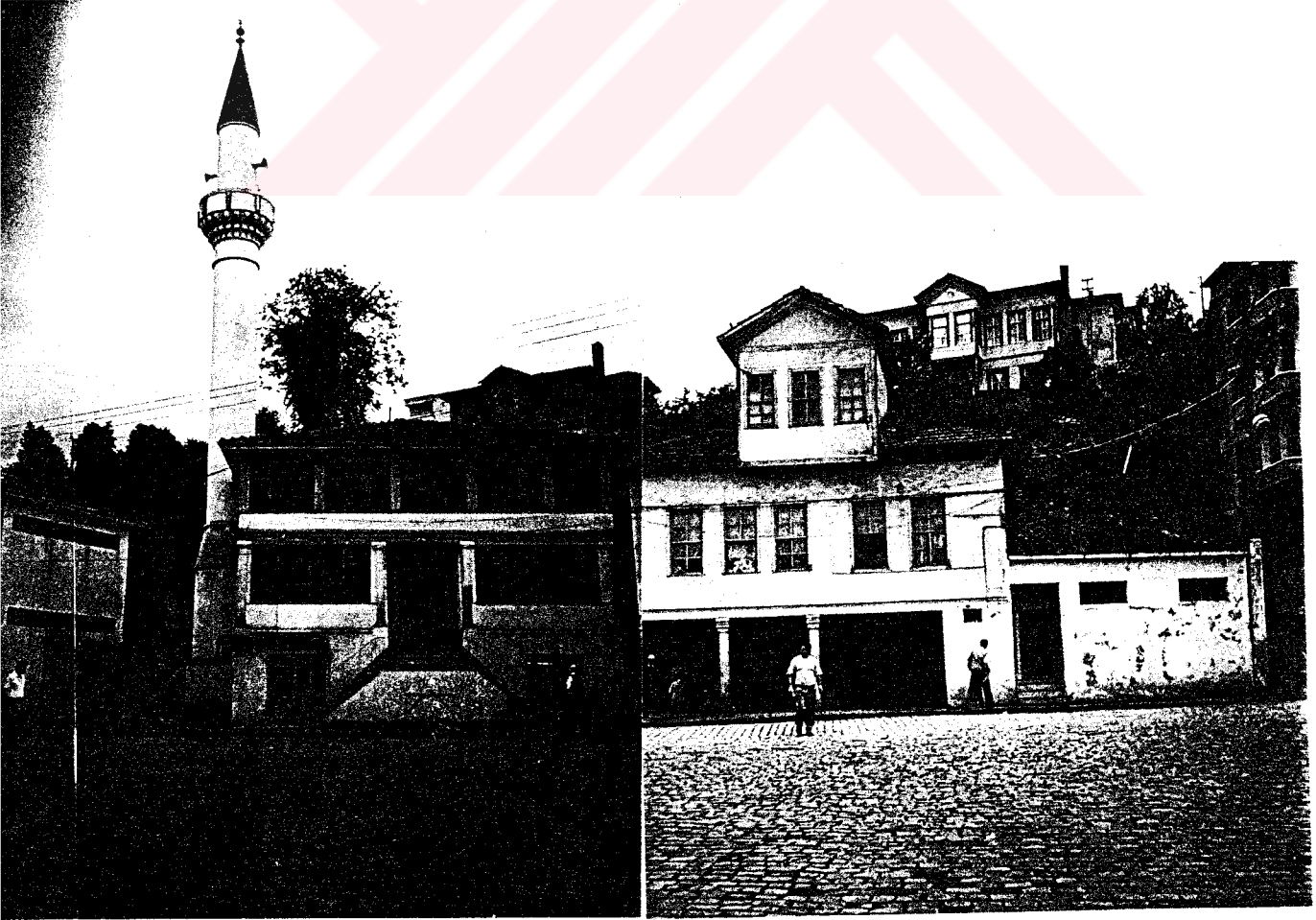
Resim 11: Yarga Mahallesi'nde "Eski Camii"
