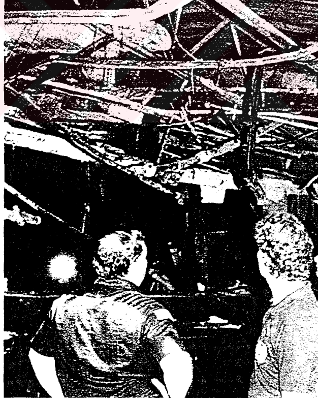
Resim 3.3 Yangının Taşıyıcı Sistemde Meydana Getirdiği Tahribat (Kaynak : Yangın ve Güvenlik Dergisi)
