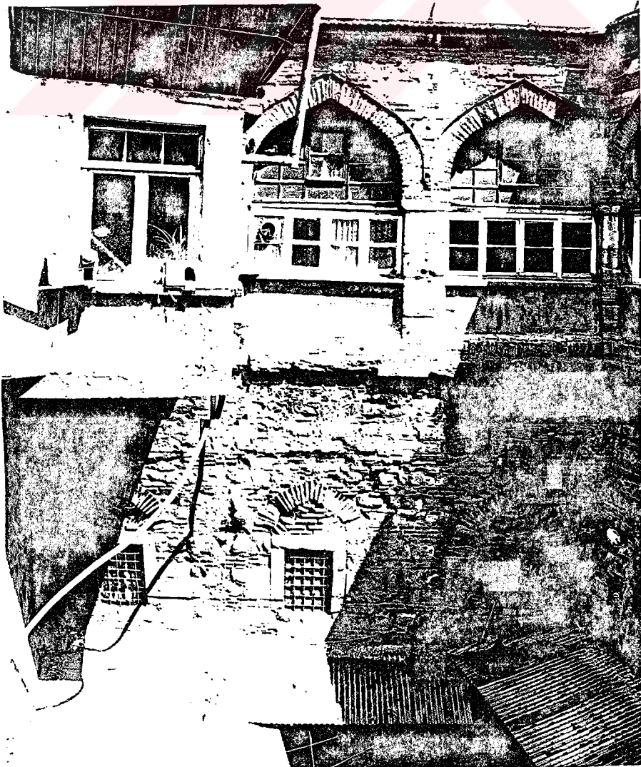
F.2. Yapıya eklenmiş konsol çıkma ( Büyük Çukur Han )
