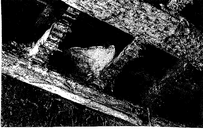
Nem etkisiyle mantarlanmış ahşap kirişler (Kuru çürüklük miselleri) (Desch, and Dinwoodie, 1996, s.243 ) ( Bölüm 2.3.4 )
