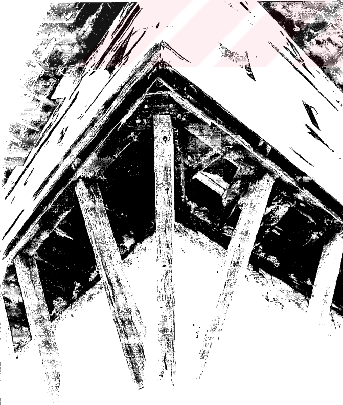
Duvarla birleşim noktası çatlamış ahşap payanda (Safranbolu ) ( Bölüm 2.3.2.12 )
