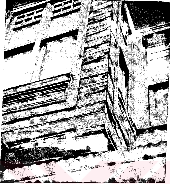
Nem etkisiyle zarar görmüş bir ahşap ev cumbası ( Yeldeğirmeni, Kadıköy ) ( Bölüm 3.1.1.1 )
