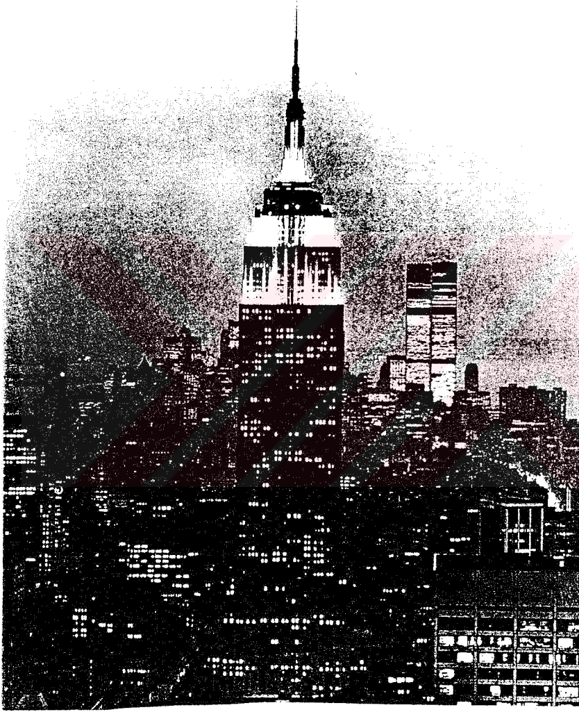
Şekil 2.11 Empire State Building 1931
