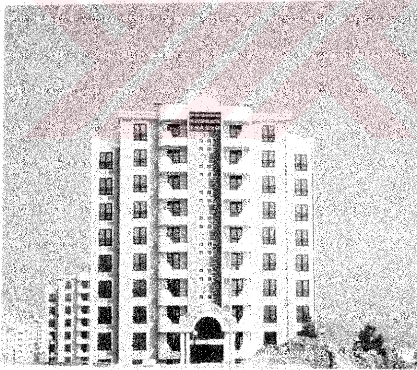
Şekil 4.2 ,4.3 Prekast betonarme giydirme sistem kullanılarak üretilen “Bahçeşehir Konutları”
