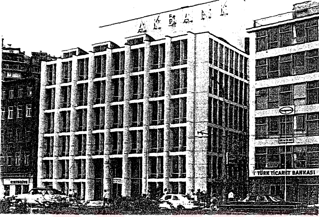
R.5.46. Akbank Genel Müdürlük Binası, Sedad Hakkı Eldem, İstanbul, 1970
