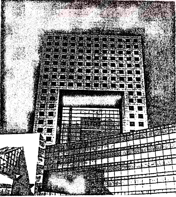
R.5.66. Torhaus Binası, Ungers, Frankfurt
