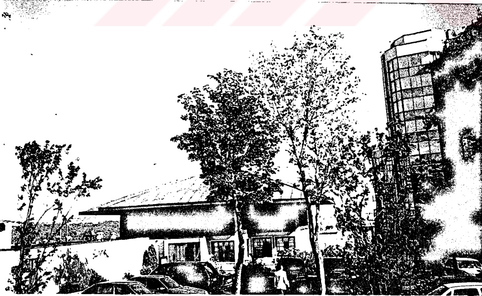
R.3.24. Taşlık Kahvesi, yıkıldıktan sonra yapılan yeni durumu
