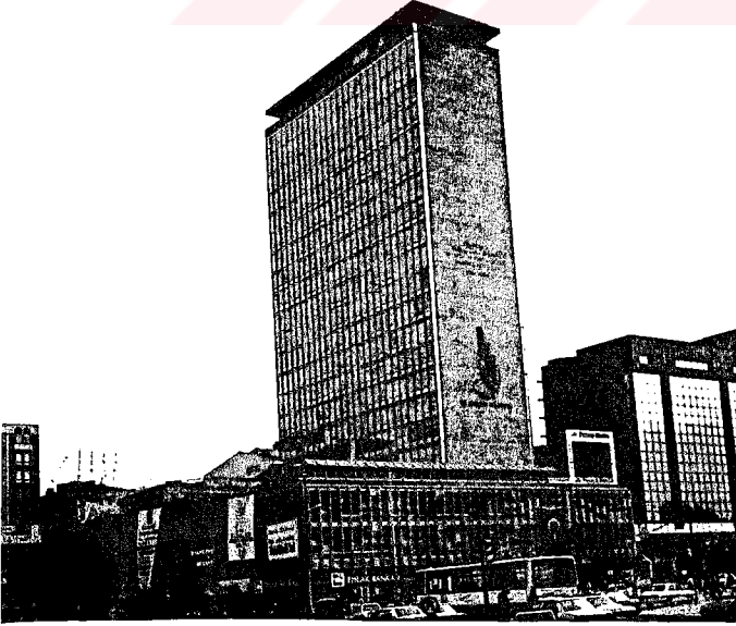
R.5.15. Kızılay İşhanı Emek Büro ve Çarşı Binası
