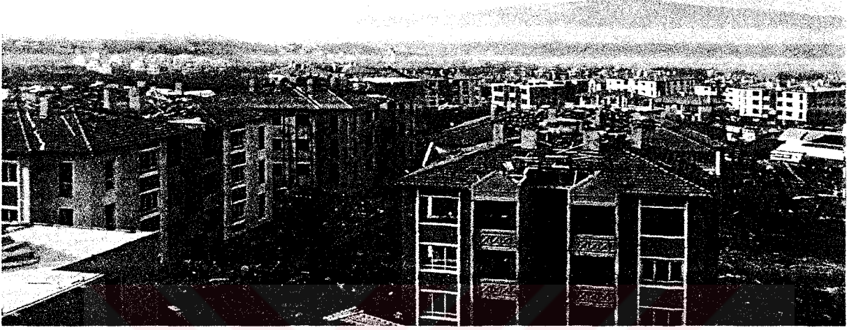
Şekil 6. 4 Konut yapımı devam ederken bölge durumu
