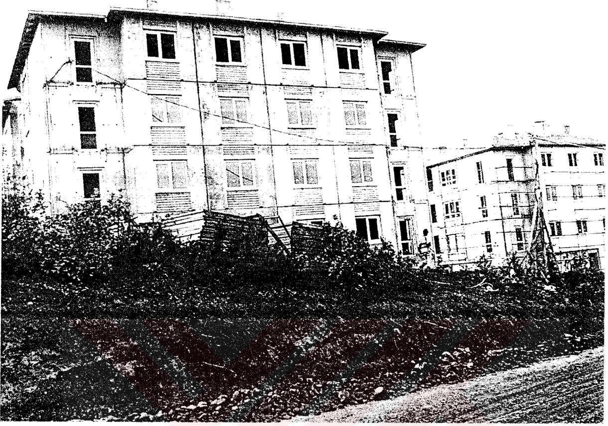
Şekil 6. 19 Binalarda doğramaların takılması aşaması
