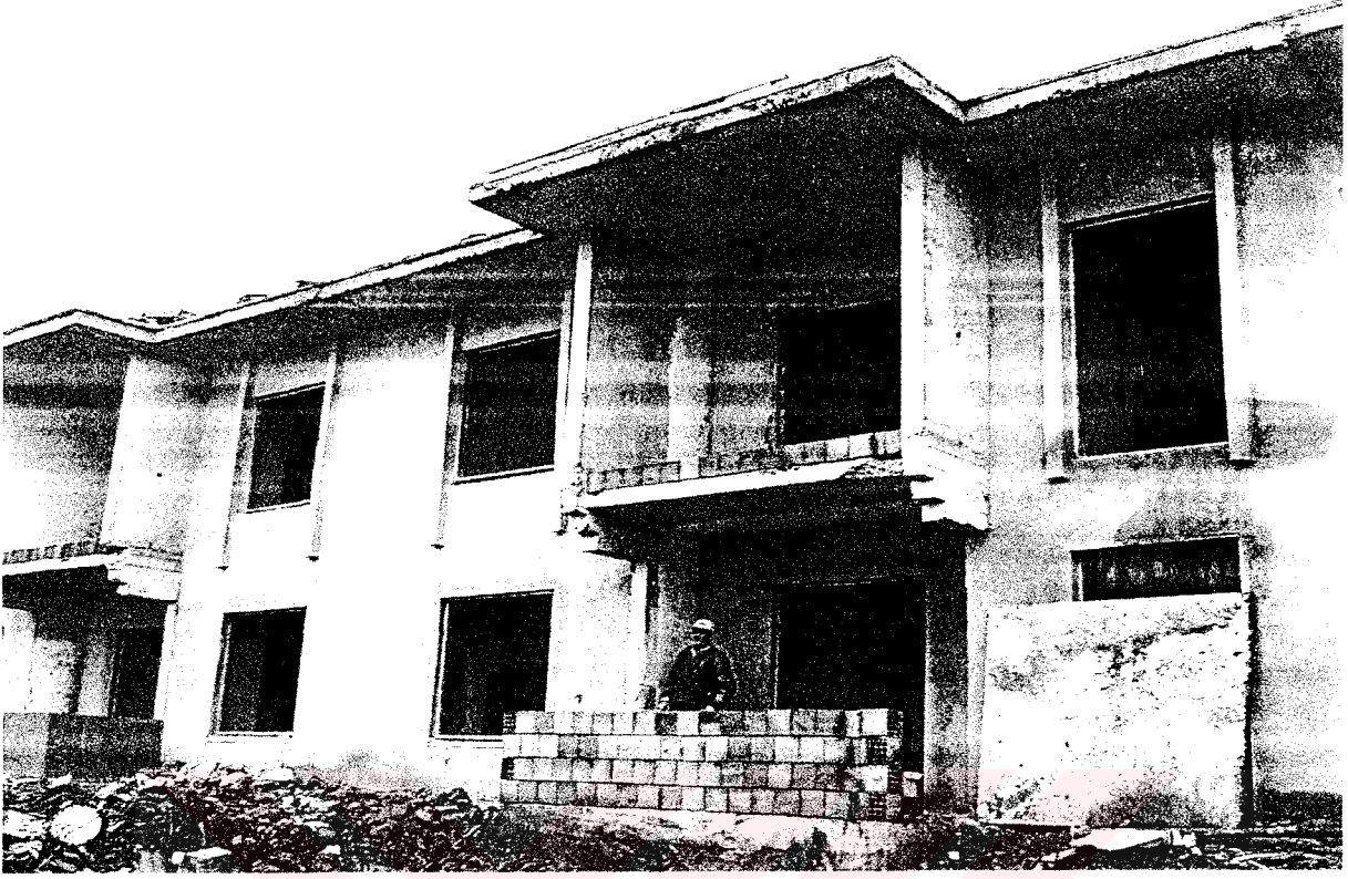
Şekil 6. 18 Binalarda tuğla malzeme kullanımı
