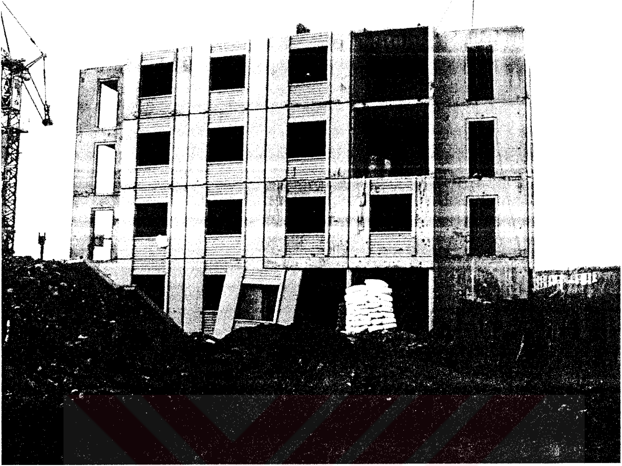
Şekil 6. 14 K4-1 tipi blokta cephe prekastı monte edilmiş durum
