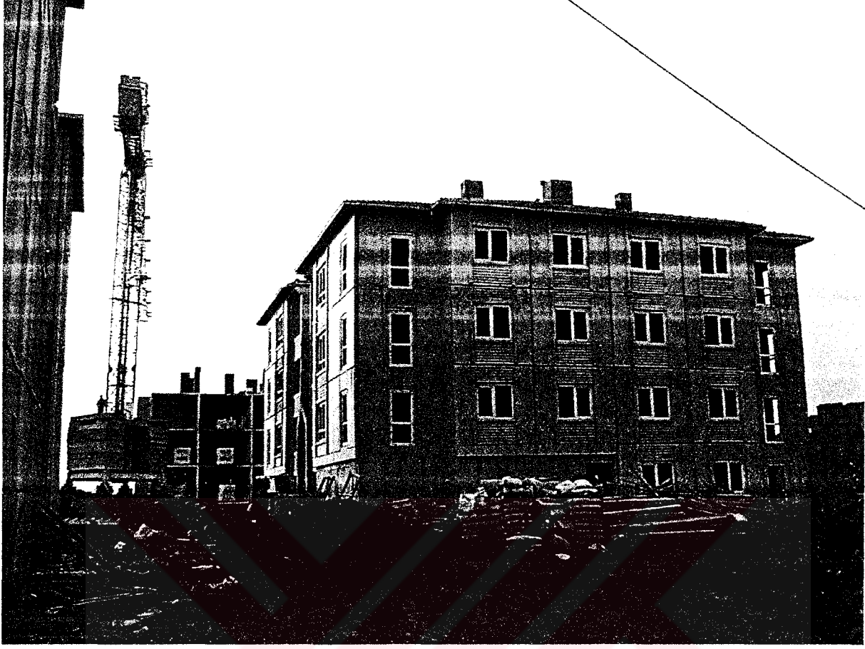
Şekil 6. 15 K4-1 tipi blokta cephe prekastları ve doğramalar takılmış durum
