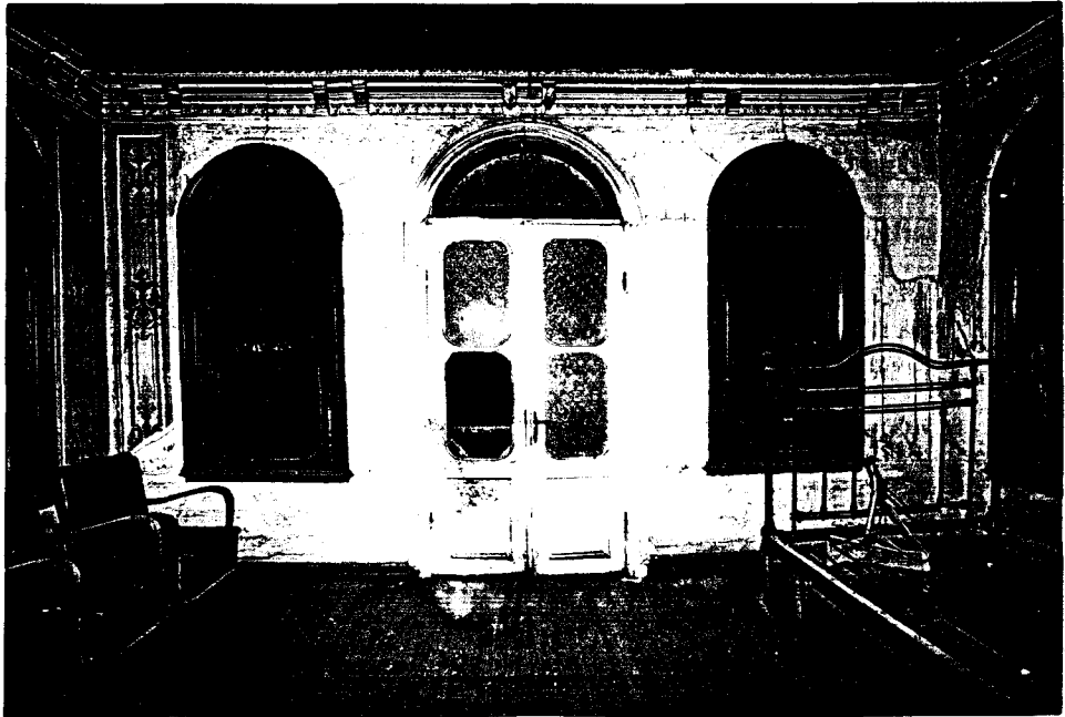
FOTO 1.30. Ç02. NOLU MEKANDAN TERASA ÇIKIŞ KAPI VE PENCERE İÇ GÖRÜNÜMÜ
