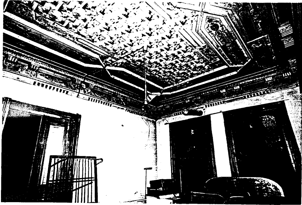
FOTO 1.16. 103 NOLU MEKANIN PENCERE VE TAVAN GÖRÜNÜMÜ
