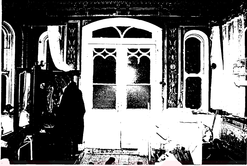
FOTO 1.1. ZEMİN KAT 1. NOLU MEKANDAN GİRİŞ KAPISI GÖRÜNÜMÜ
