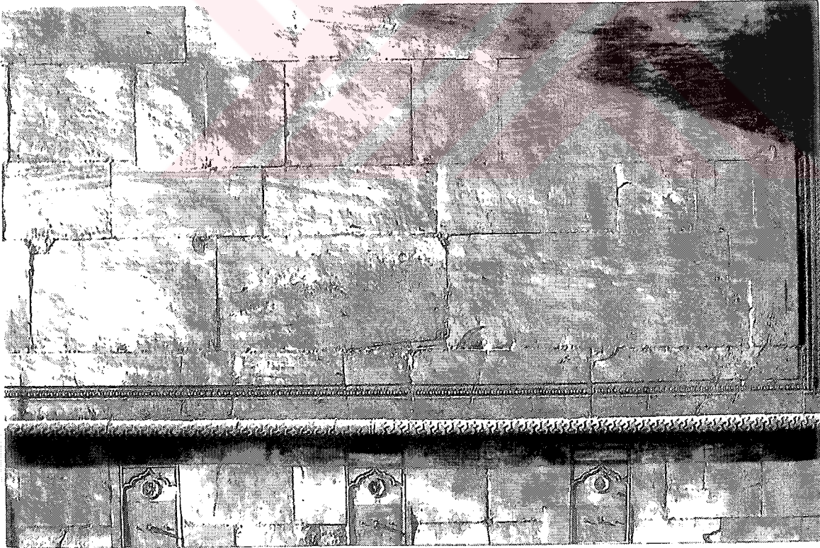
Resim 3. 7- Güneydoğu yan cephesinde kaplamalar ve abdest muslukları.
