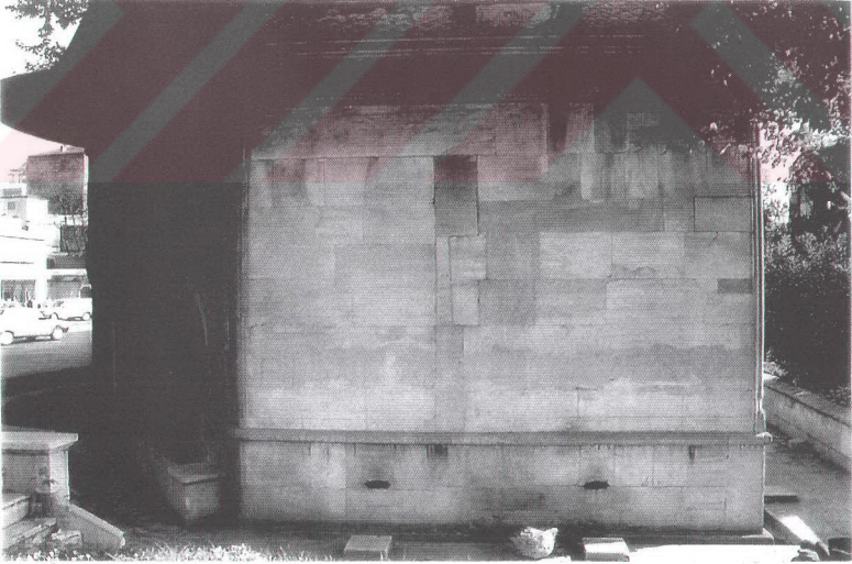
Resim 3. 46- Kuzeybatı yan cephesinde mermer kaplamalar ve yatay silme.
