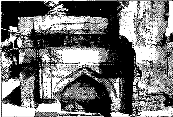
Resim 3. 14- Çeşmenin küfeki kaplamalı ön cephesi ve yanında su terazisi.
