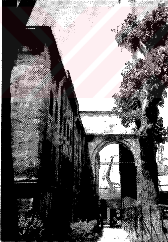
Resim 2.32-Azapkapı Camisi minaresine ulaşımı sağlayan geçit.
