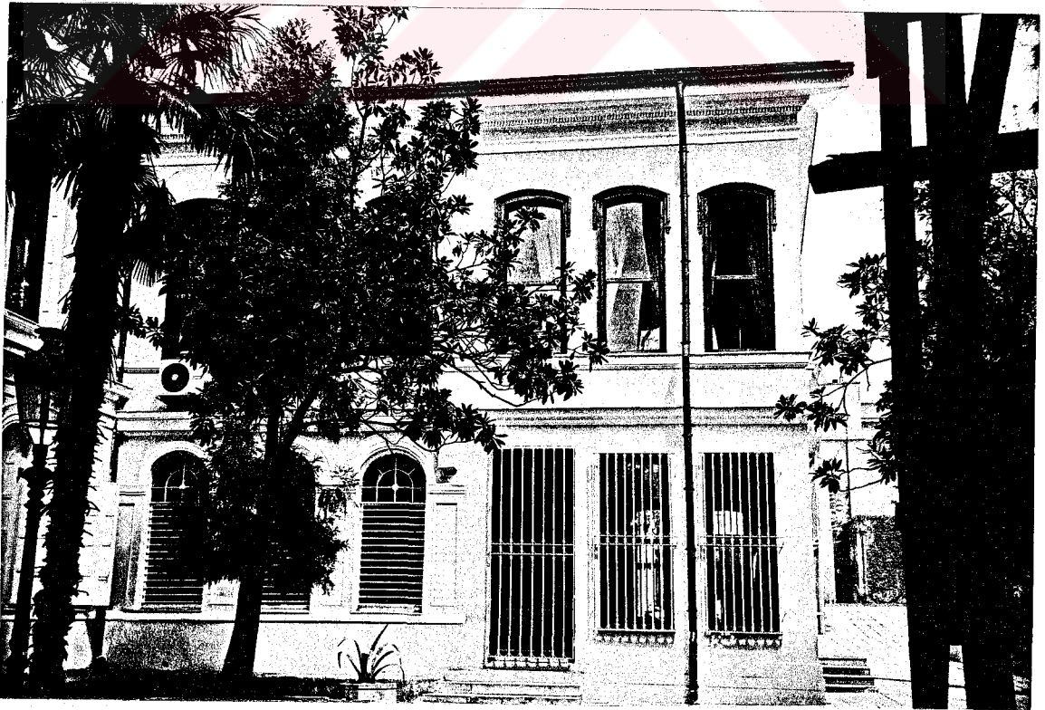
Resim 4.59 Binanın Güney Cephesi'nde geride kalan bölüm.
