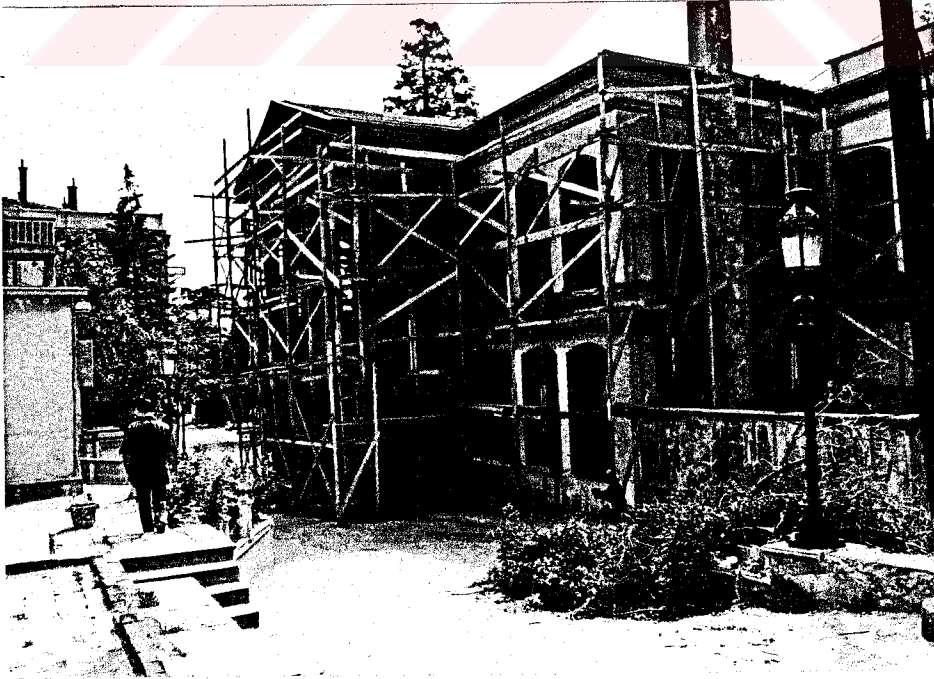
Resim 4.66 Restorasyon sırasında binanın arka cephesinden bir görünüş
