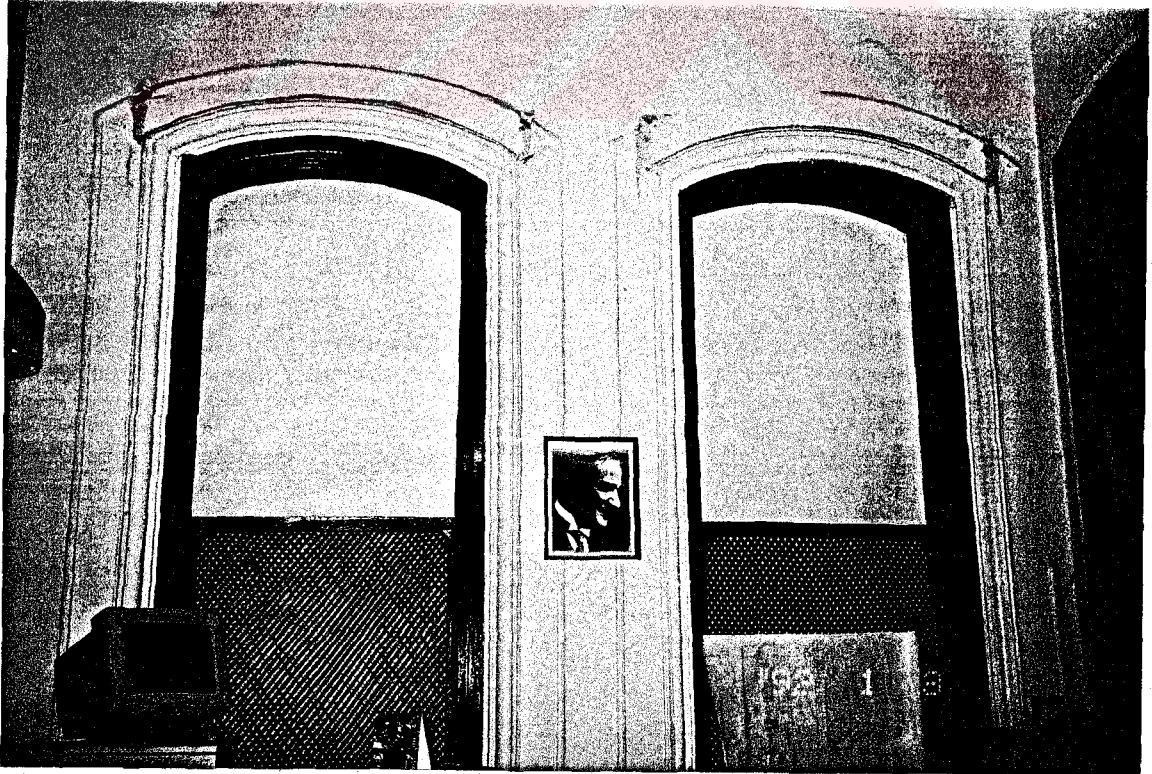
Resim 4.29 113 no'lu mekanın 115'e bitişik, sol yan duvarı.
