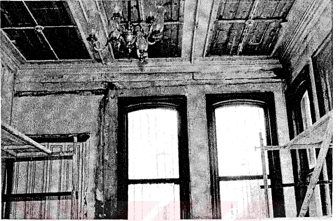
Resim 4.97 Restorasyon öncesinde Z08 no'lu mekanın durumu
