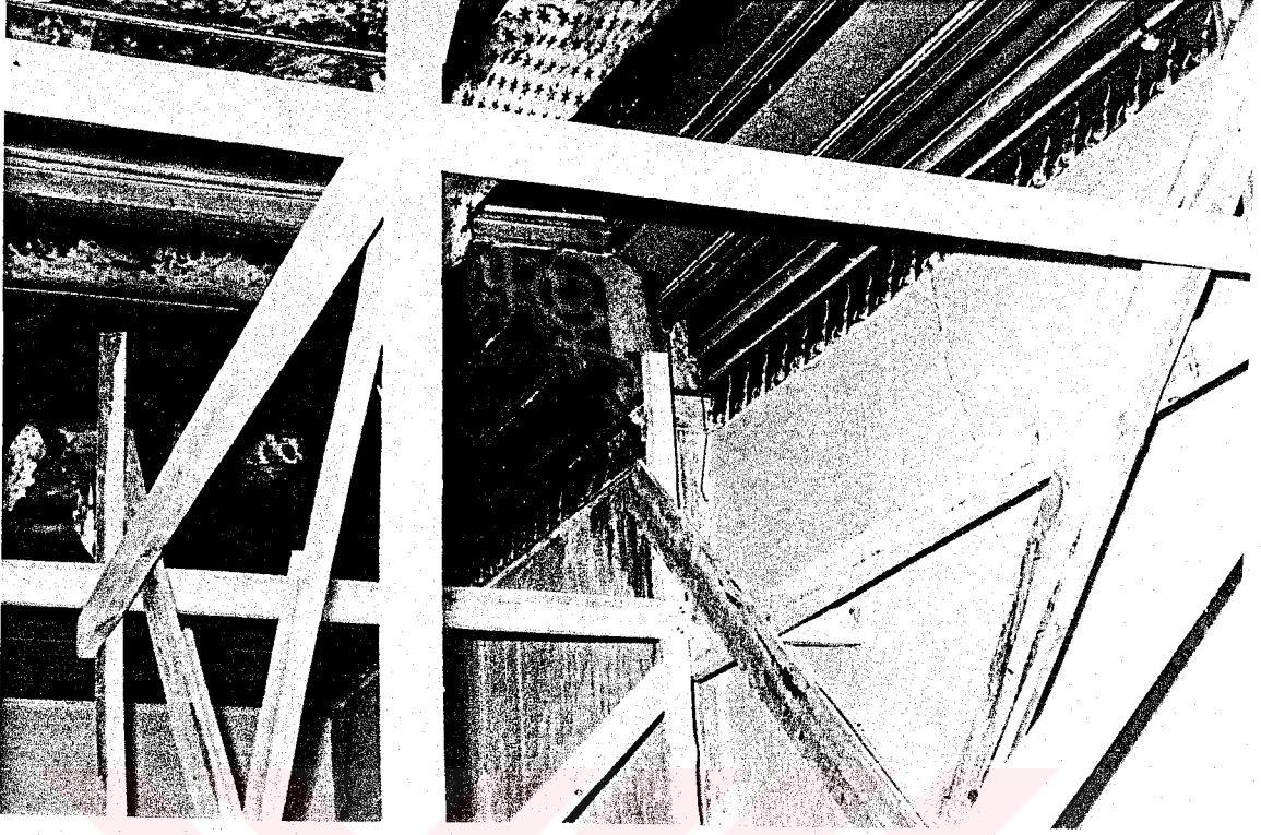
Resim 4.67 103 no'lu mekanda çökme olan kısım
