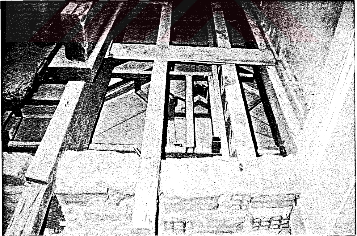
Resim 4.82 Restorasyon sırasında 102 no'lu mekan tavan sisteminin üstten görünüşü
