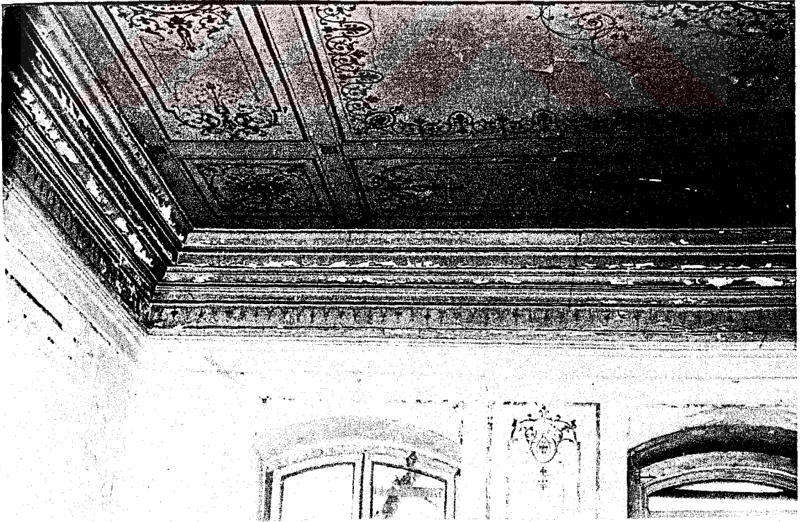
Resim 4.70 108 no'lu mekan restorasyon öncesinde
