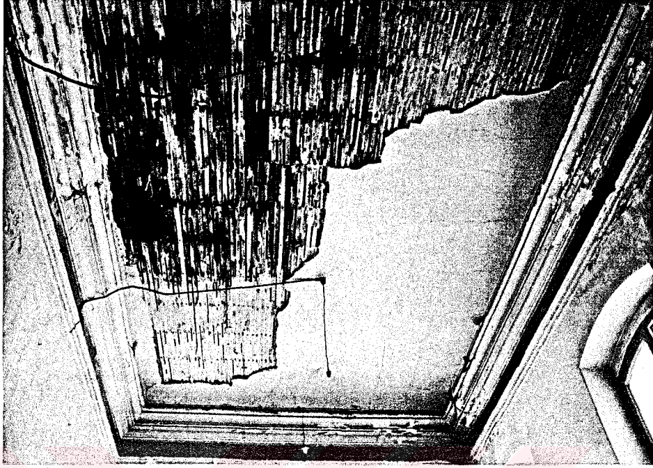
Resim 4.75 104 no'lu mekan restorasyon öncesinde
