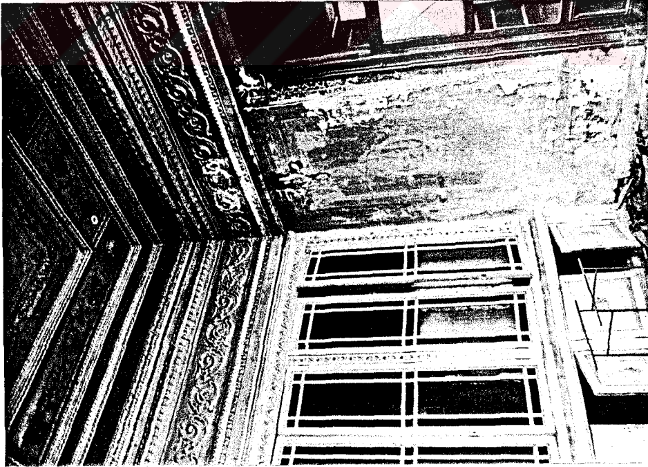
Resim 4.72 116 no'lu mekan restorasyon öncesinde
