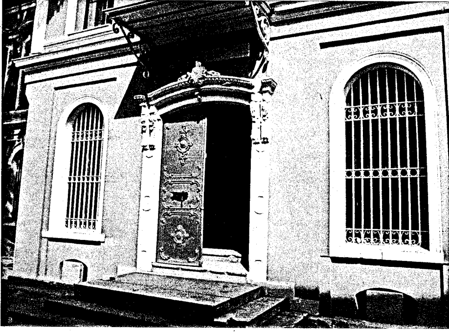
Resim 4.79 Restorasyon sonrasında ana giriş kapısı
