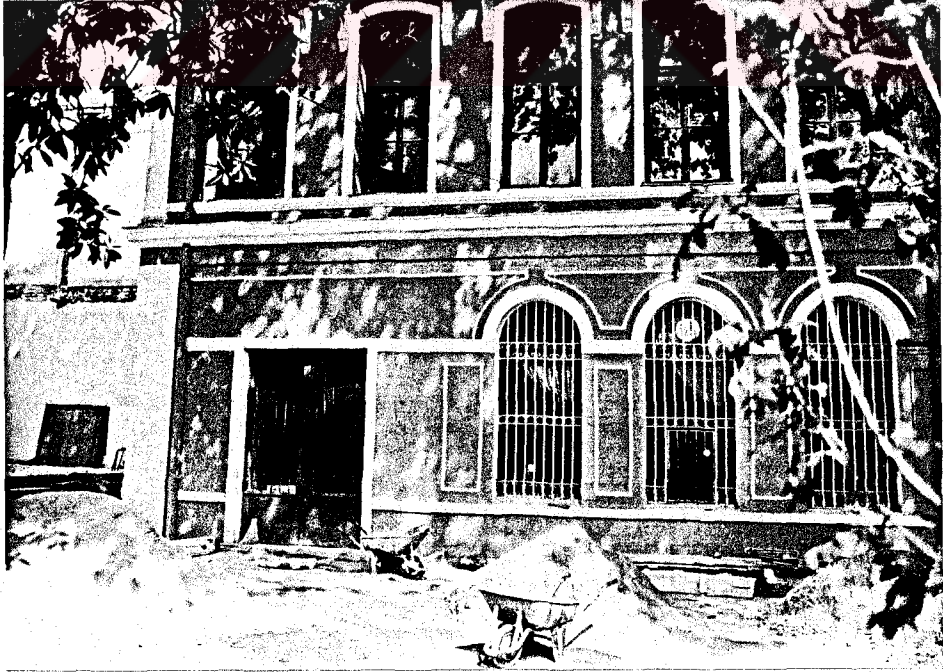
Resim 4.78 Restorasyon sonrasında Batı Cephesi'nden bir görünüş
