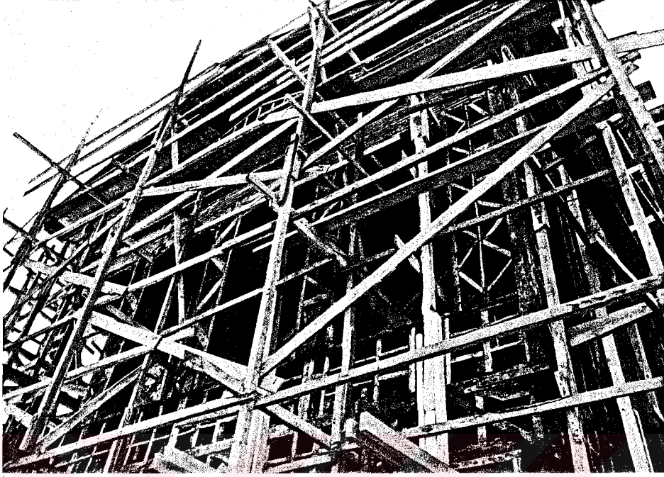
Resim 4.65 103 no'lu mekan dış cephesi restorasyon sırasında
