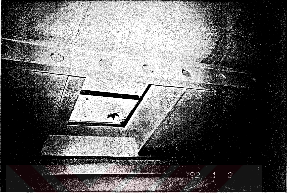
Resim 4.24 Çelik taşıyıcıli sistemle kapatılmış Z33 no'lu aydınlık mekanı.
