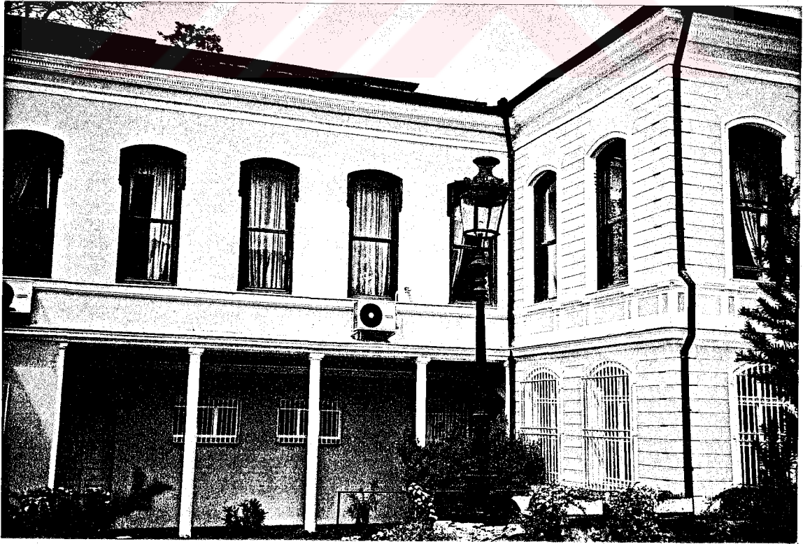
Resim 4.61 Binanın Doğu Cephesi'nde, ortada ve sağda bulunan farklı kısımların birleşimi.
