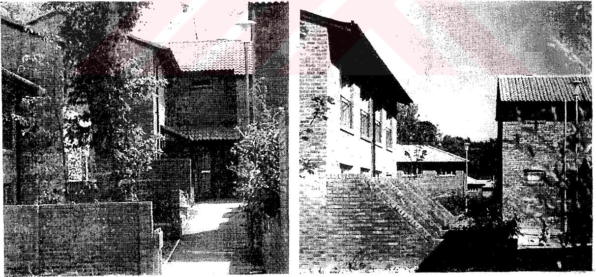
Şekil 7.13 Crawley-Broadfield'de konut fotoğrafları
