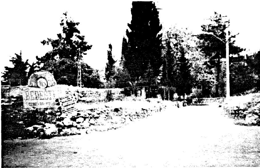
řekil 5.15 Hisariçi Mahallesi'nde Parsel Duvarlarının ve Tabelaların Durumu
