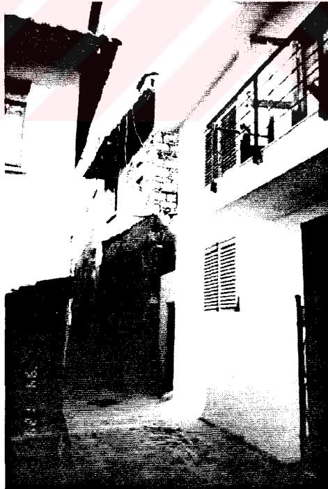
Şekil 5.2 Antalya Kaleiçi’nde Varolan Yapı Yoğunluğunu Aşan ve Mimari Bütünlüğünü Bozan Yenileme Çalışmaları
