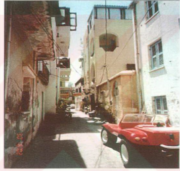
Şekil 4.19 Ek Katlar Çıkılan Binalar
