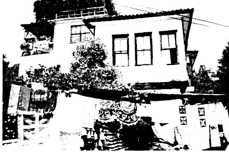
Şekil 5.3 Alanya'da Hisariçi Mahallesi'nde Yapının Orijinal Durumuna Uymayan Ek Yapılar
