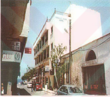
Şekil 4.18 Birleştirilen Parselde Yer Alan Otel
