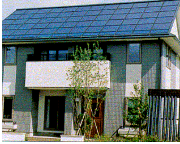
Şekil 3.37 Çatıda uygulanmış fotovoltaik paneller [22]
