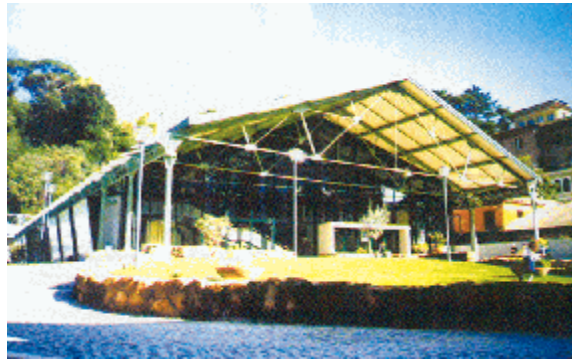
Şekil 3.8 Giriş (batı) cephesi (Altın, 2003)
