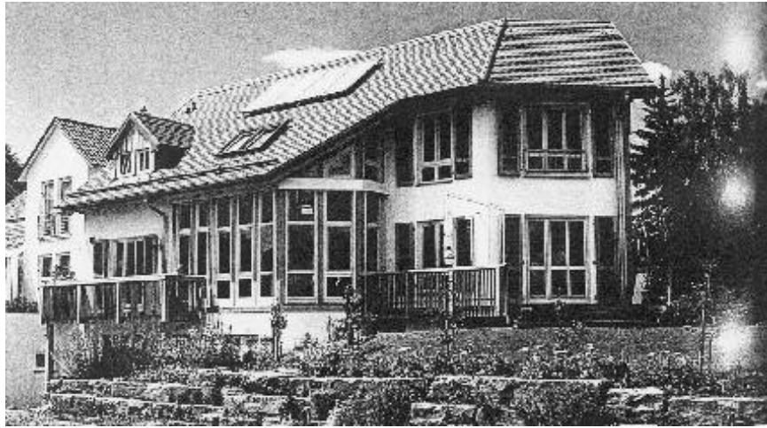
Şekil 3.75 Güneydoğu cephesi, Hacker evi (Akman, 1999)
