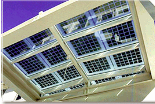
Şekil 3.39 Tepe ışıklığı olarak kullanılan fotovoltaik paneller [25]
