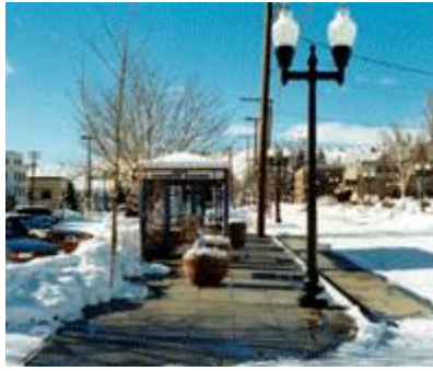
Şekil 3.42 Kaldırımlardaki karların jeotermal ısıtma ile eritilmesi, Oregon [28]
