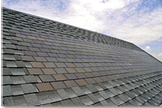
Şekil 3.38 Asfalt görünümünde fotovoltaik çatı kaplaması [24]
