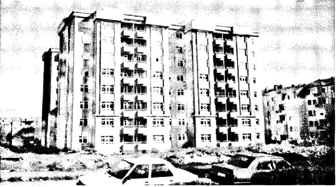
Şekil 4.38 Barışkent II Toplu Konutu'nun üretim aşamasındaki durumu
