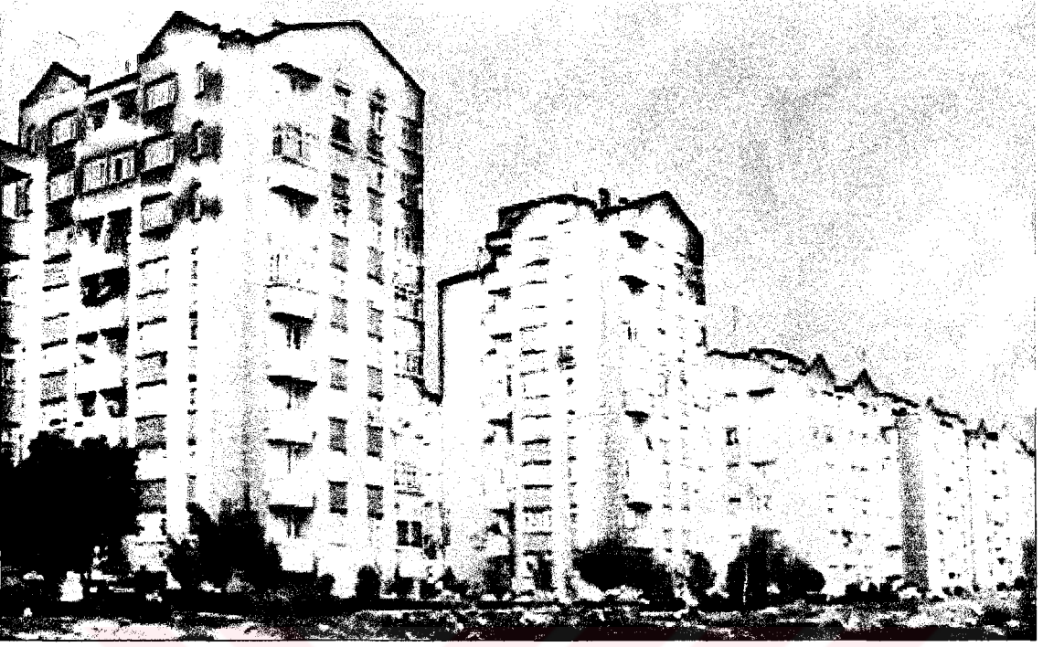
Şekil 3.28 Barışkent I Toplu Konutu fotoğrafı
