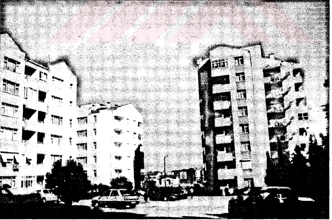
Şekil 3.31 Barışkent I Toplu Konutu fotoğrafı
