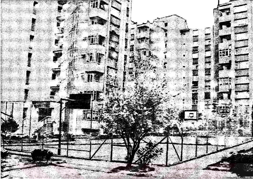
Şekil 3.34 Barışkent I Toplu Konutu fotoğrafı
