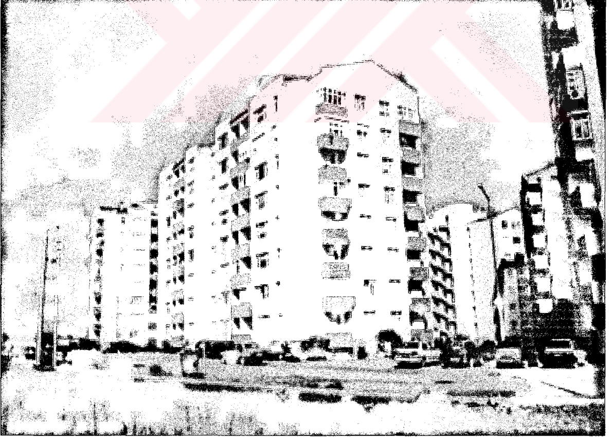
Şekil 3.29 Barışkent I Toplu Konutu fotoğrafı
