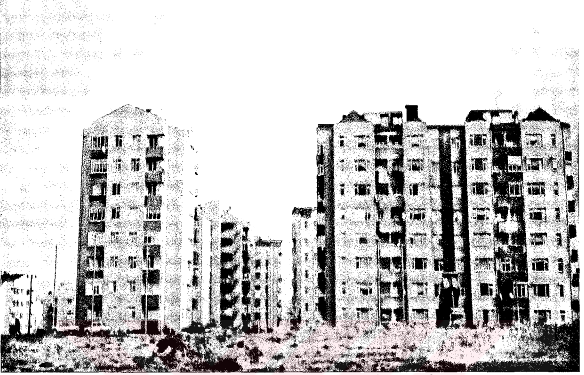
Şekil 3.30 Barışkent I Toplu Konutu fotoğrafı
