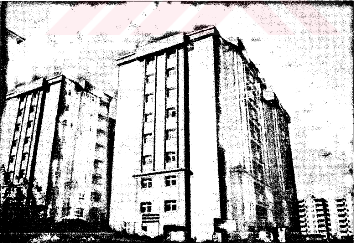
Şekil 4.37 Barışkent II Toplu Konutu'nun üretim aşamasındaki durumu
