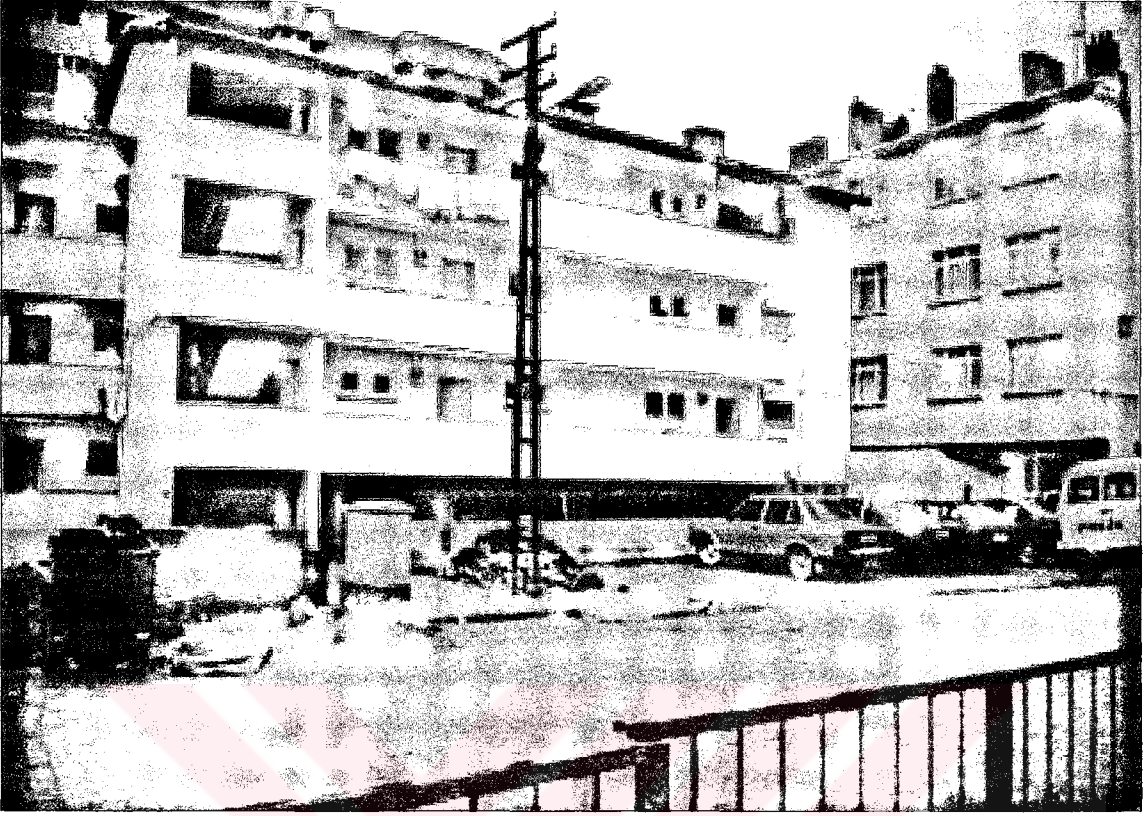
Şekil 3.6 54 Evler Toplu Konutu'na ait farklı renkte boyanmış diğer bloğun fotoğrafı
