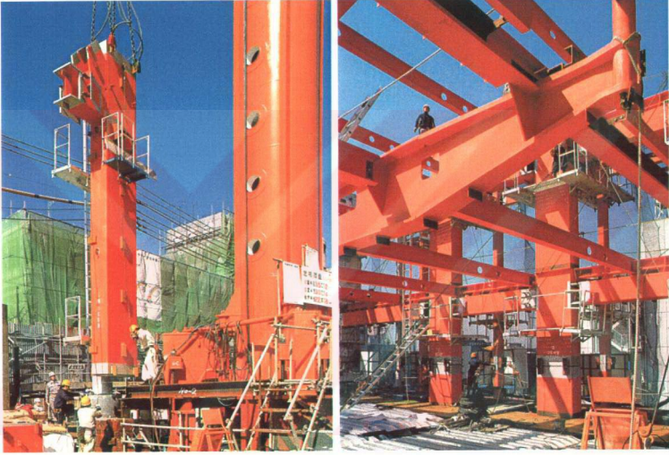
Şekil 3.36 EBF kolonları, MRF kolonları ve asma kat strüktürü (Davies, 1992)
