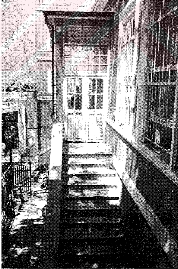
Resim 4.13 Batı Cephesi, rüzgarlık giriş kapısı.
