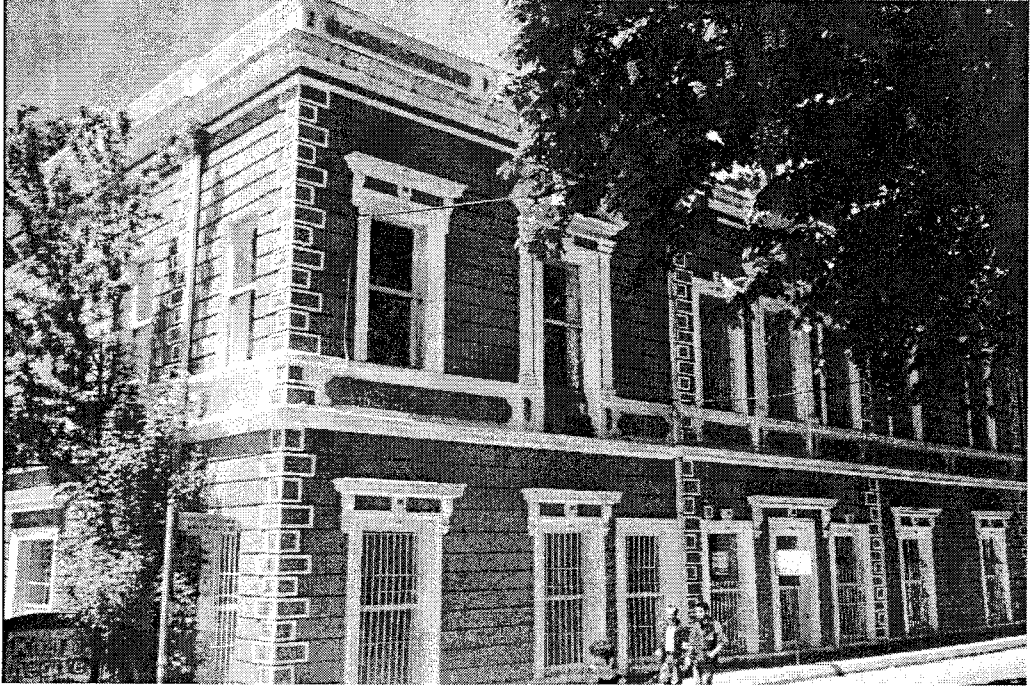
Resim 4.27 Doğu Cephesi – güney bölümü.
