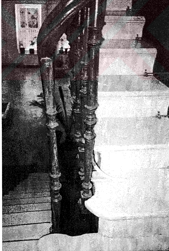
Resim 4.38 Z 14 no' lu mekandaki ahşap merdiven basamak + küpeşte + korkuluk detayı.
