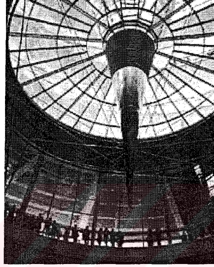
Şekil 3.20 Alman Parlamento Binası, havalandırma konisi [13]
