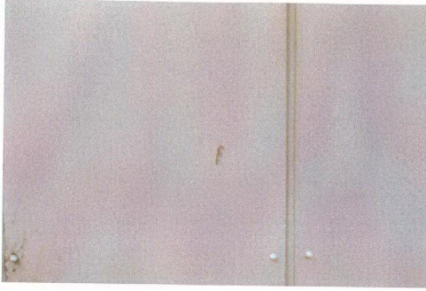
Şekil 4.11 Alüminyum levha kaplama üzerinde kullanıcı hataları nedeniyle oluşan sorun
