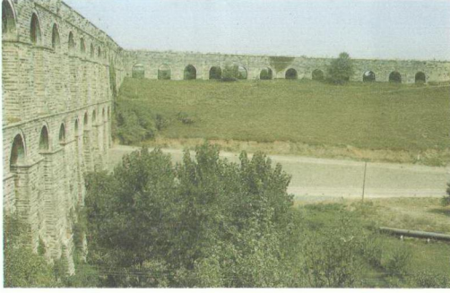
Şekil 5.2 Eğrikemer’de plan düzlemindeki kırıklık (Çeçen, 1994)
