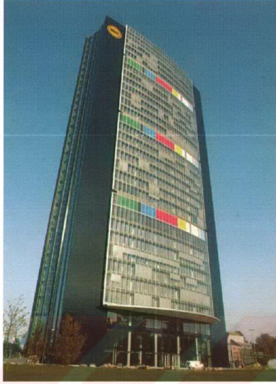
Şekil 5.44. Arag Binası genel görünüm [7]
