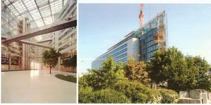
Şekil 5.17 Bina atriumu ve dış görünüşü [3]
