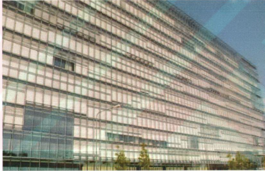
Şekil 5.19. Çift cam kabuk cephe [3]
