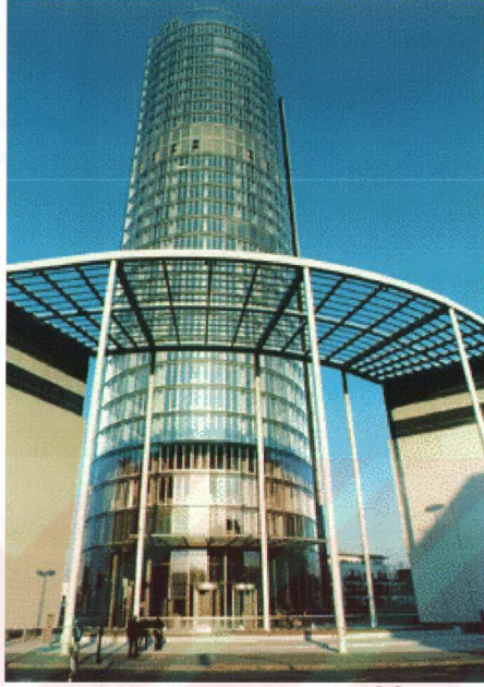
Şekil 5.26 RWE giriş cephesi [5]
