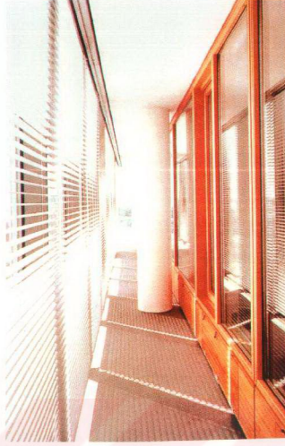
Şekil 5.41. Çift cephe ve aradaki koridor [6]
