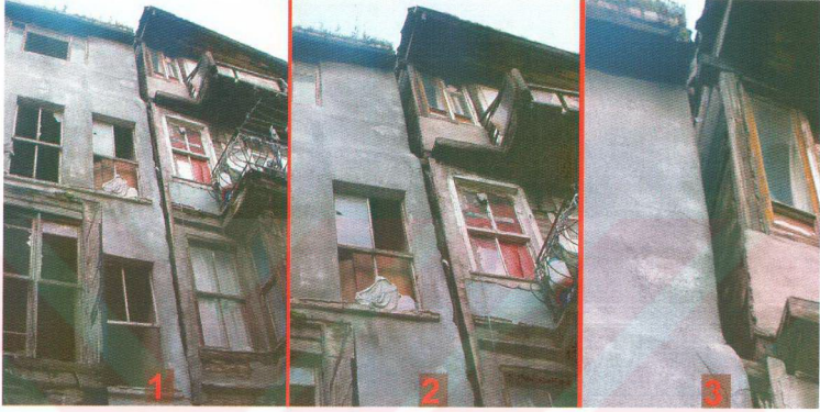
Şekil 4.1 Zemin oturmalarına bağlı olarak yapılardaki ayrılmalar
