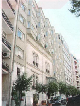
Şekil 5.13 Hüseyin Gerede Caddesi'nde birinci kuşak bir yapının üzerine sonradan eklenen ofis katları.
