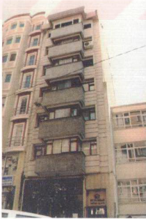
Şekil 5.33 Şakayık Sokak'ta bulunan apartmanın cephesi.
