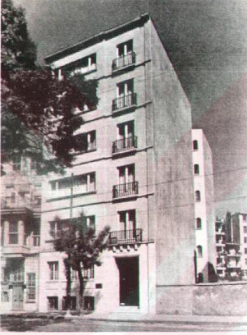
Şekil 3.40 Başaran Apartmanı Vali Konağı Caddesi'nden görünüş, (Arkitekt 1949, no. 3-4, s. 51-53)
