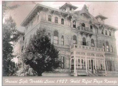
Şekil 2.25 Halil Rifat Paşa Köşkü’nün Şişli Terakki Lisesi’nin binasına dönüşmesi ( www.sisliterakki.org ).
