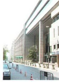
Şekil 5.18 Milli Reasürans Binası'nın ön cephesindeki boşluk.
