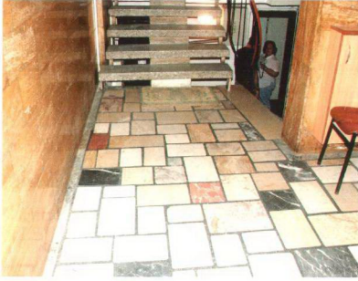
Şekil 4.32 Tayman Apartmanı'nın giriş holü.
