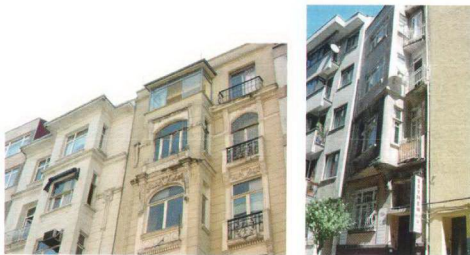
Şekil 4.11 Vali Konağı Caddesi'nde ve Hüsrev Gerede Caddesi yakınlarında kat ekleme örneği.
