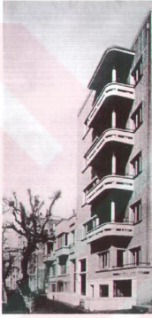
Şekil 3.34 Demirağ Kira Evi, Barıştiran Apartmanı Emlak Caddesi'nden görünüş, 1940 (Arkitekt, 1940, no. 1, s. 1-2).
