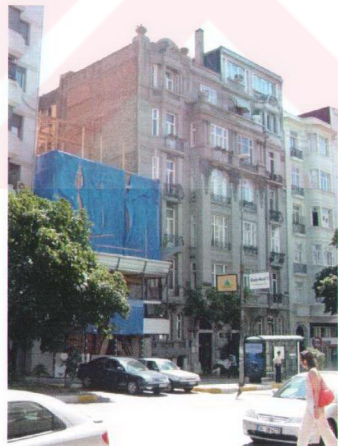
Şekil 5.27 Şeref Apartmanı'nın yıkılışı ve yanında bulunan birinci kuşak apartman-2004.
