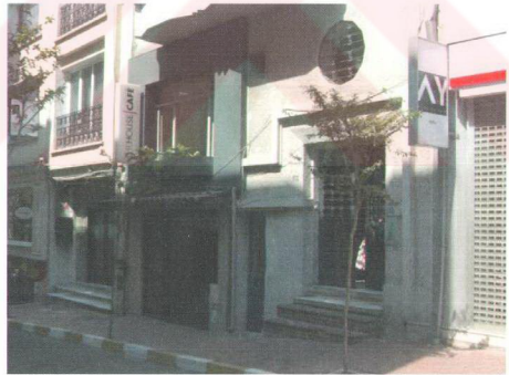
Şekil 5.10 İskeçe Apartmanı girişi, 2004. İlk iki kat dükkan ve kafeye dönmüştür.
