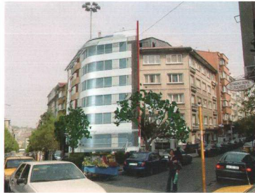
Şekil 5.37 Topağacı Meydanı'nda ikinci kuşak apartman, yıkılış süreci, boşalan parseli ve yerine yapılmakta olan apartmanın mevcut çevreye eklenmesinin dijital canlandırması.
