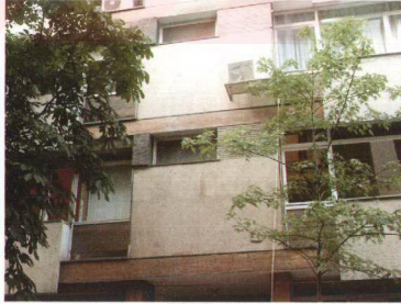
Şekil 4.22 Tayman Apartmanı cephe detayı.
