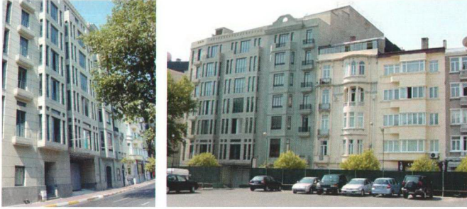
Şekil 5.23 İnayet Apartmanı'nın yanında yer alan ve şu an kullanılmayan gazete binası.
