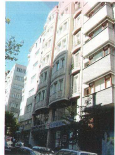
Şekil 5.35 Şakayık Sokak'ta bulunan başka bir apartmanın cephesi.
