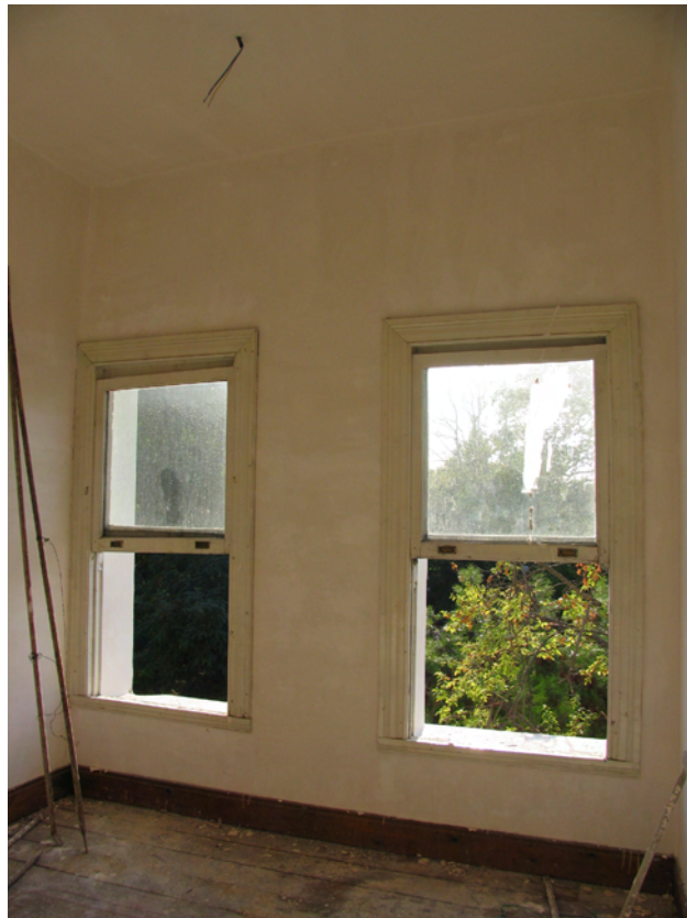
Resim 4.25 A-222 nolu mekan
