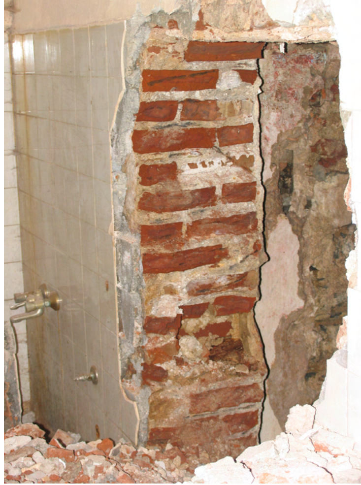
Resim 4.1 A-103 nolu mekandan duvar
