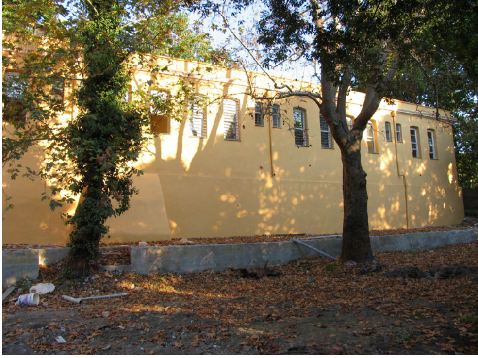
Resim 4.55 C Blok Batı Cephesi (restorasyon uygulaması sonrası fotoğrafı)
