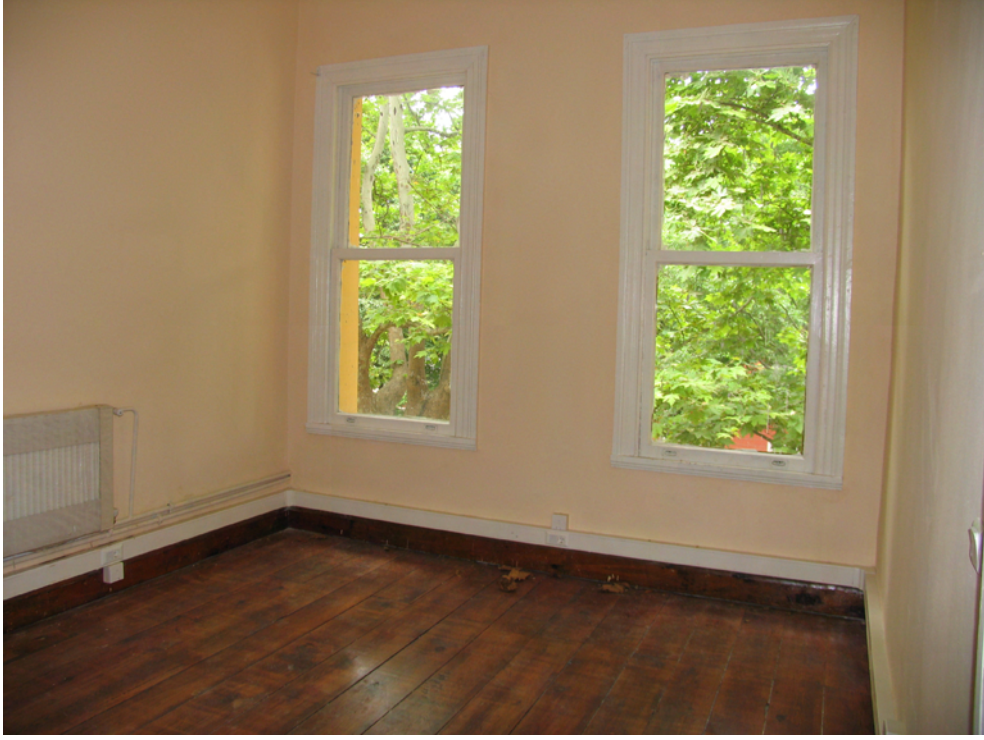
Resim 4.35 C-205 nolu mekan (restorasyon uygulaması sonrası fotoğrafıdır)
