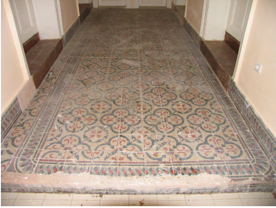
Resim 4.42 C-217 nolu mekana ait orjinal karo mozaik zemin kaplaması (restorasyon uygulaması sonrası fotoğraftır)
