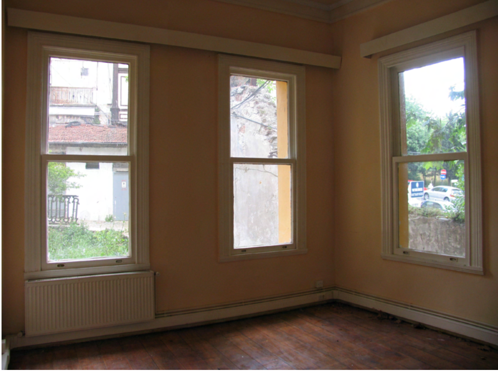
Resim 4.40 C-219 nolu mekan (restorasyon uygulaması sonrası fotoğrafıdır)
