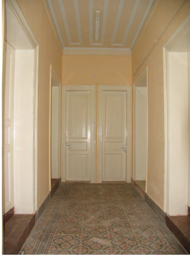
Resim 4.38 C-217 nolu mekan (restorasyon uygulaması sonrası fotoğraftır)
