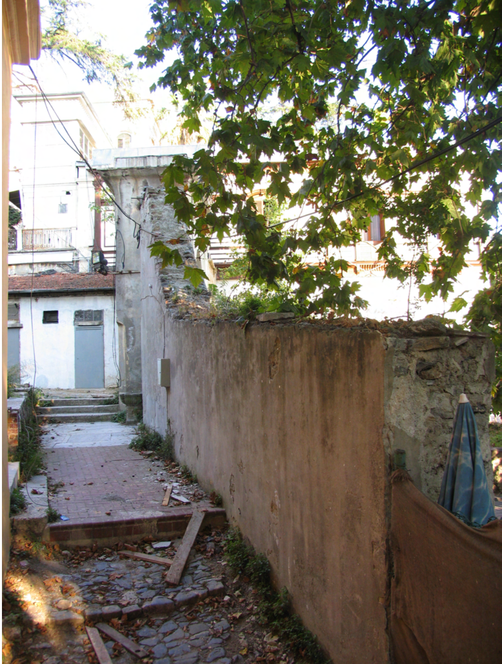
Resim 4.108 Güney Duvarı'nın Koltuk Kapısı yönü
