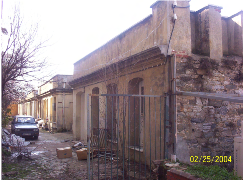
Resim 4.68 Kılar-ı Hümayun yapısı A ve B Bloklara ait doğu cephesi
