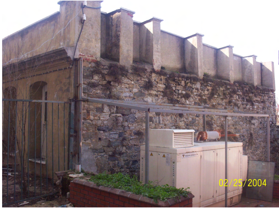
Resim 4.64 Kılar-ı Hümayun'a ait Kuzey cephesi
