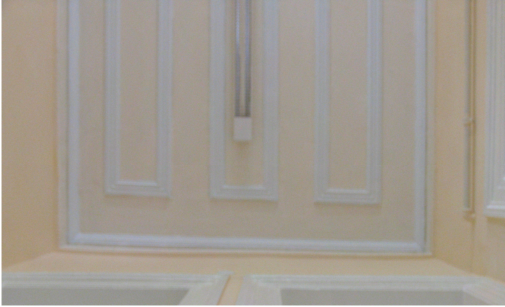
Resim 4.45 C-217 nolu mekanın tavan çitalarından detay (restorasyon uygulaması sonrası fotoğrafıdır)
