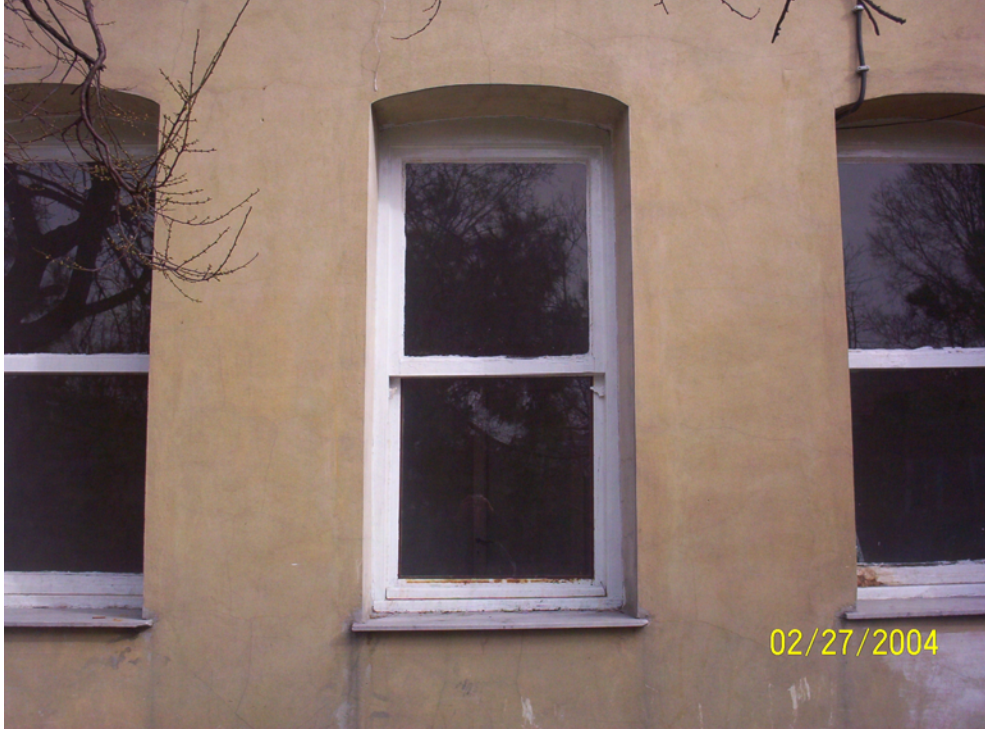
Resim 4.56 A Blok batı cephesinde yer alan kemer atkılı pencereler
