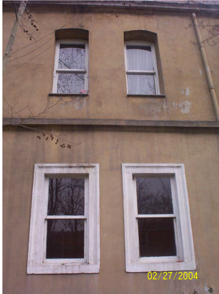
Resim 4.57 B Blok batı cephesinde yer alan düz atkılı ve kemer atkılı pencereler
