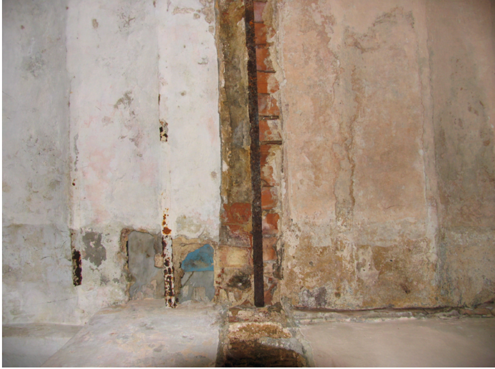
Resim 4.2 A-121 nolu mekandan volta döşeme tavan
