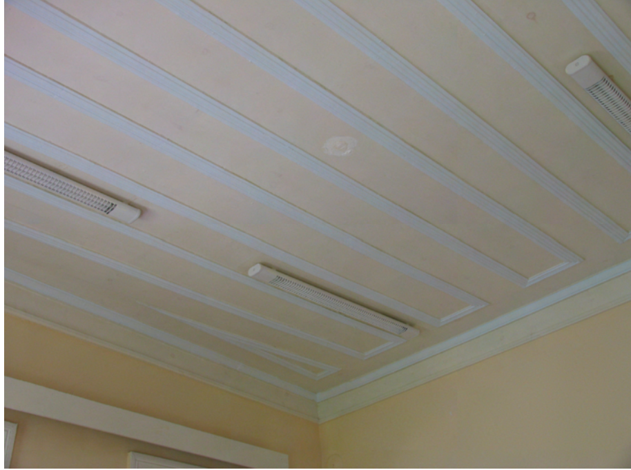
Resim 4.44 C-219 nolu mekana ait tavan kaplaması (restorasyon uygulaması sonrası fotoğraftır)
