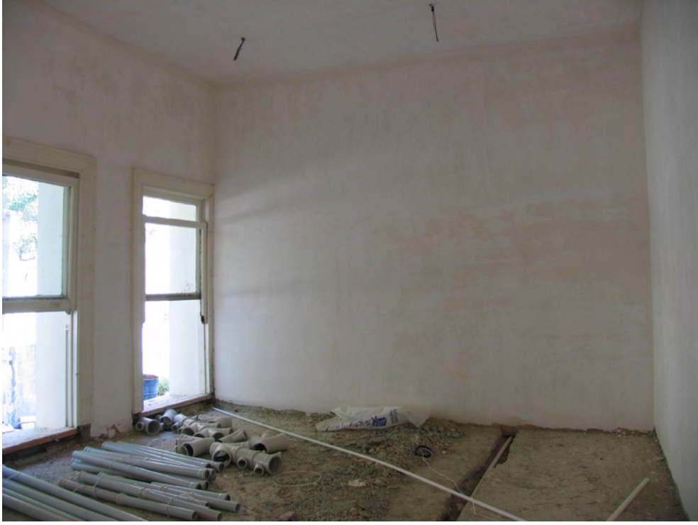
Resim 4.28 A-229 nolu mekan
