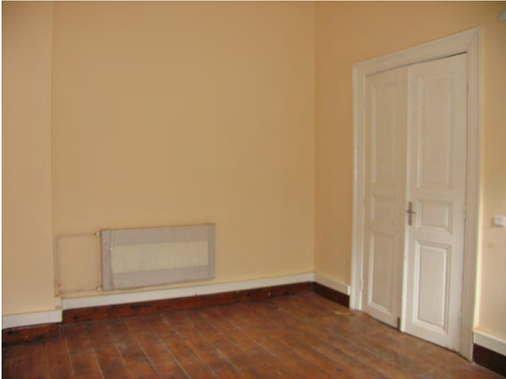
Resim 4.36 C-206 nolu mekan (restorasyon uygulaması sonrası fotoğrafıdır)
