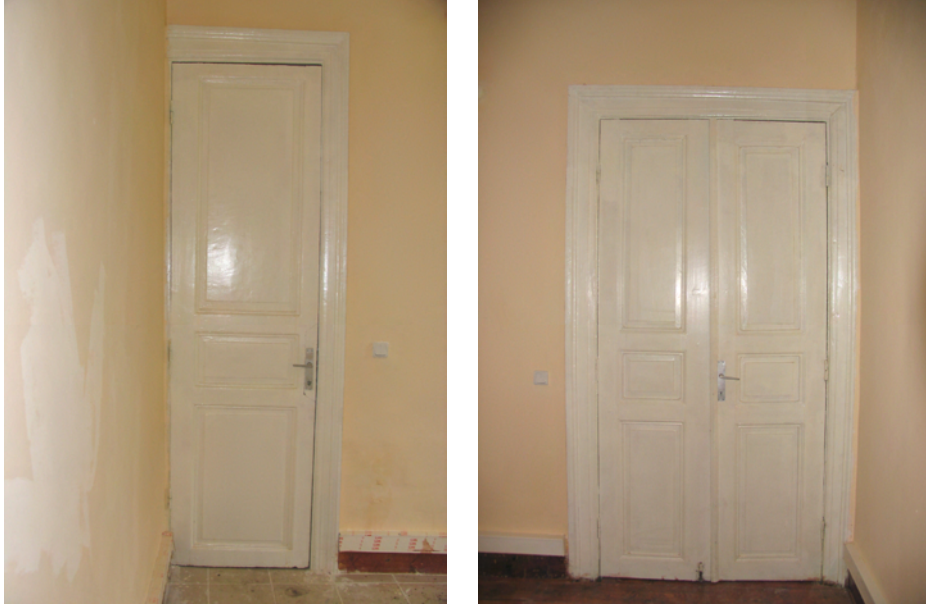
Resim 4.49 C Blok (C-201'e ait) tek kanatlı iç kapı (restorasyon uygulaması sonrası fotoğrafıdır)
