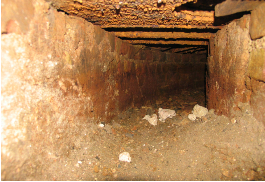
Resim 4.121 Duvarın dođu cephesinde Ađustos 2005'te yapılan kazı alıřması sonucu aıđa ıkarılan tuđla ile eperleri oluřturulmuř kanalın i grnm
