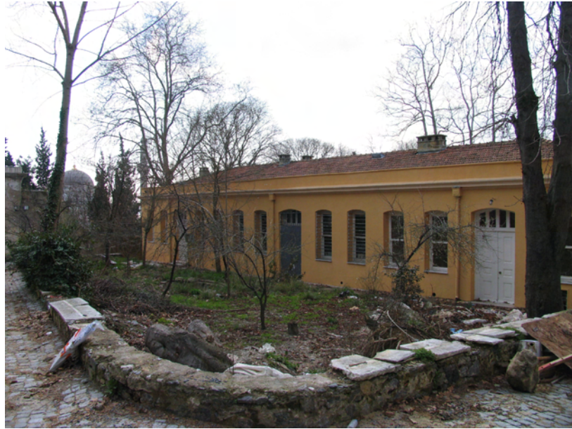
Resim 4.92 C Blok önünde yer alan bahçe
