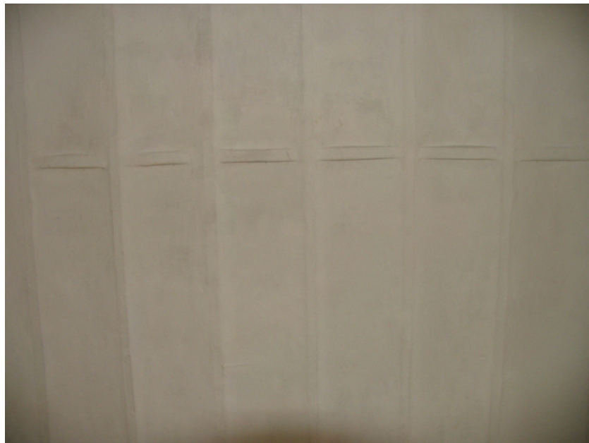
Resim 4.7 A-125 nolu hacmin tavanı; volta döşeme
