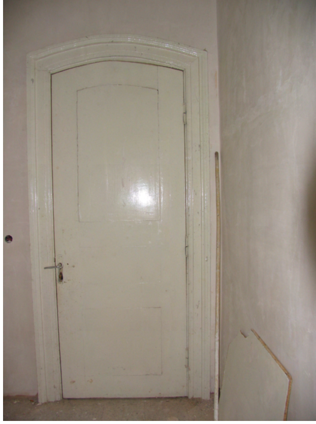
Resim 4.30 A- 208 nolu mekana ait dış kapı
