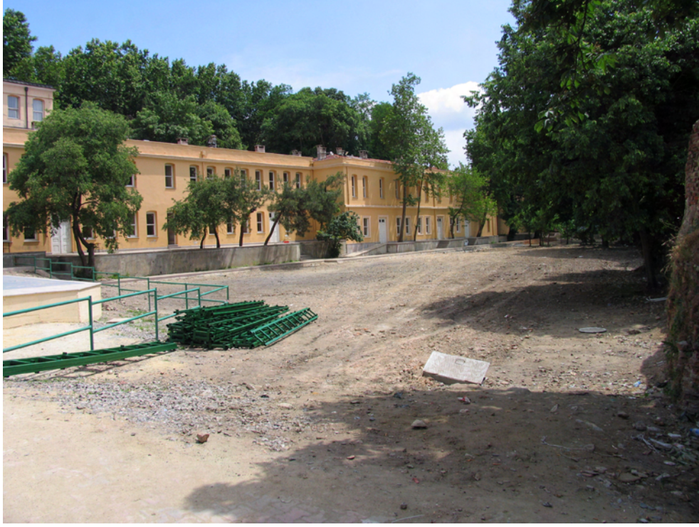
Resim 4.105 Batı bahçesinin restorasyon uygulaması ile düzeltilip konser alanı olarak düzenlenme çalışmaları
