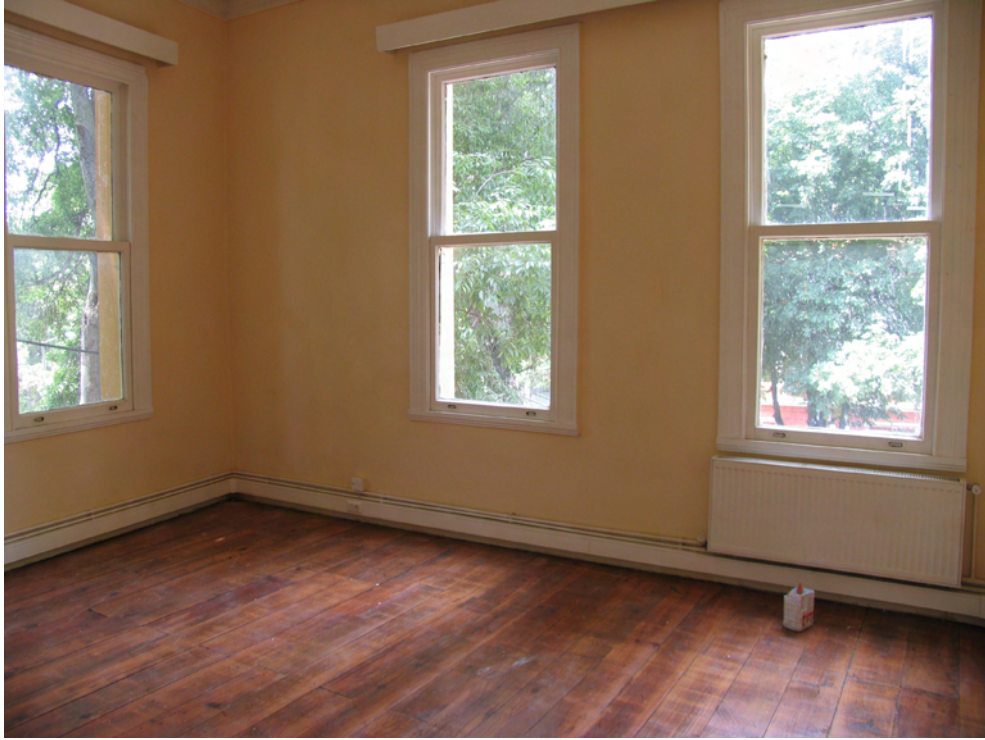
Resim 4.39 C-218 nolu mekan (restorasyon uygulaması sonrası fotoğrafı)
