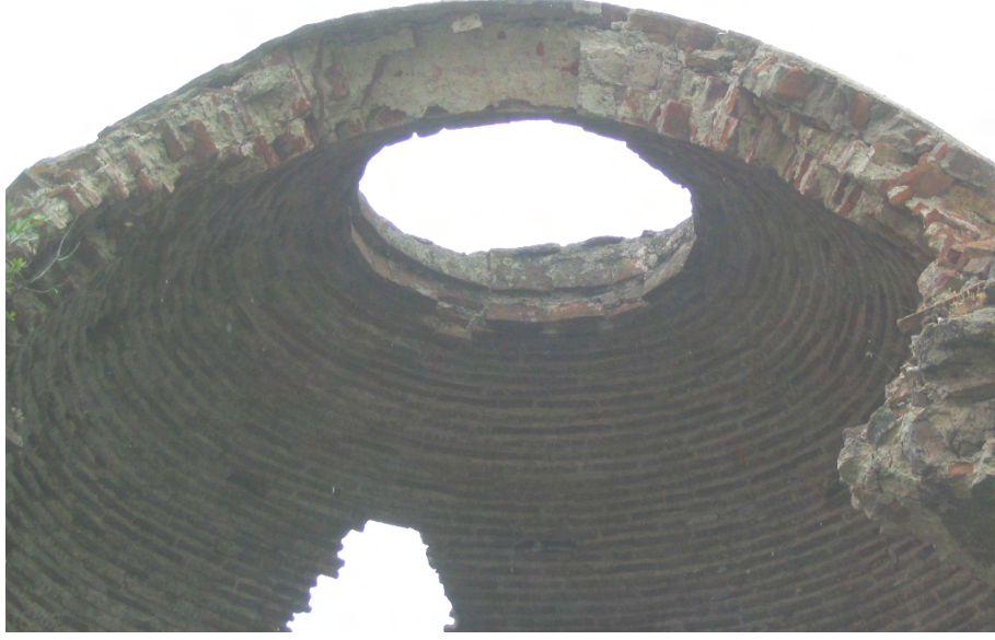
Resim 3.9 Edirne Saray mutfaklarının günümüze harabe durumda ulaşmış kubbe ve nefesliğinden detay
