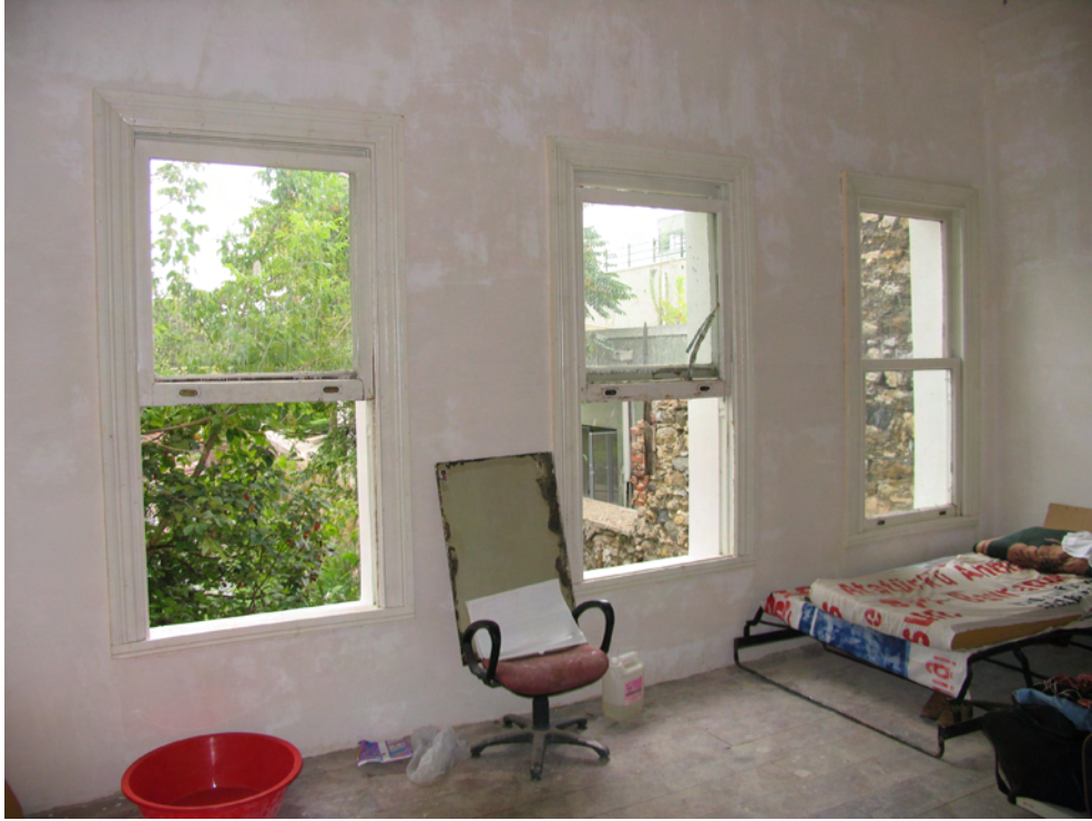
Resim 4.19 A-201 nolu mekan
