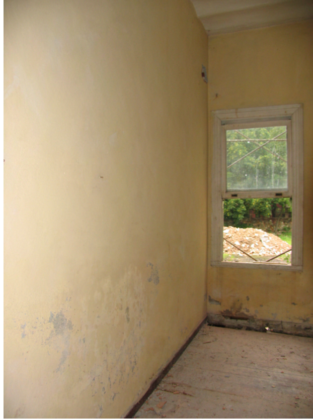
Resim 4.5 A-114 nolu mekan
