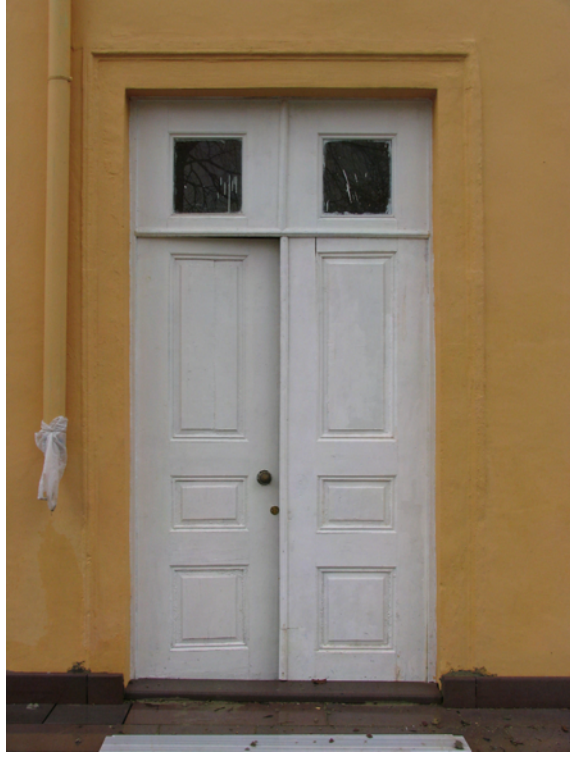
Resim 4.61 A Blok batı cephesinde yer alan çift kanatlı kapı (restorasyon uygulaması sonrası fotoğraftır)
