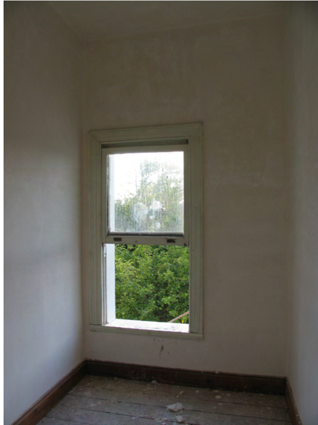
Resim 4.24 A-217 nolu mekan
