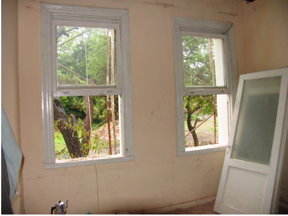
Resim 4.6 A-122 nolu mekan
