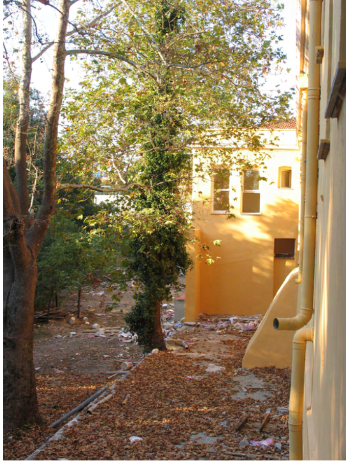
Resim 4.80 B Blok'a ait güney cephesi
