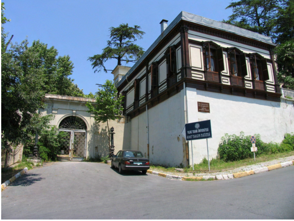
Resim 4.83 Set Köşkü ve alt kotunda yer alan Koltuk Kapısı
