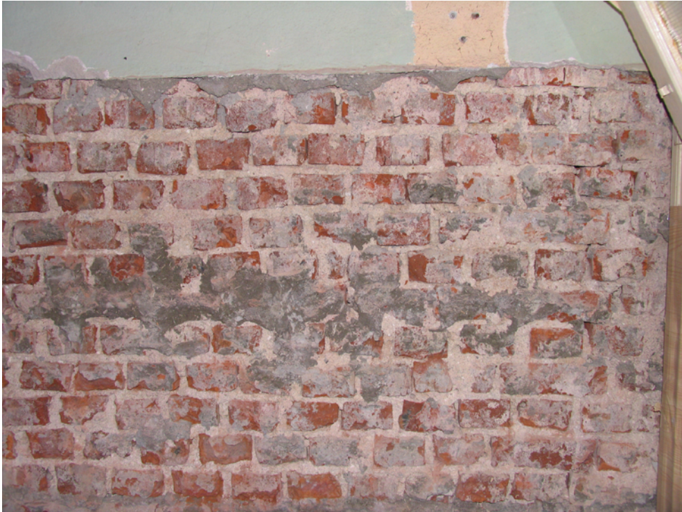
Resim 4.29 A-225 nolu mekanda restorasyon uygulaması esnasında fayansların sökülmesi ile görülebilen tuğla duvar
