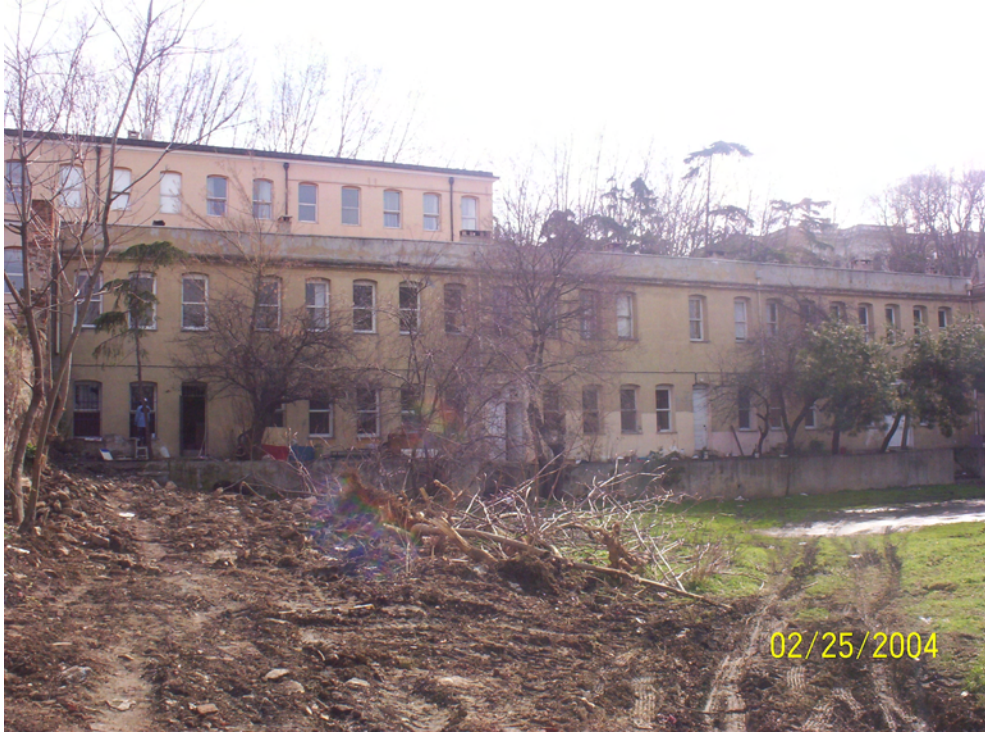
Resim 4.53 A Blok Batı Cephesi
