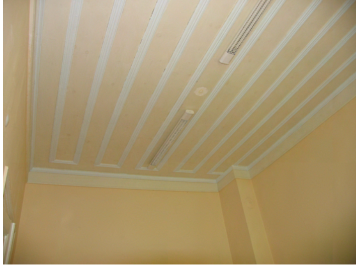
Resim 4.46 C-214 nolu mekana ait tavan (restorasyon uygulaması sonrası fotoğrafı)
