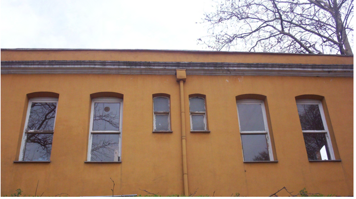
Resim 4.58 C Blok batı cephesinde yer alan kemer atkılı pencereler
