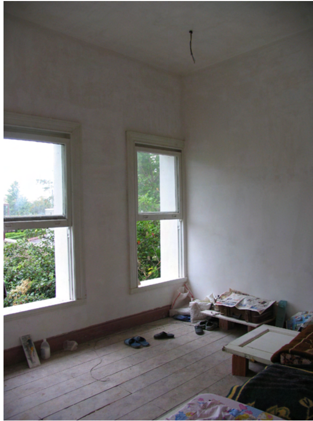
Resim 4.22 A-206 nolu mekan; orjinal ahşap döşeme ve süpürgelik bulunmaktadır
