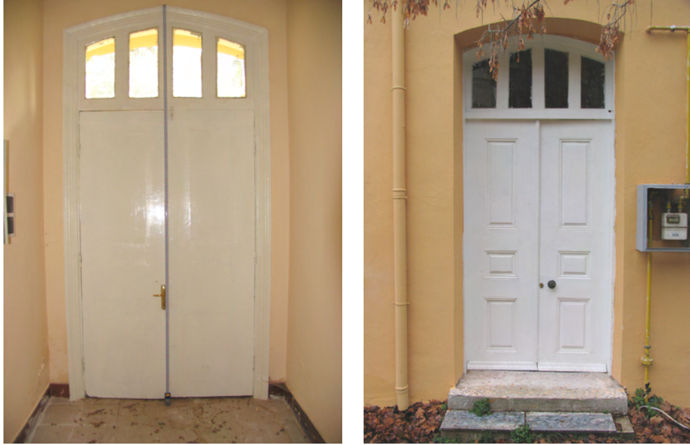
Resim 4.51 C Blok (C-204'e ait) dış kapı (restorasyon uygulaması sonrası fotoğrafıdır)
