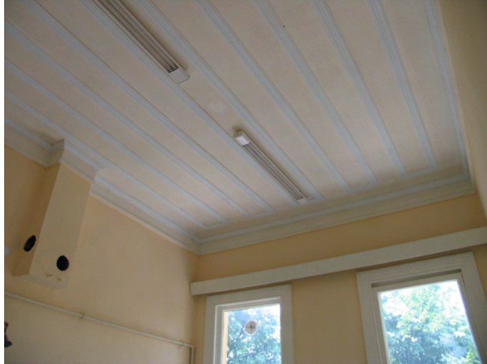
Resim 4.47 C-213 nolu mekana ait tavan (restorasyon uygulaması sonrası fotoğrafı)
