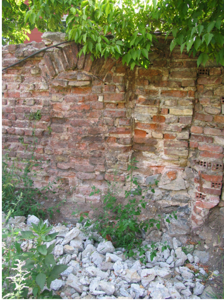
Resim 4.118 Duvarın doğu cephesinde farklı boyutuyla görebildiğimiz pencere
