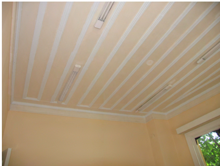
Resim 4.48 C-218 nolu mekana ait tavan (restorasyon uygulaması sonrası fotoğrafı)
