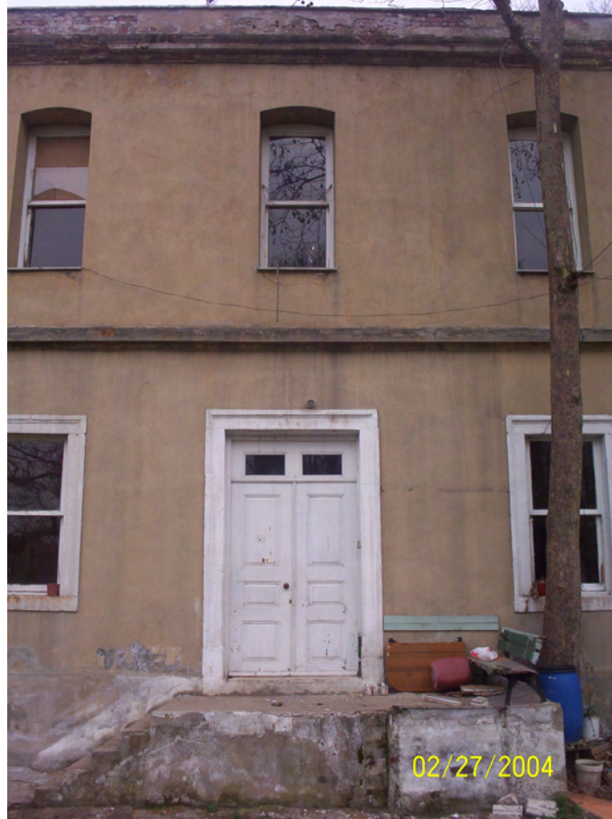
Resim 4.59 B Blok batı cephesinden kısmi görünüm
