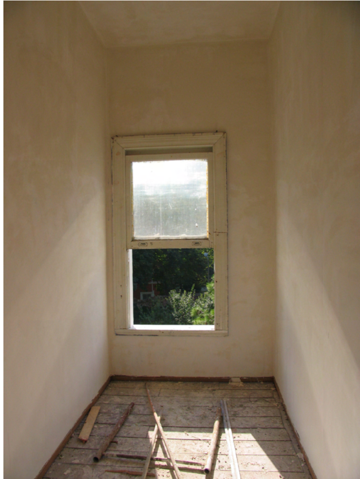
Resim 4.26 A-226 nolu mekan
