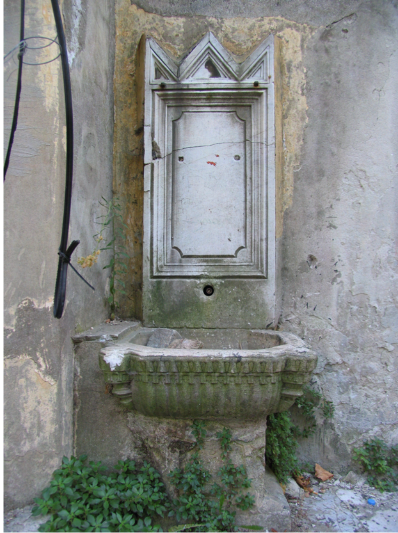
Resim 4.110 Koltuk Kapısı'nın yanında bulunan duvar çeşmesi
