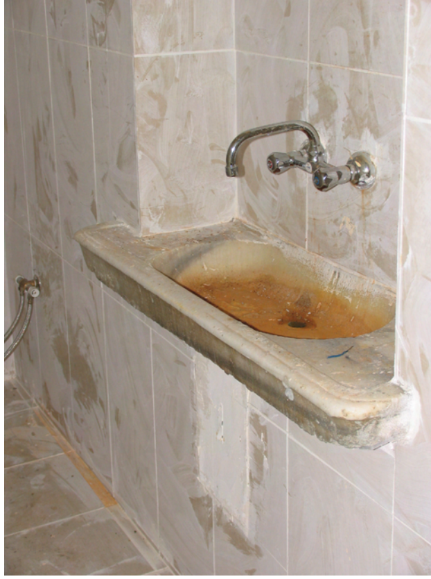
Resim 4.37 C-203 nolu mekanda yer alan mermer kurna (restorasyon uygulaması sonrası fotoğraftır)
