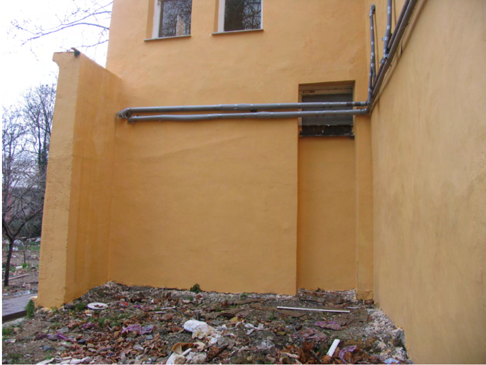
Resim 4.81 B Blok güney cephesi üzerinde yer alan B-124 nolu mekana açılan bir kapının yer aldığı düşünülen kapı izi (restorasyon uygulaması sonrası fotoğrafıdır)
