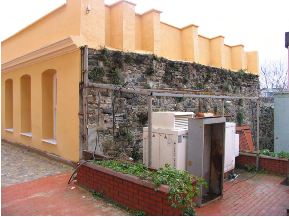
Resim 4.66 Kılar-ı Hümayun yapısı kuzey cephesi (restorasyon uygulaması sonrası fotoğrafıdır)
