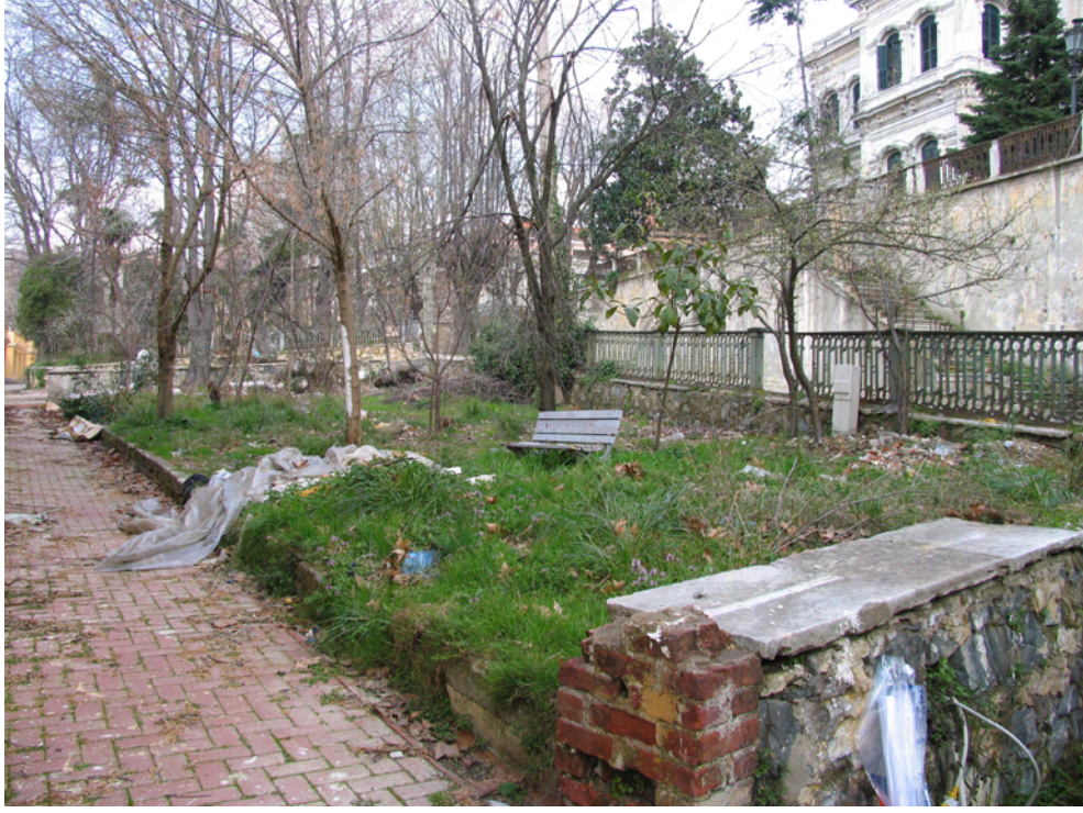
Resim 4.93 C Blok önünde yer alan bahçe ve korkulukları
