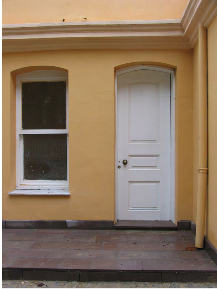
Resim 4.73 A-221 nolu mekana ait tek kanatlı kapı ve pencere
