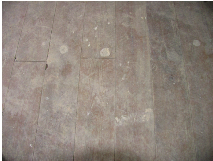
Resim 4.20 A-201 nolu mekanda bulunan ahşap döşeme kaplaması
