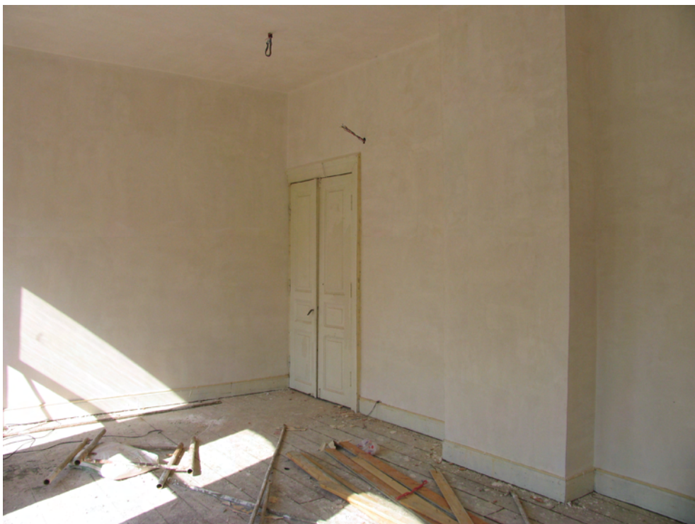
Resim 4.27 A-228 nolu mekan
