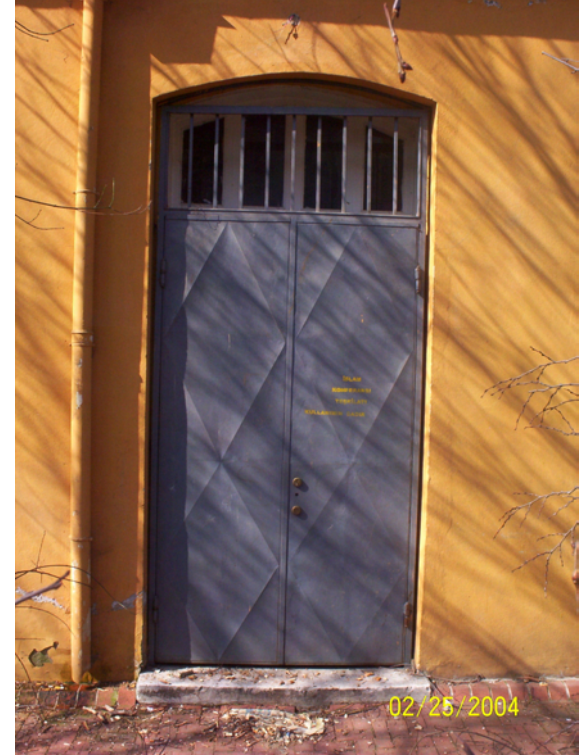
Resim 4.78 C Blok'un IRSICA tarafından arşiv olarak kullanılan mekanlarının güvenlik amacı ile demir parmaklık ve demir kapı ile kapatılmış pencere ve kapısı
