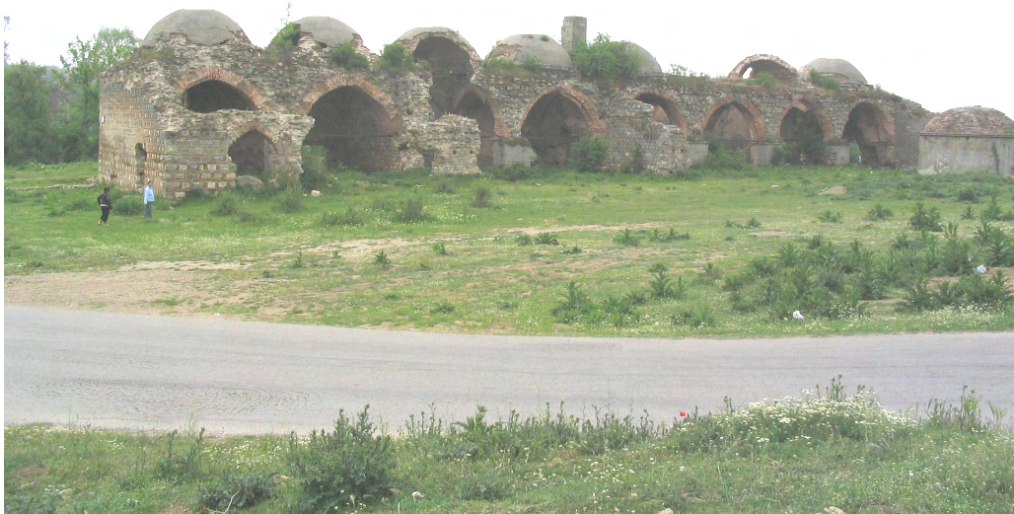
Resim 3.7 Edirne Saray mutfaklarından genel görünüş
