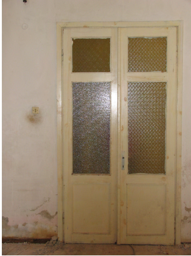
Resim 4.18 B-112'den 114 nolu mekana geiři saęlayan kapı
