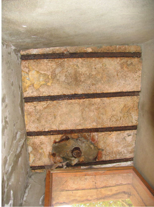
Resim 4.16 B-124 nolu mekanın tavan döşemesi
