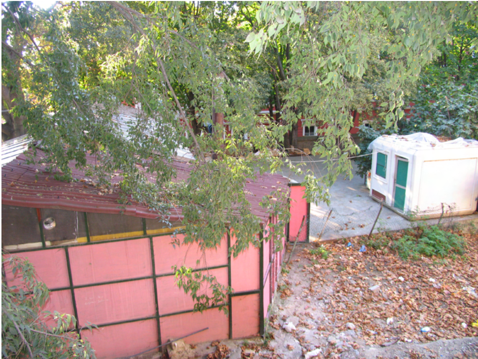
Resim 4.104 Batı bahçesinin güneyinde yer alan muhdes yapılar
