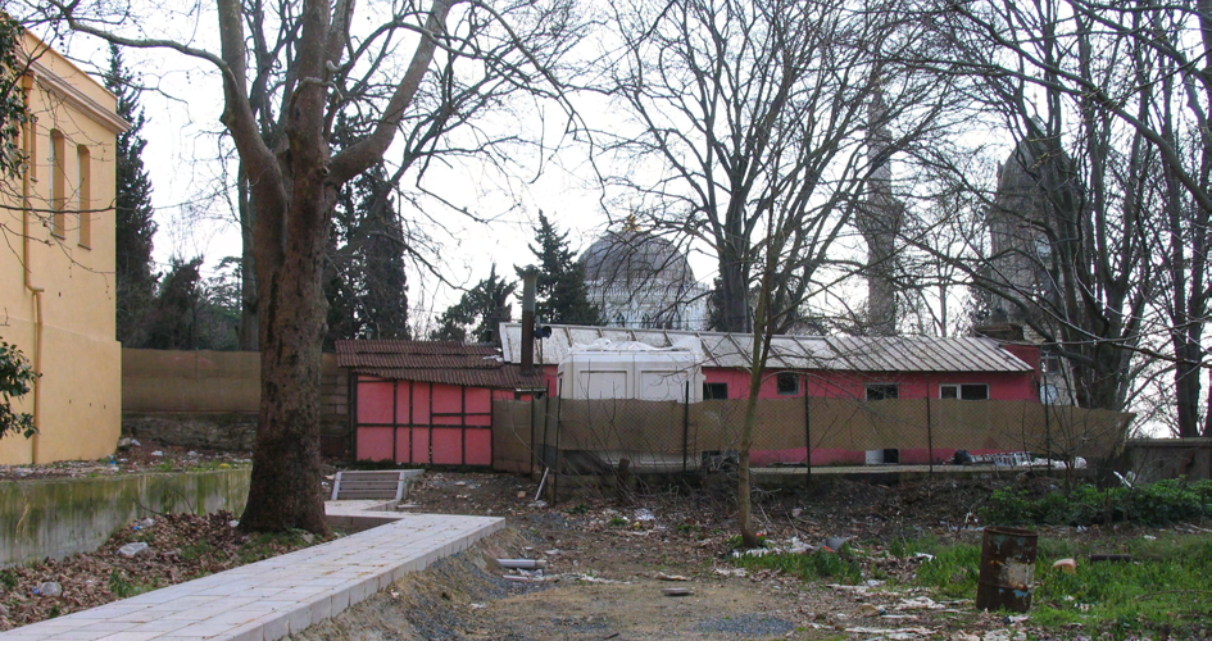
Resim 4.109 Güney Duvarı üzerinde muhdes yapılar
