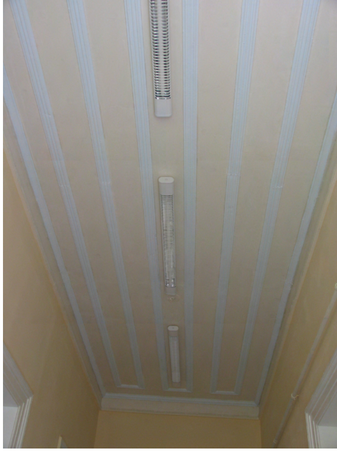
Resim 4.43 C-217 nolu mekana ait tavan kaplaması (restorasyon uygulaması sonrası fotoğraftır)
