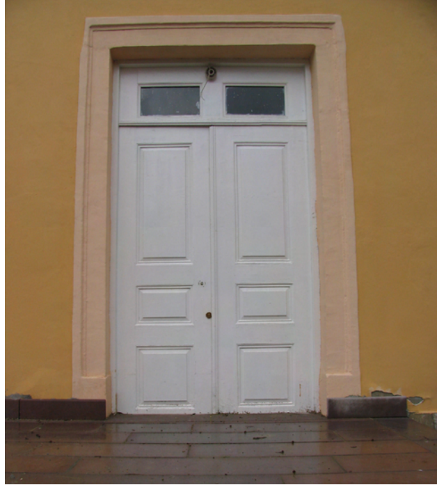
Resim 4.62 B Blok batı cephesinde yer alan çift kanatlı kapı (restorasyon uygulaması sonrası fotoğraftır)
