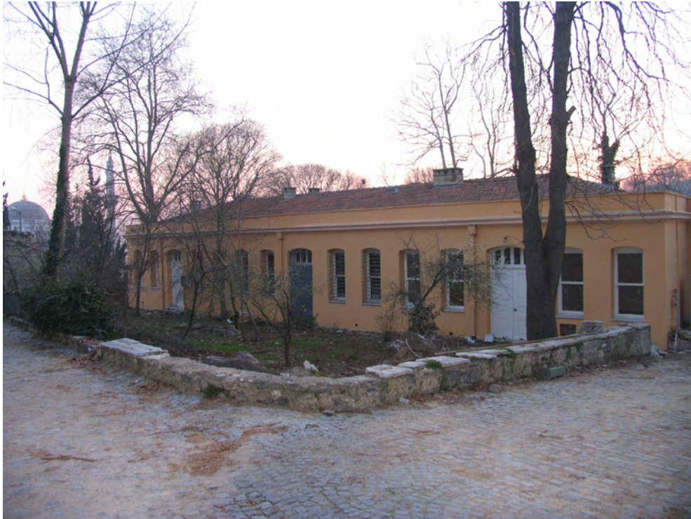
Resim 4.72 Kılar-ı Hümâyun yapısı C Blok doğu cephesi
