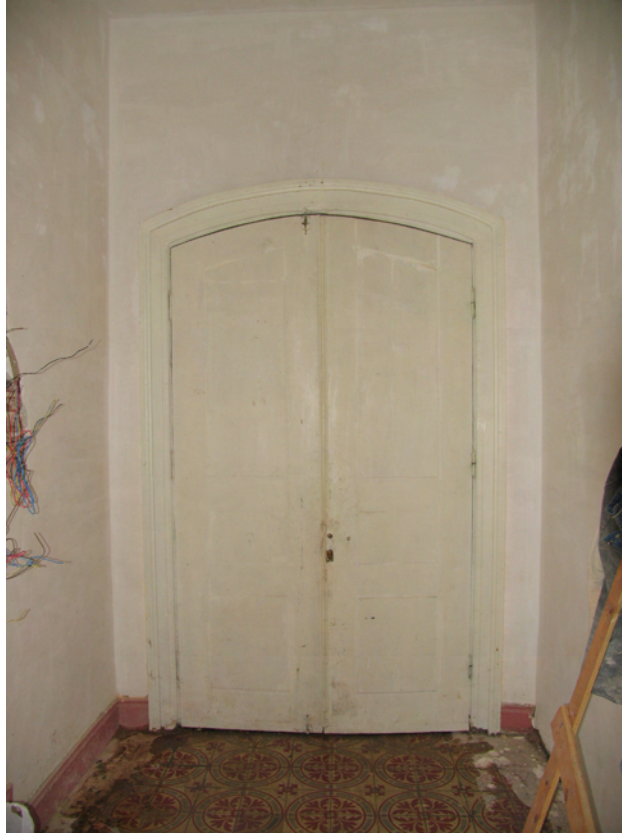
Resim 4.31 A-205 nolu mekana ait dış kapı
