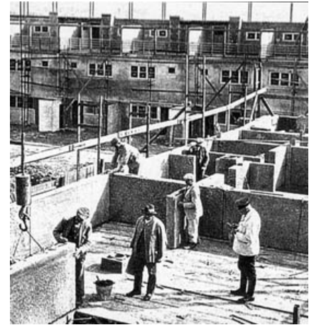
Şekil 2.7 Praunheim Şantiyesi, E. May, Frankfurt.
