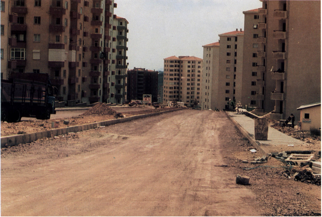
Fotoğraf :3 Uğur Mumcu Mahallesi toplu konut yerleşim alanının altyapı ve yol çalışmasından bir fotoğraf
