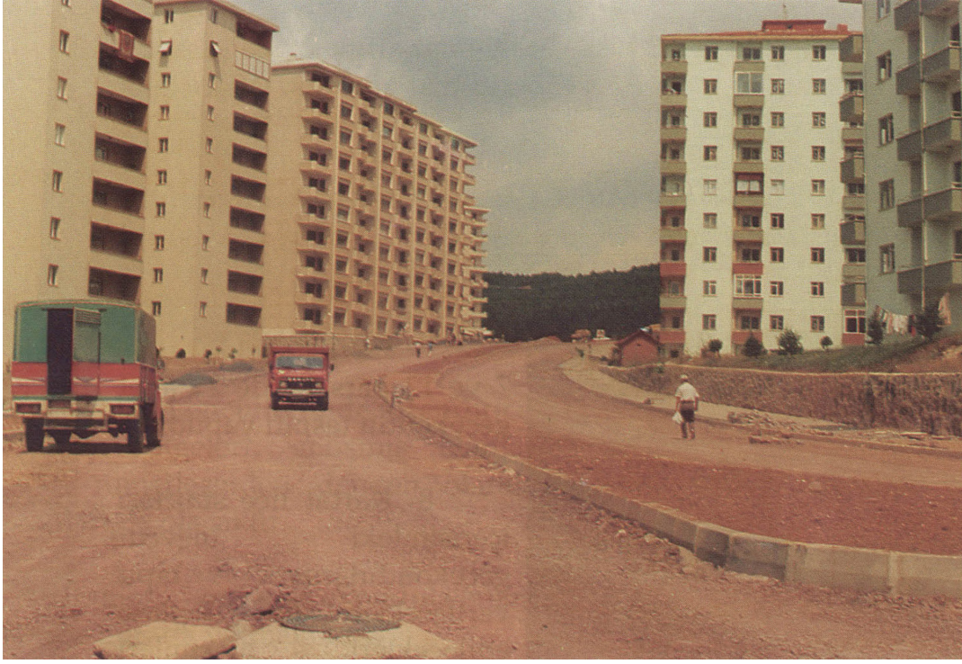
Fotoğraf :4 Uğur Mumcu Mahallesi toplu konut yerleşim alanının altyapı ve yol çalışmasından bir fotoğraf
