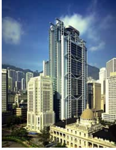
Resim 14 Hongkong Shanghai Binası
