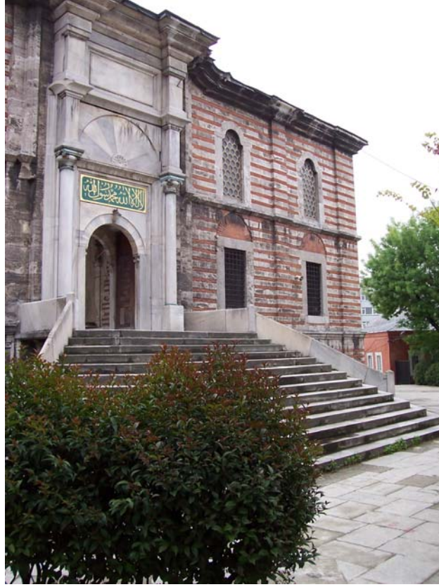
Resim 2.24. Laleli Camii avlu duvarı kuzey cephesi
