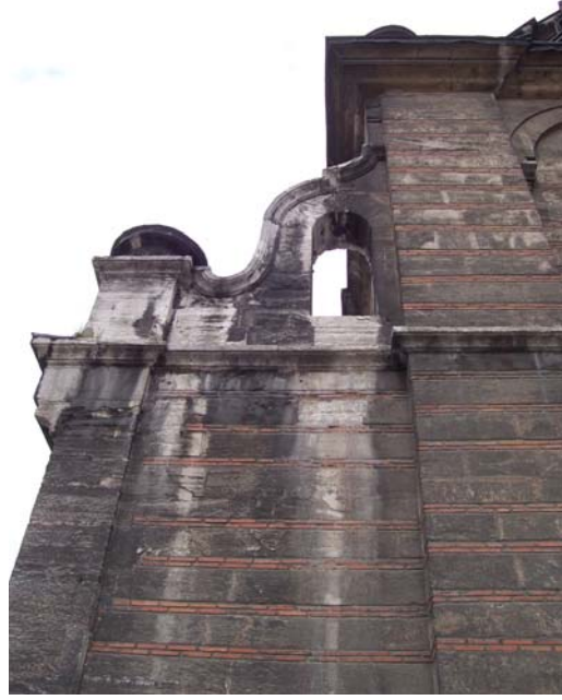
Resim 2.27. Güney cephesindeki bağlantı elemanı
