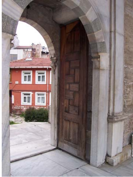
Resim 2.43. Avlu kapısı kanadı
