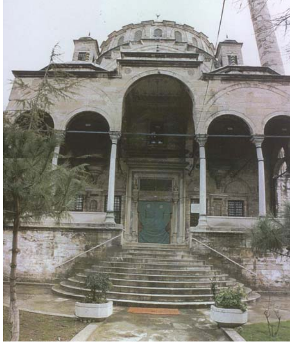
Resim 2.4. Ayazma Camii kuzey cephesi
