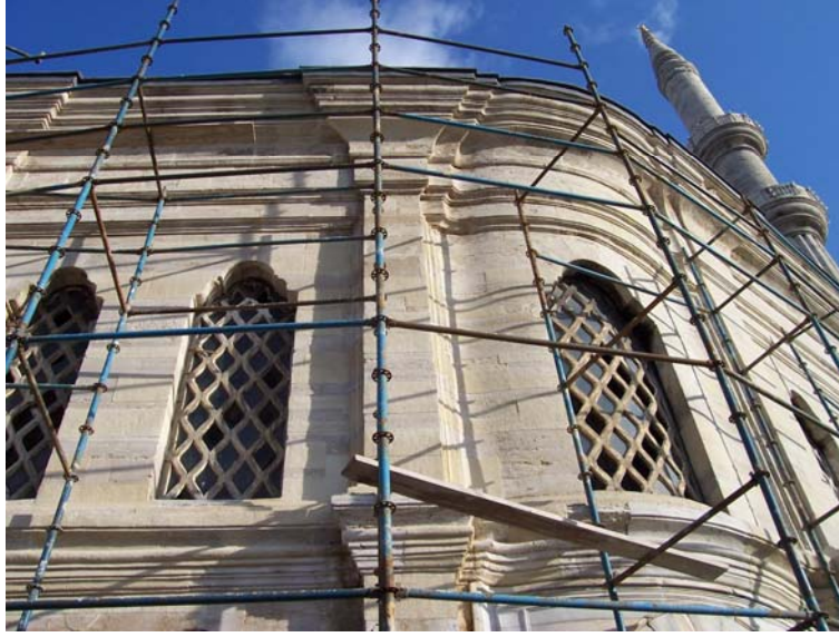
Resim 3.21. Mahfil katı silmesinin cepheye yansımaları
