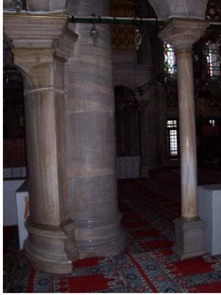
Resim 2.33. Mahfil katını taşıyan sütun ve kubbeyi taşıyan sütunun birleşim detayı
