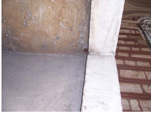
Resim 2.42. Avlu pencerelerindeki mil izi
