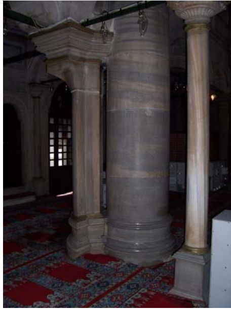
Resim 2.34. Mahfil katını taşıyan sütun ve kubbeyi taşıyan sütunun birleşim detayı
