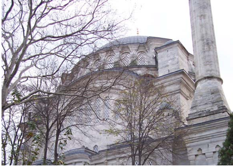
Resim 3.8. Nuruosmaniye Camii cephesi ikinci pencere sırası
