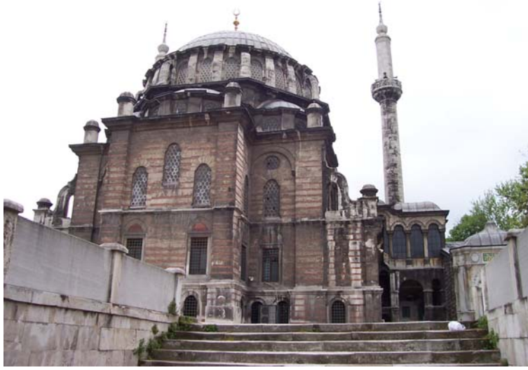
Resim 2.21. Pencere sıraları ve ana silme (Güney Cephesi)
