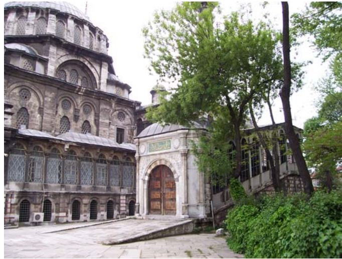
Resim 2.26. Laleli Camii doğu cephesi
