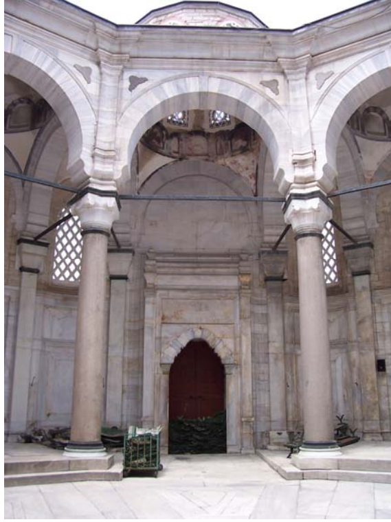
Resim 3.45. Avlu kapısı iç kemeri
