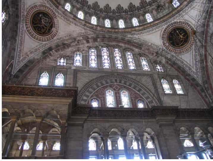
Resim 3.24. Beden duvarındaki askı ve hafifletme kemerleri
