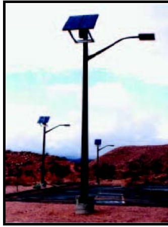
Şekil 4.8 Güneş kollektörü ile çalışan bir dış mekan aydınlatma elemanı (LANL, 2002).
