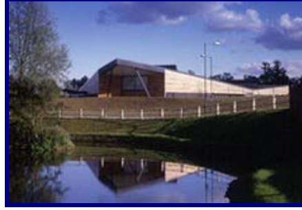
Şekil 3.13 Okul binasının genel görünümü
