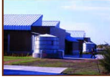
Şekil 4.49 Yağmur suyu depolama tankı, Roy Lee Walker Temel Eğitim Okulu, McKinney, Texas [12]
