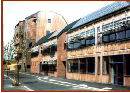
Şekil 3.11 Binanın derslik mekanlarından oluşan güney cephesi
