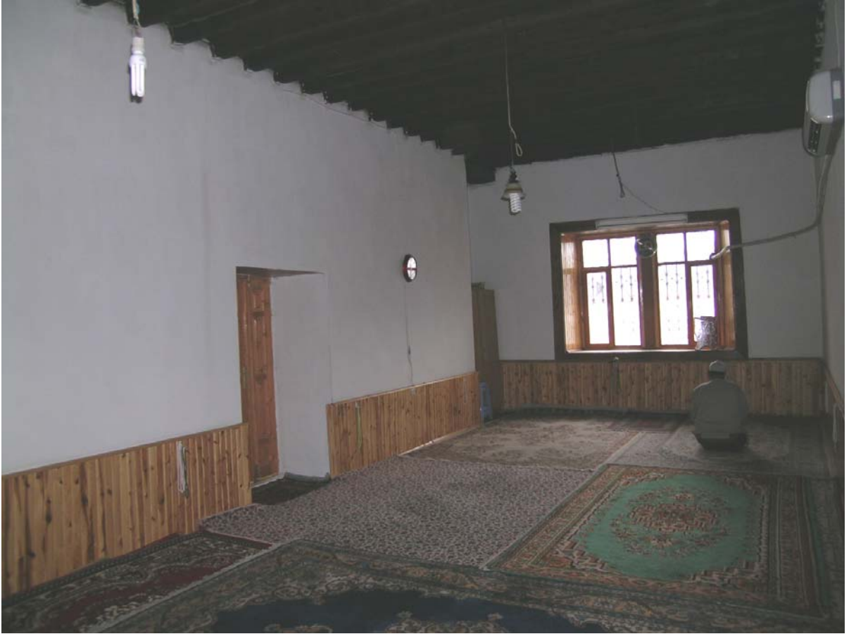
Şekil 6.29 Z05 oda güney ve doğu duvarları
