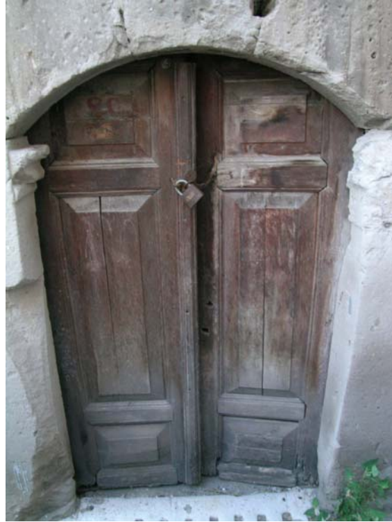
Şekil 6.79 Hamam giriş kapısı
