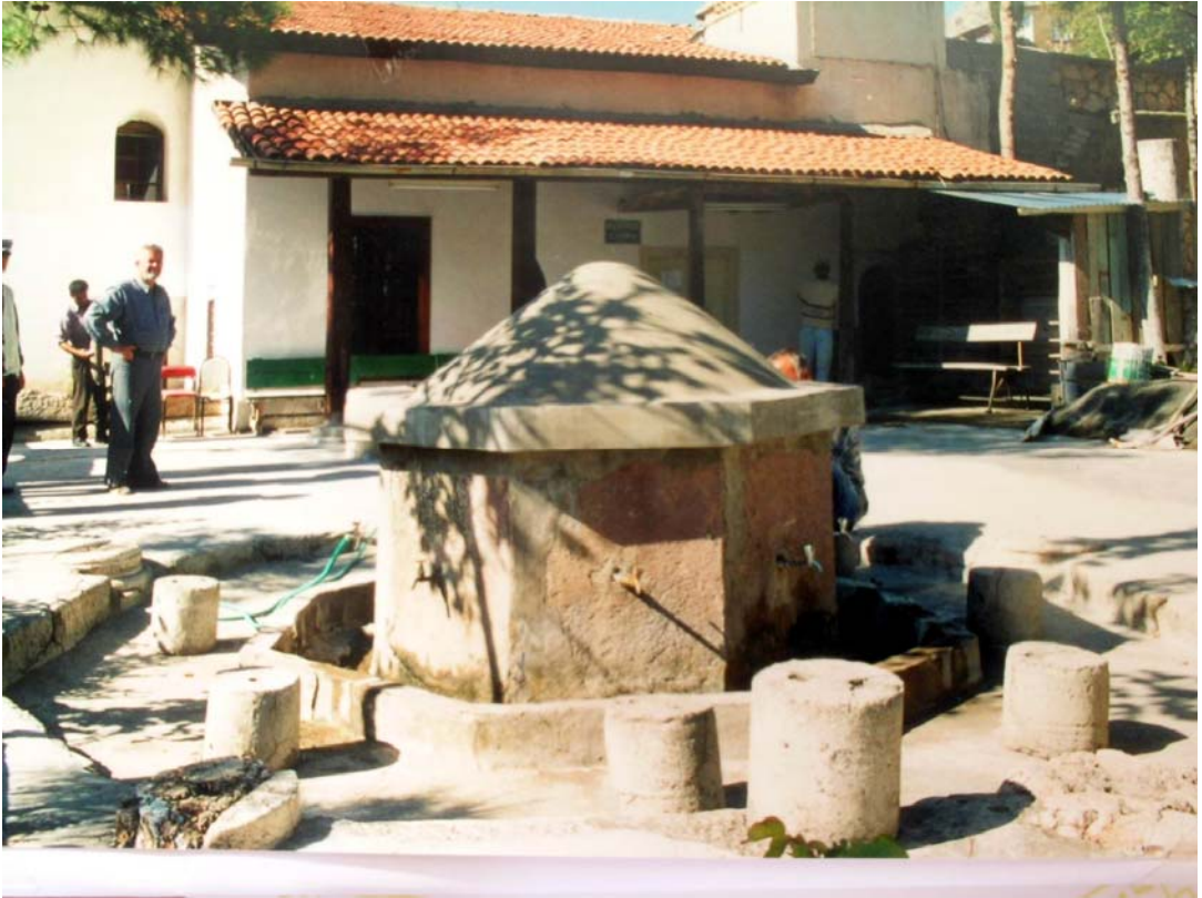
Şekil 6.11 Şadırvanın değiştirilmeden önceki hali (Hızır Paşa Camisi Arşivi)
