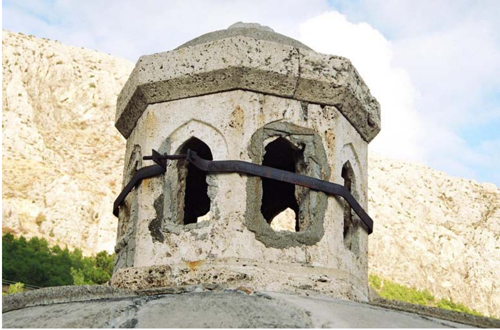
Şekil 6.80 Aydınlık fenerindeki çimento harç ve metal kasnak uygulaması
