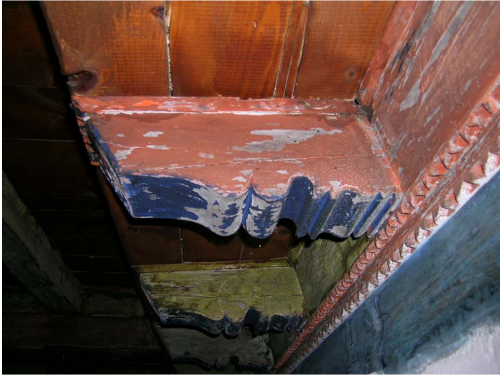
Şekil 6.70 Ahşap konsollar
