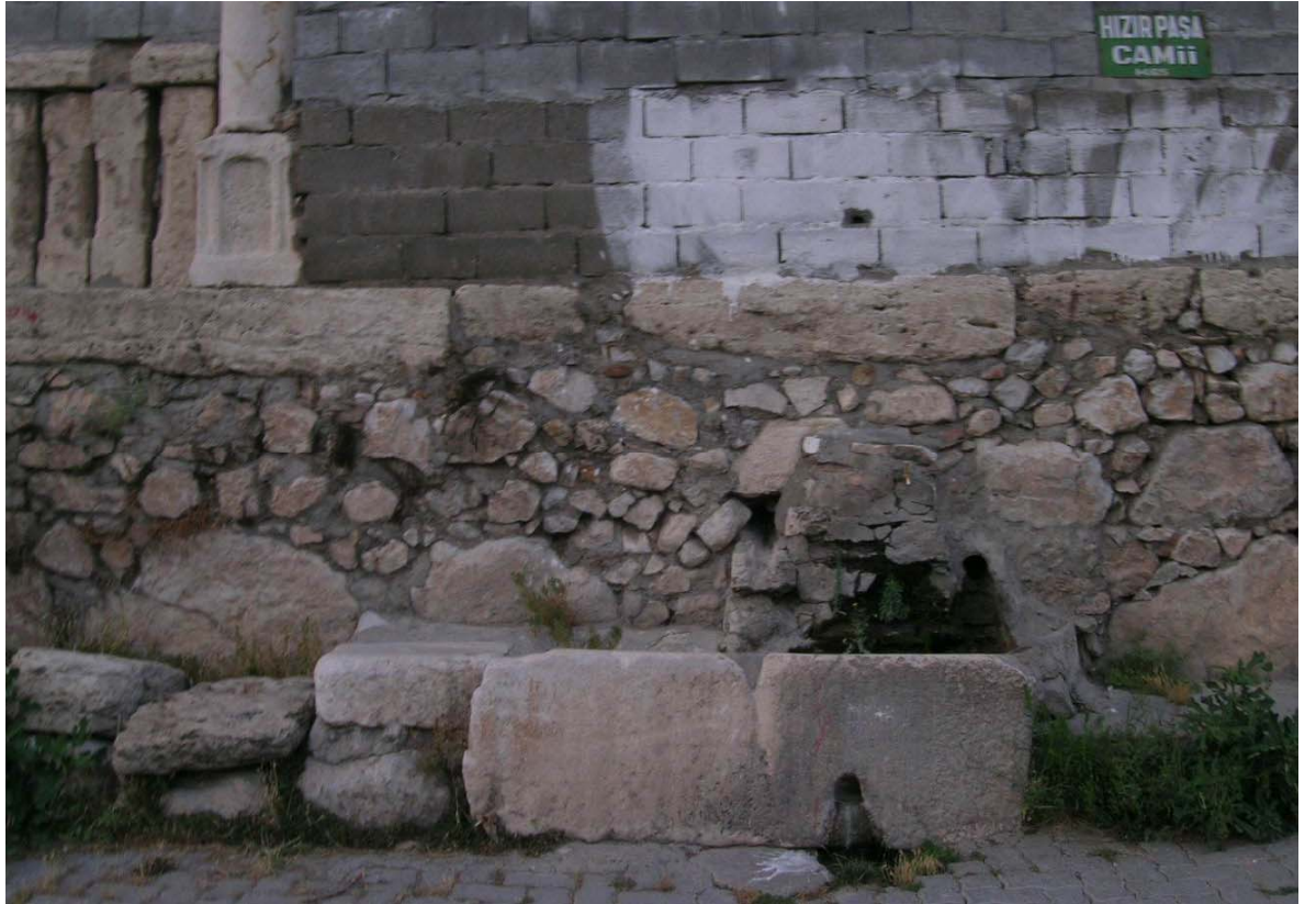
Şekil 6.4 Avlunun güney duvarında yer alan çeşme
