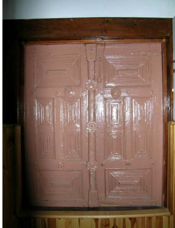
Şekil 6.26 Z04 güney duvarında yer alan pencere kapağı (PK2)
