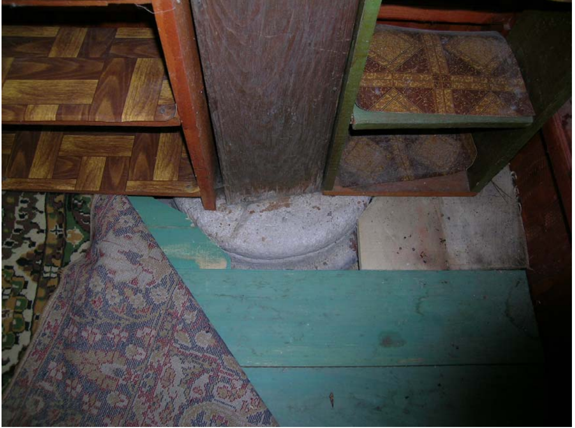
Şekil 6.15 Son cemaat yeri ahşap taşıyıcısı altında bulunan özgün taş sütun kaidesi
