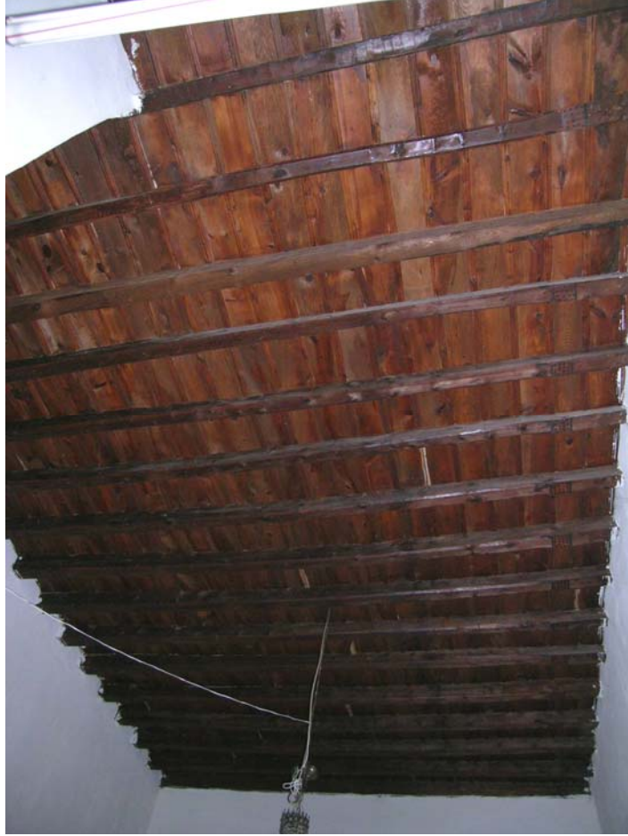
Şekil 6.20 Z02 tavan kaplaması
