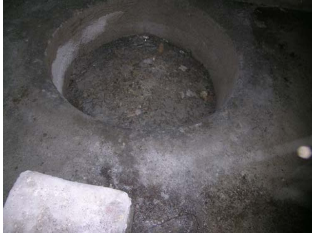
Şekil 6.48 Su deposunda bakır kazanın konduğu kısım
