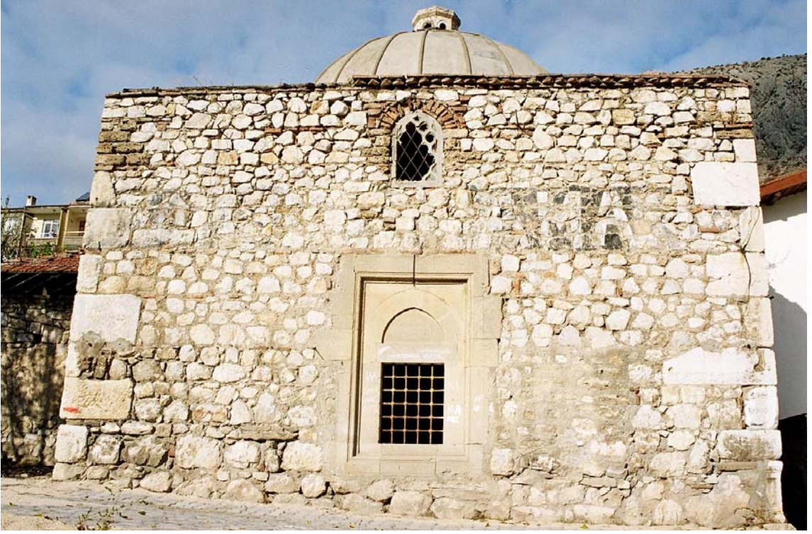
Şekil 6.66 Hamamın güney cephesi
