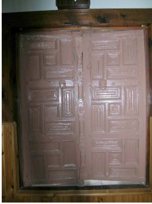
Şekil 6.25 Z04 doğu duvarında yer alan pencere kapağı (PK1)
