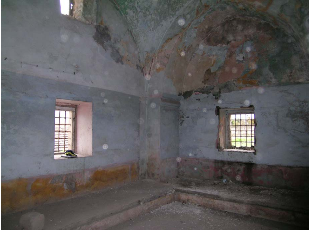
Şekil 6.37 Soyunmalık güney ve batı duvarları
