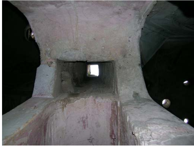
Şekil 6.40 Soyunmalık ile ılıkılık arasındaki baca
