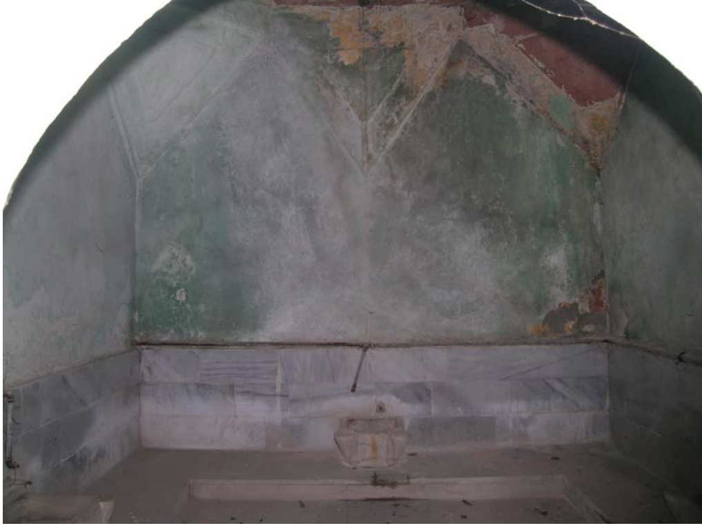
Şekil 6.44 Z04 halvet doğu duvarı
