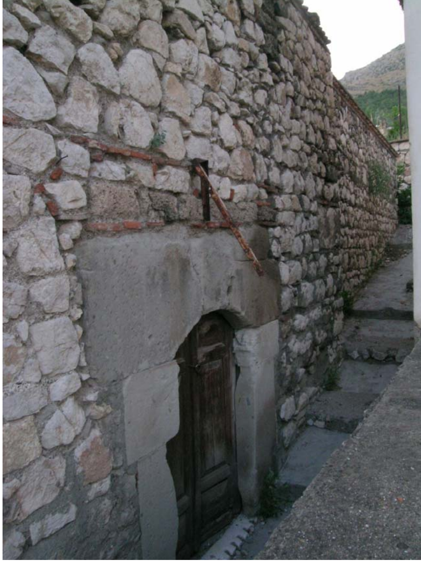
Şekil 6.60 Hamam girişinin bulunduęu doęu cephe
