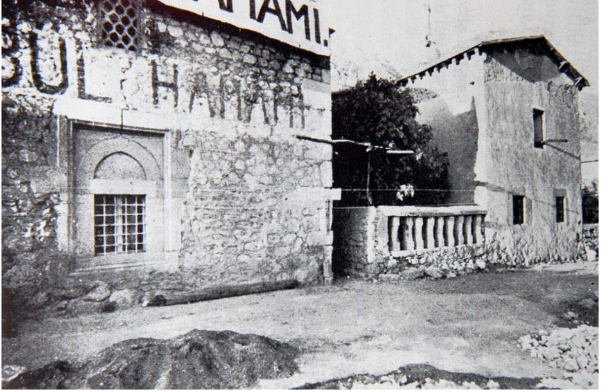
Şekil 7.4 Cami ve hamam güney cepheleri (Ayverdi, 1989)
