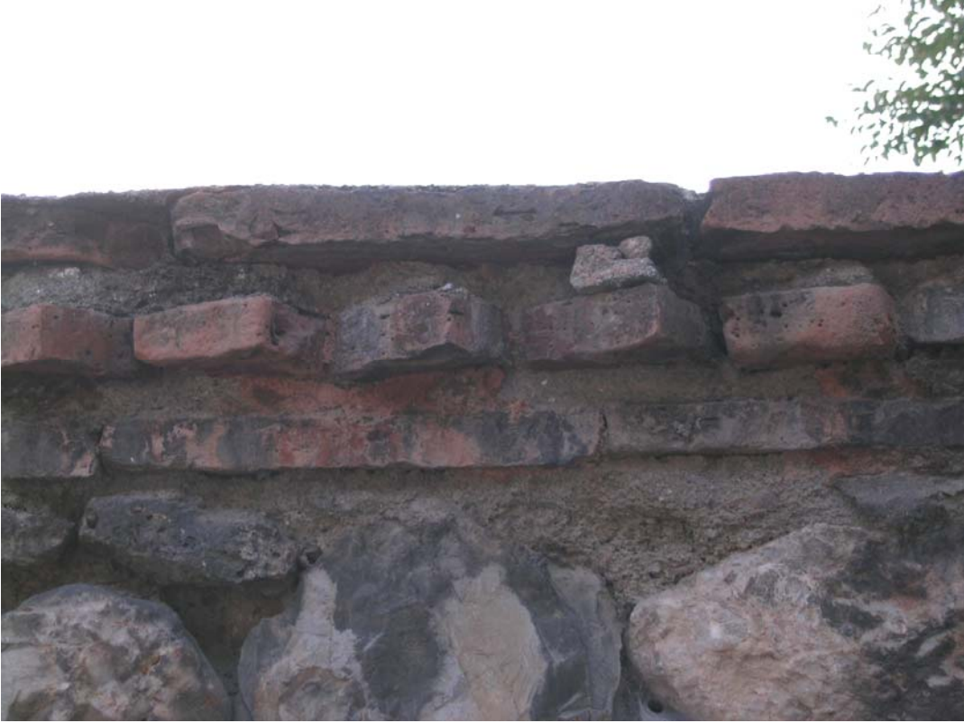
Şekil 6.69 Kırpi saçak sırası
