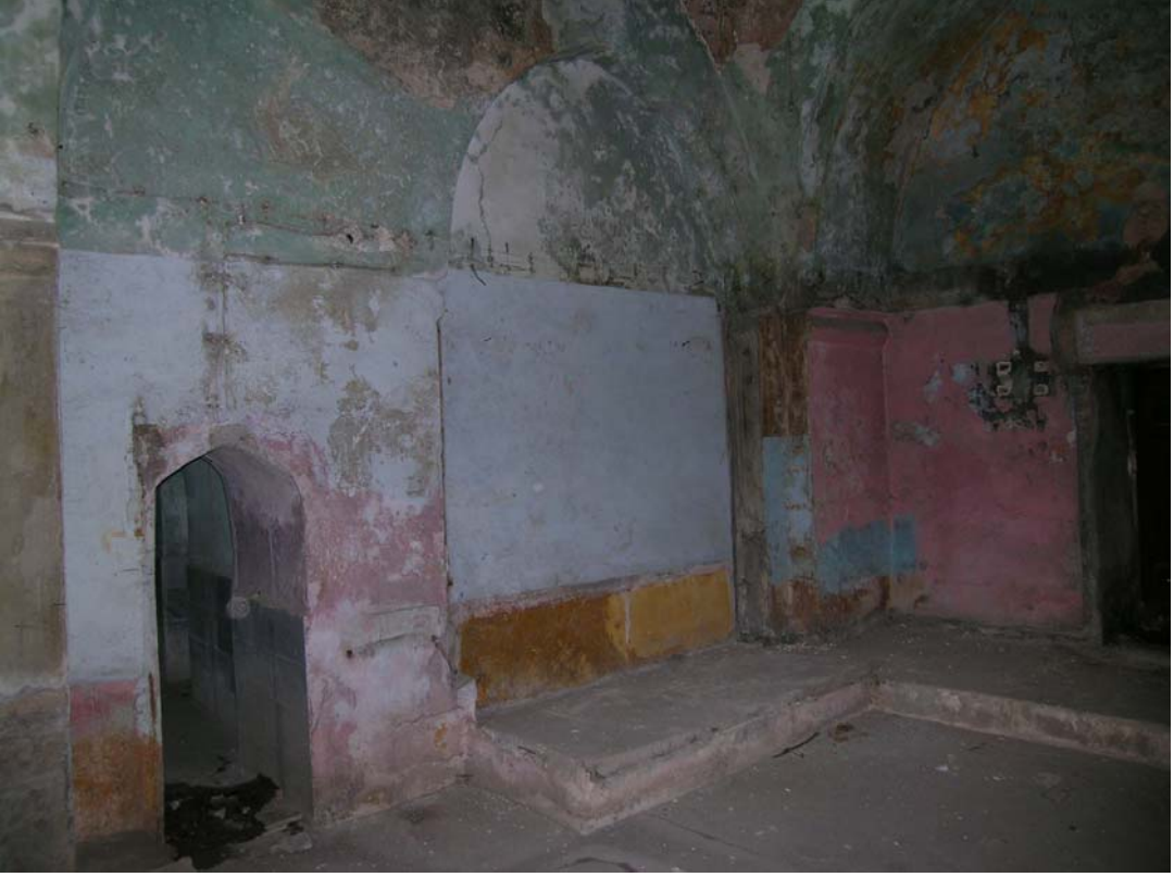
Şekil 6.38 Soyunmalık kuzey ve doğu duvarları
