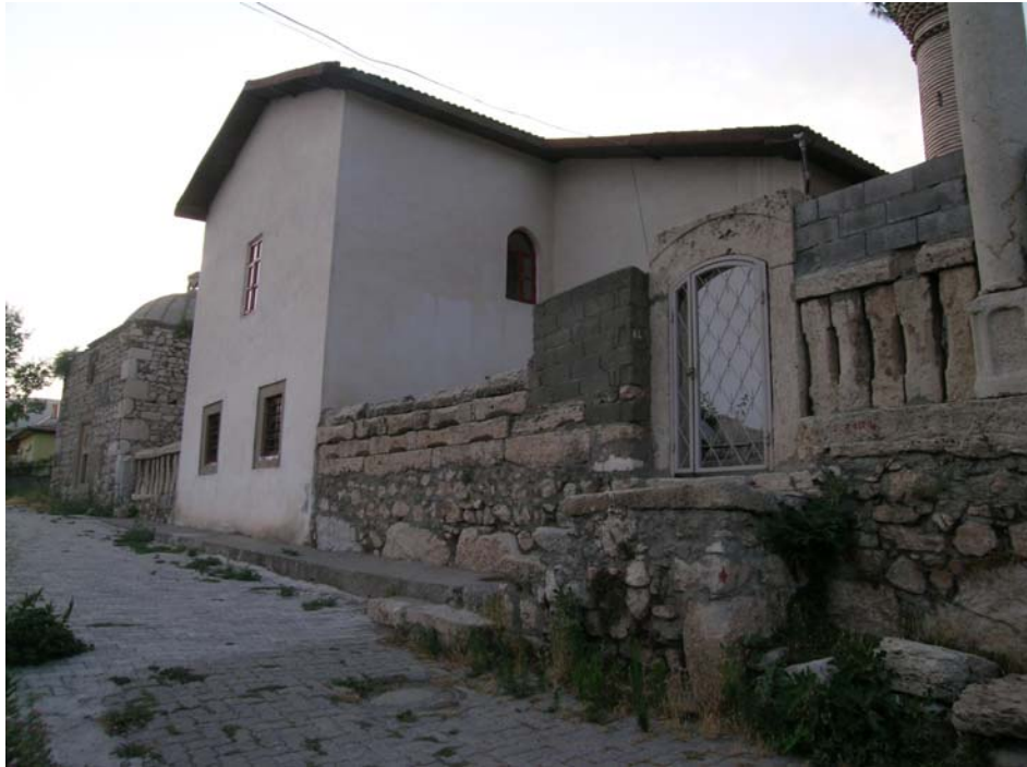
Şekil 6.2 Avlu duvarı ve güney girişi
