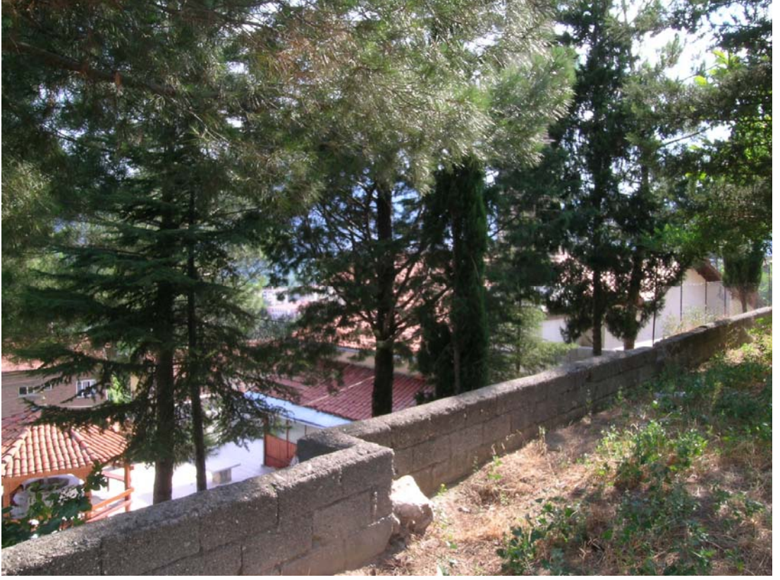
Şekil 6.8 Avlunun kuzey duvarı
