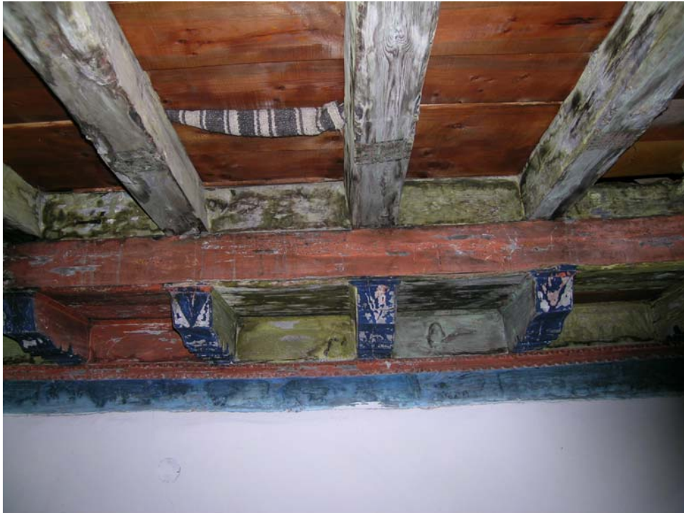
Şekil 6.76 Z03 sahnin ahşap tavadaki bozulmalar
