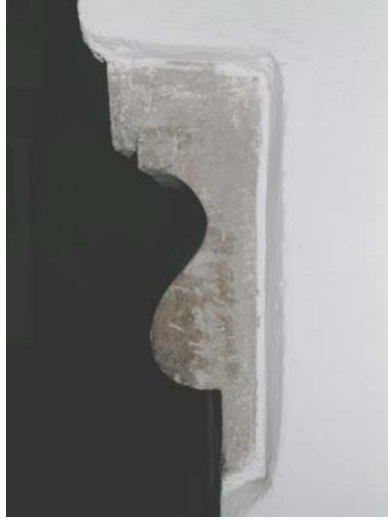
Şekil 6.21 Kemer üzengi seviyesinin altında yer alan konsollardan bir tanesi
