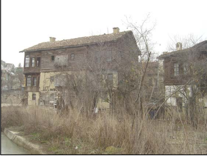
Fotoğraf 5.72 Komşu Yapı Rüştiye Mektebi
