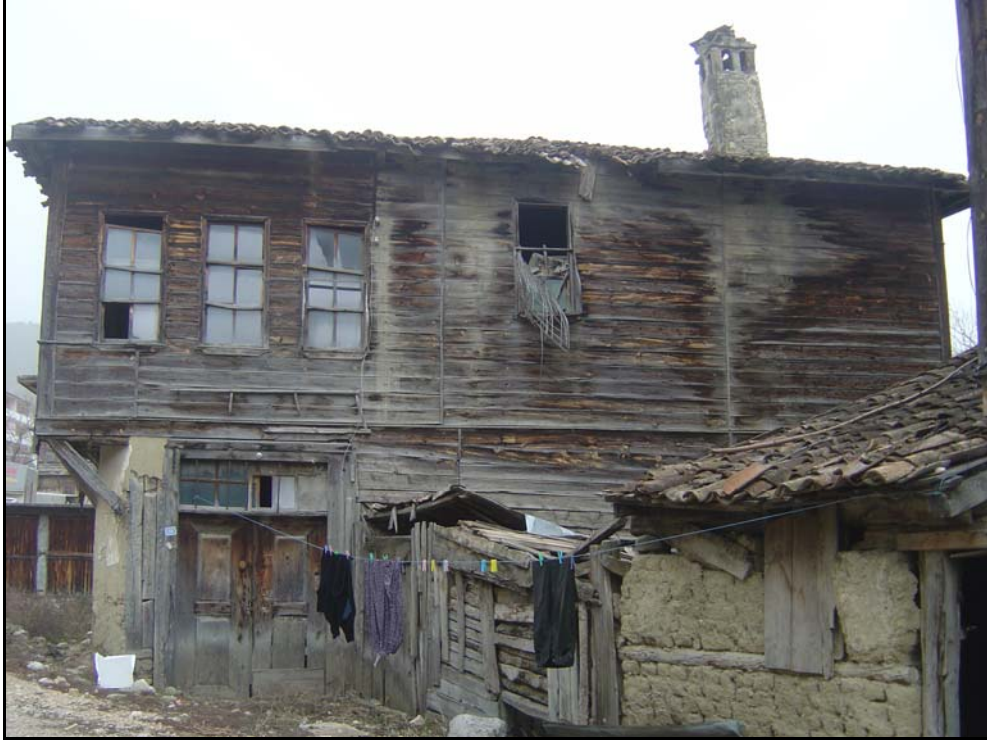
Fotoğraf 5.88 - Restorasyon Öncesi –Batı Cephesi
