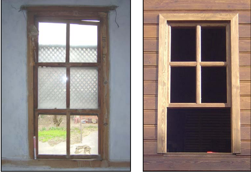
Fotoğraf 4.7-4.8: Restorasyon öncesi ve sonrası pencere örneği
