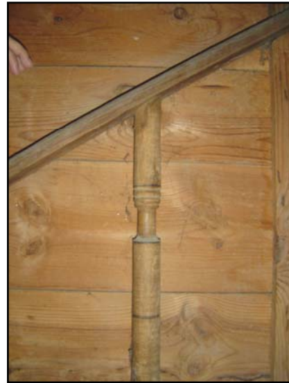
Fotoğraf 5.53 Yüklüğe Çıkış Merdiveni Korkuluk Detayı
