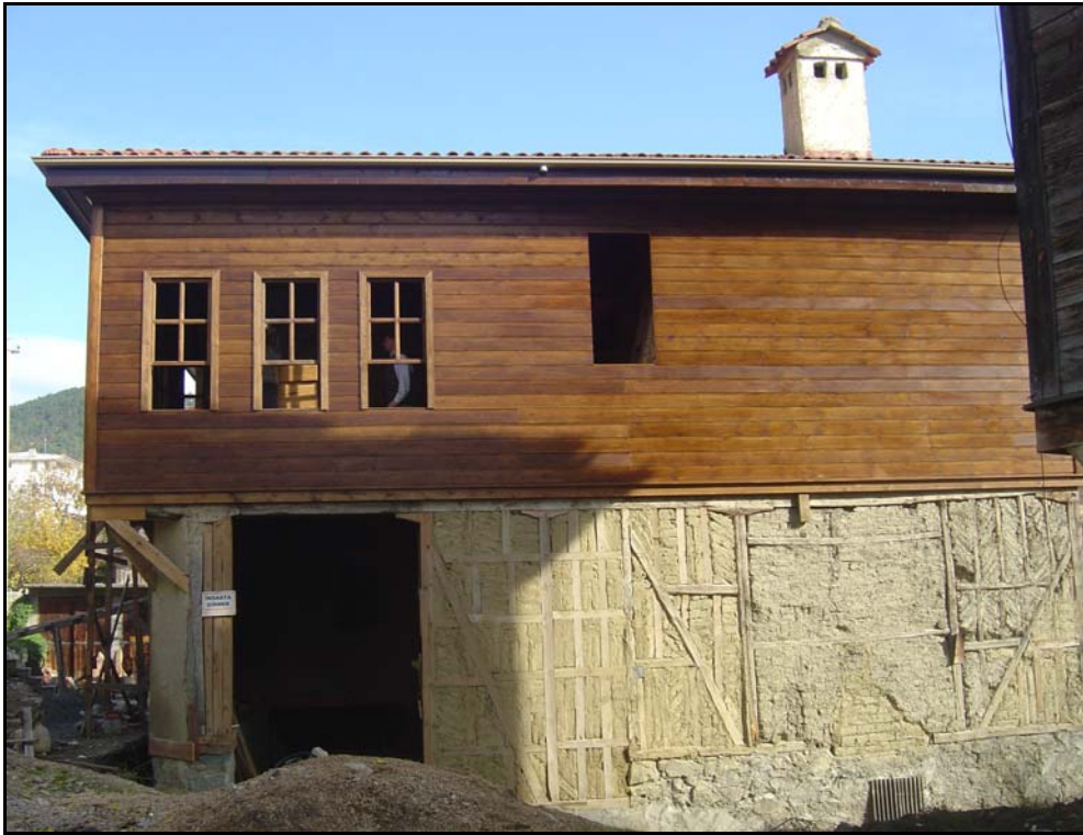
Fotoğraf 5.89 - Restorasyon Sonrası – Batı Cephesi
