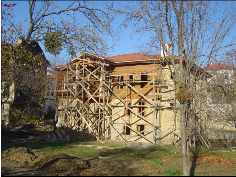
Fotoğraf 5.85 - Restorasyon Sonrası – Güney Cephesi
