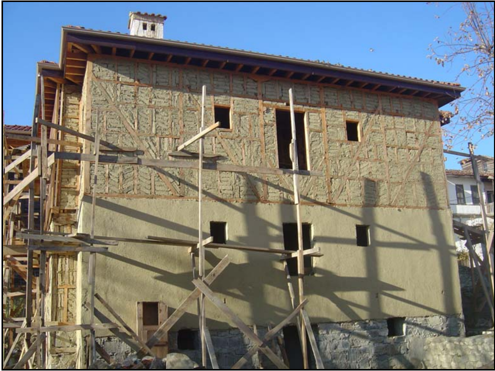
Fotoğraf 5.91 - Restorasyon Sonrası – Doğu Cephesi
