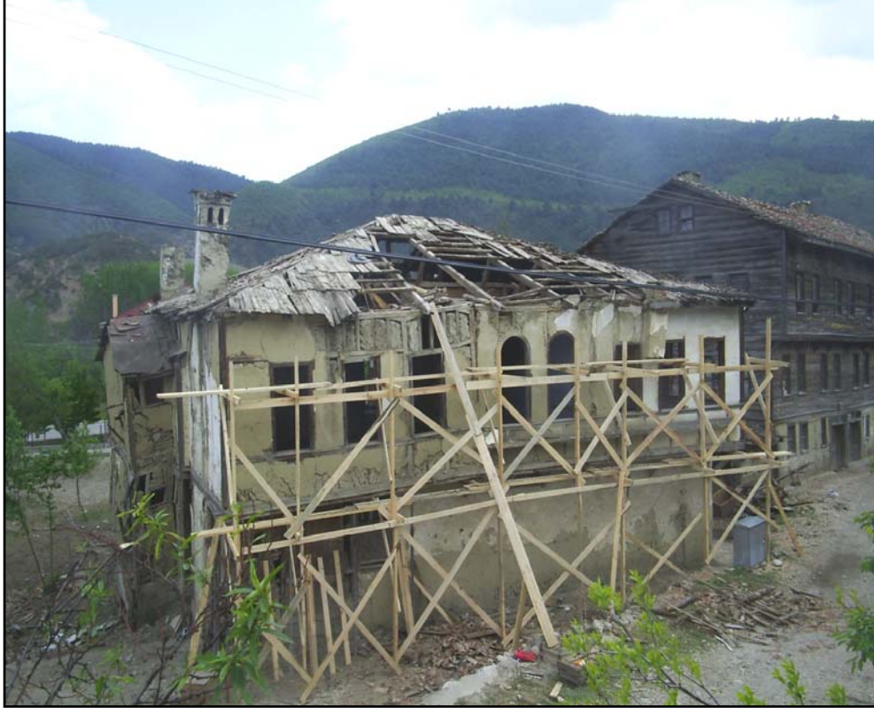
Fotoğraf 5.86 - Restorasyon Öncesi – Kuzey Cephesi
