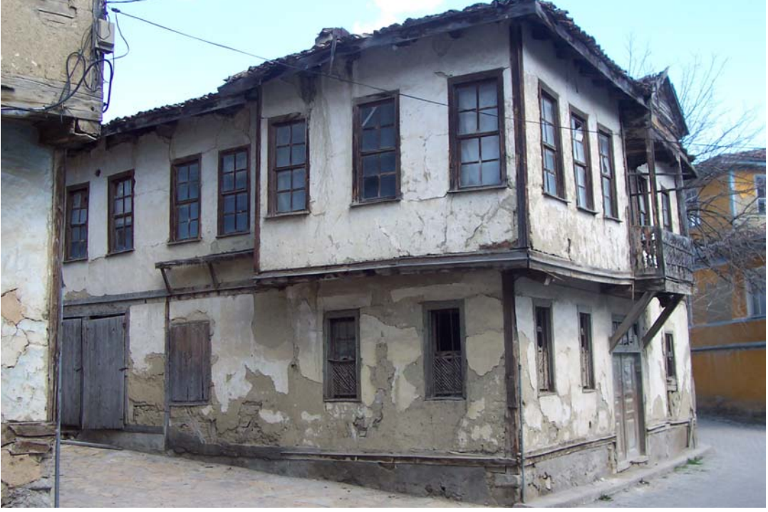
Fotoğraf Ek 2.13 Rüştiye Sokak-Altıncı Geçit Sokak Kesişimi
