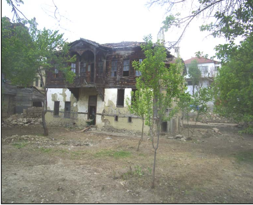
Fotoğraf 5.84 - Restorasyon Öncesi – Güney Cephesi
