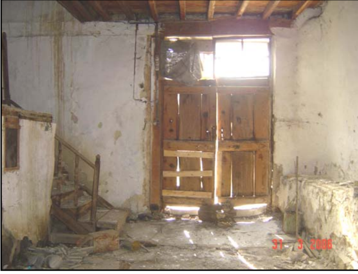
Fotoğraf 5.1 Zemin Kat-Giriş Kapısı
