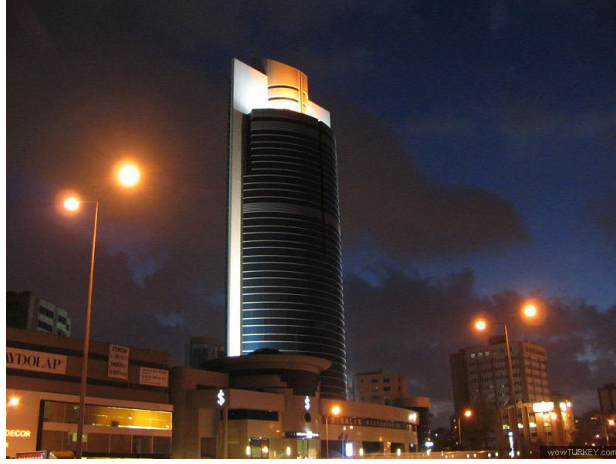
Şekil 5.49 Kozyatağı İş Merkezi [120]
