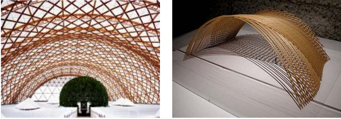
Şekil 4.7 Geri dönüştürülmüş kağıtlardan oluşturulmuş Expo 2000 Japon Pavyonu [1]
