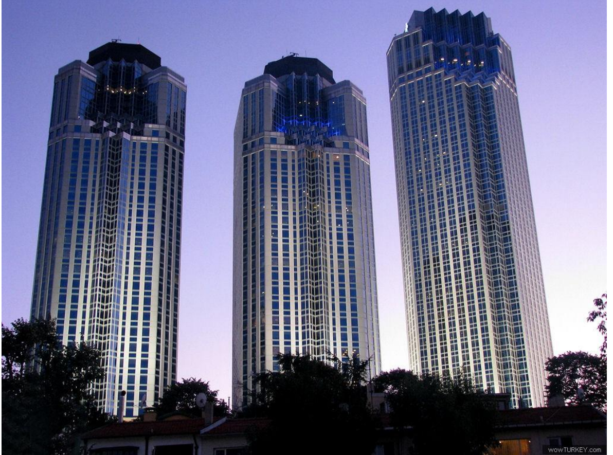
Şekil 3.78 İş Bankası Kuleleri
