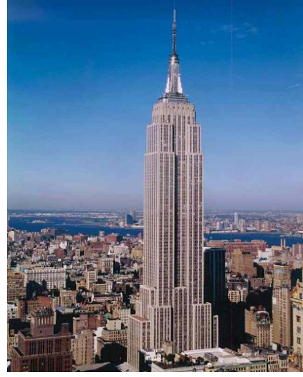
Şekil 6 Empire State Building
