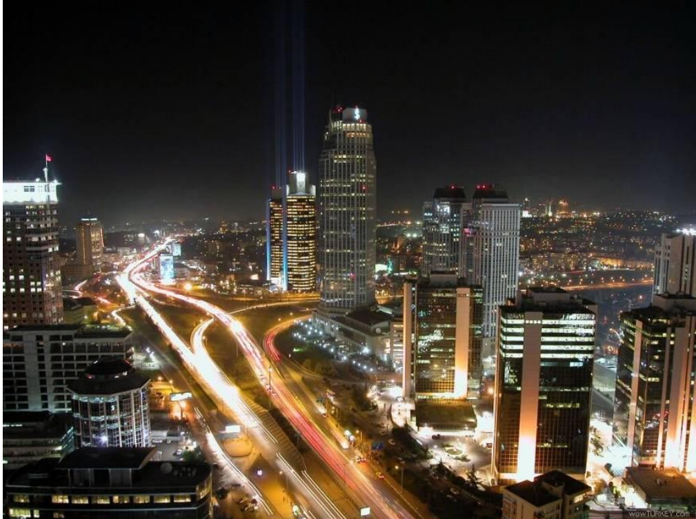
Şekil 1.1 Büyükdere Caddesi Kısmi gece görünüşü (İcon Dergisi, 2008)
