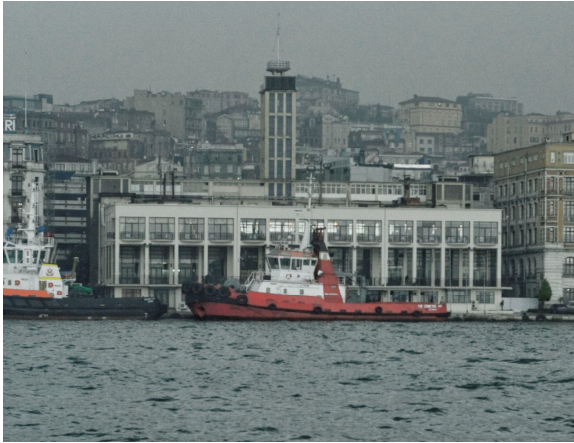
Şekil 4.5 Deniz cephe güncel fotoğrafı (İ.A Meltem arşivi)
