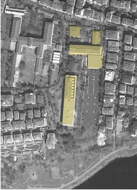
Şekil 4.61 Binanın güncel hava fotoğrafı (www.maps.google.com)
