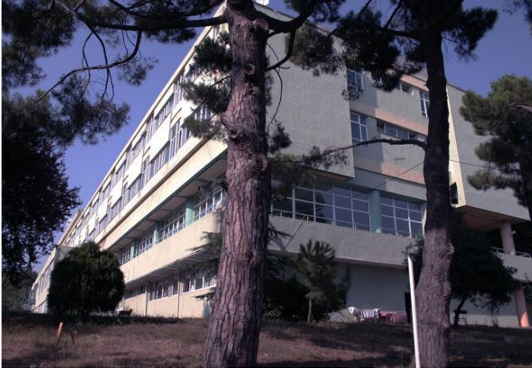
Şekil 4.58 Binanın deniz tarafından çekilmiş güncel fotoğrafı (İ.A Meltem arşivi)
