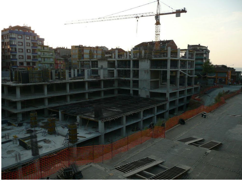
Şekil 4.84 Bina şantiye fotoğrafı, 2008 (MTF arşivi)
