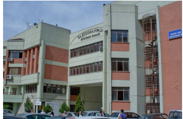
Şekil 4.68 Bina güncel fotoğrafı (İ.A Meltem arşivi)
