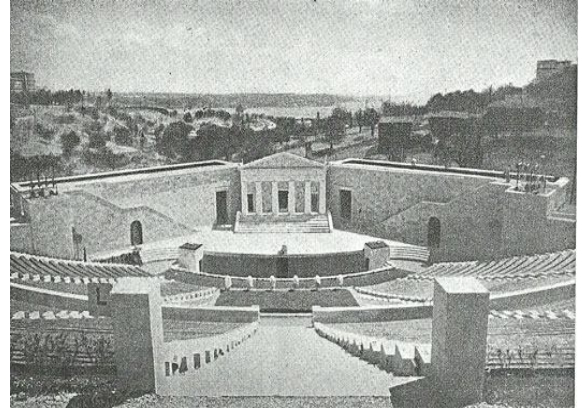
Şekil 4.40 Bina genel fotoğrafı 1948 (Arkitekt 1948/1-2)
