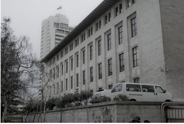
Şekil 4.29 Yol cephesi güncel fotoğrafı (İ.A Meltem arşivi)
