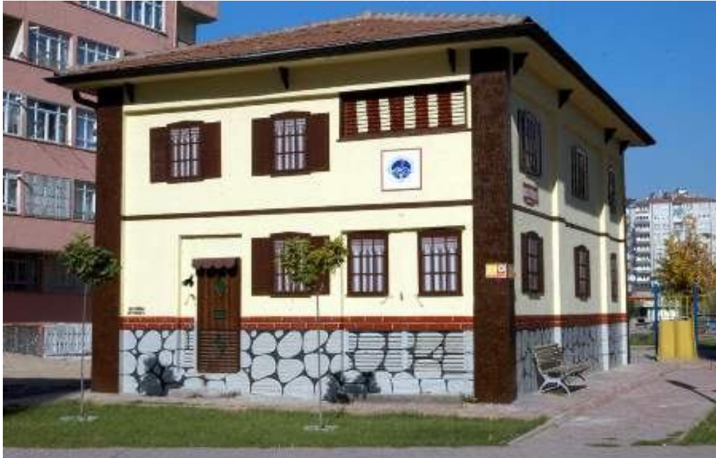
Şekil 2.8 İstanbul'da bir trafo binası fotoğrafı (İ.A Meltem arşivi)
