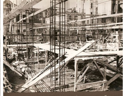
Tavan ve radye kırışıklı armatürleşmesi
