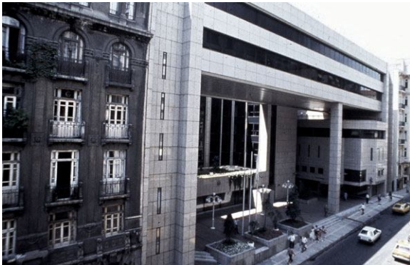
Şekil 3.3 M.R Binası cephe fotoğrafı ( http://arkiv.arkitera.com )
