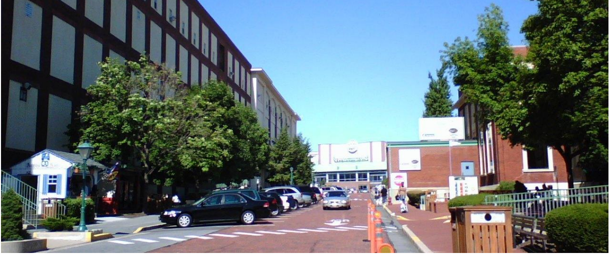
Şekil 5.3 VF Outlet Merkezi (1974), Reading, Pennsylvania
