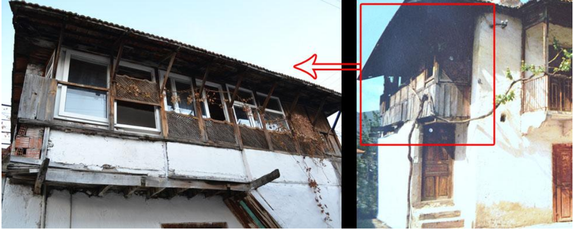
Şekil 4. 6 PVC ve tuğla malzeme kullanılarak tamamen kapatılan dış sofa örneği (Envanter no: 69)
