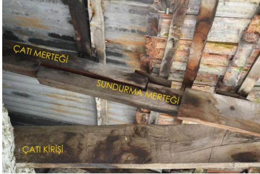
Şekil 4. 35 Çatı ve sundurma birleşim detayı (Envanter no: 145)
