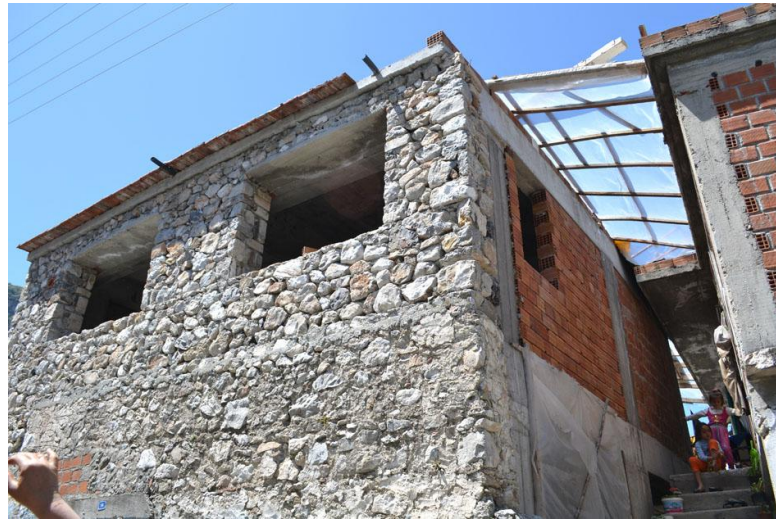
Şekil 5. 20 Cephede yığma taş, betonarme yapı örneği (2012)
