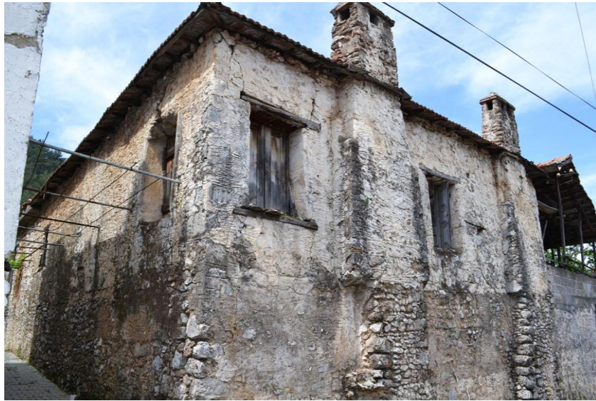
Şekil 3. 8 Yığma taş strüktüre sahip bir konut yapısı (2012)
