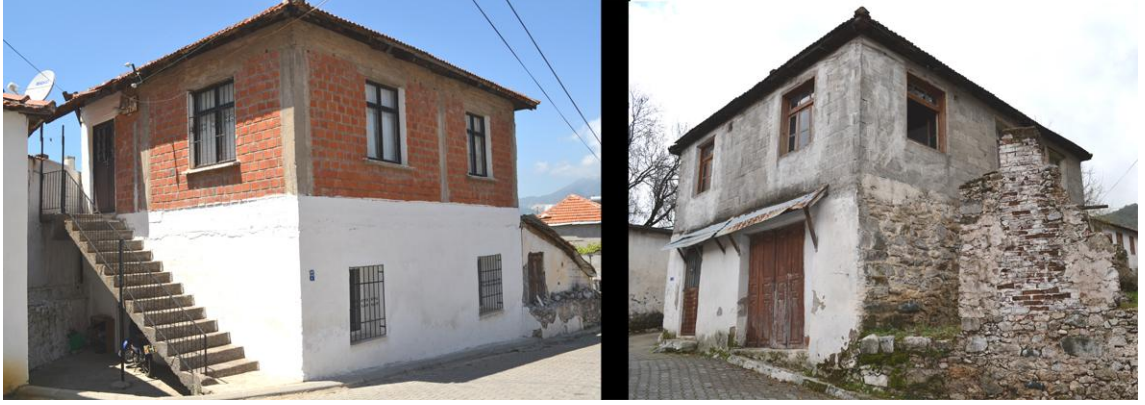
Şekil 5. 13 1957 depreminden sonra üst katları ikinci kez inşa edilen taş yapılar (2012)
