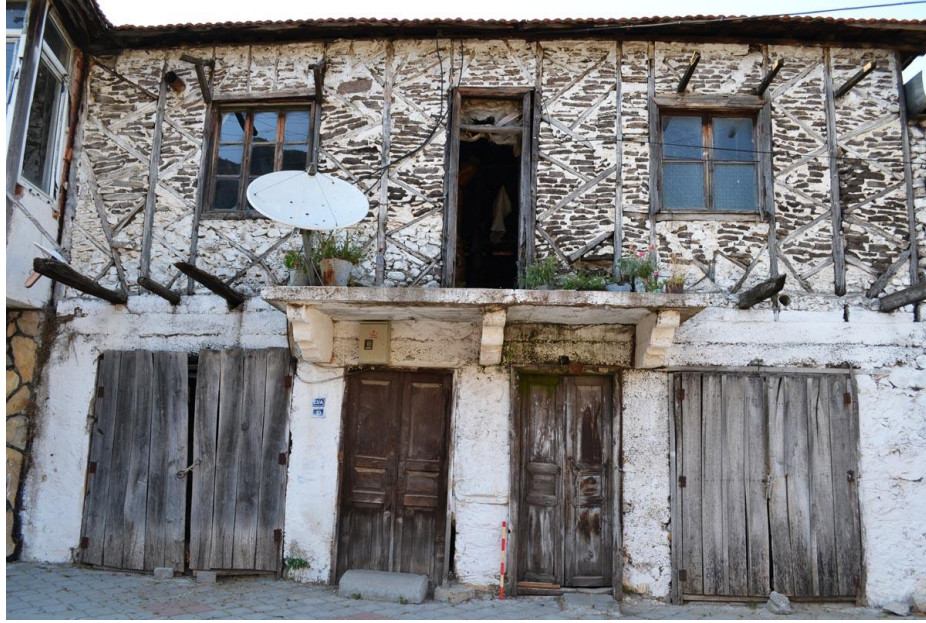
Şekil 3. 10 Yığma taş üzerine ahşap karkas (kargir tuğla) sistem örneği (2012)
