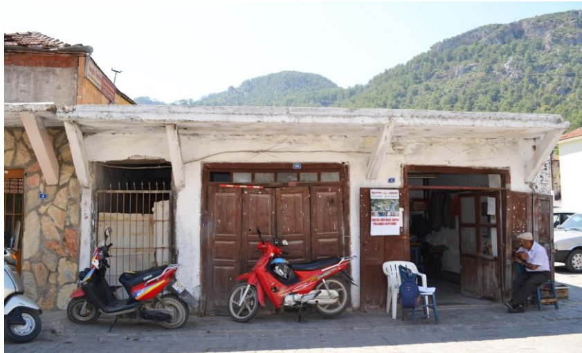
Şekil 3. 6 Çatısı 1957 depreminde hasar gören bir dükkanda teras çatı uygulaması (2011)
