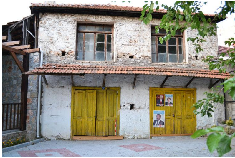
Şekil 4. 17 Çıkmasız iki katlı cephe örneği
