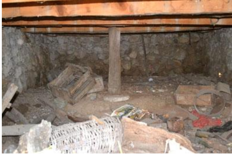
Şekil 4. 30 Temel ile zemin kat döşemesi arasındaki boşluk
