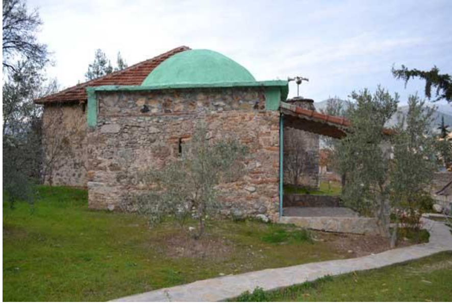
Şekil 2. 47 Türbenin güneydoğu cephesi (2012)
