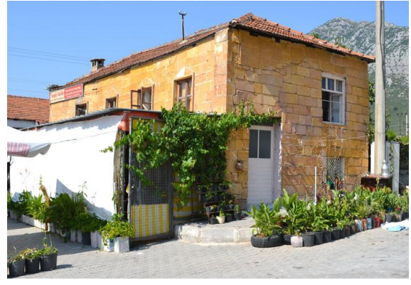
Şekil 5. 9 Cephede gazbeton tuğla kaplama
