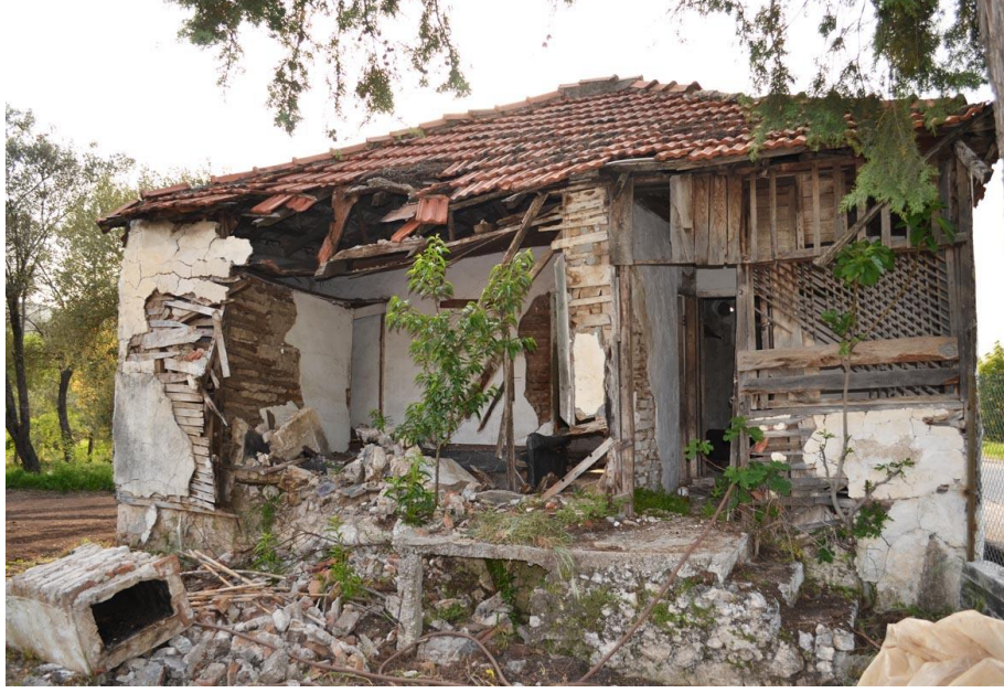
Şekil 3. 9 Yığma taş temel üzerine ahşap karkas (bağdadi) sistem örneği (2012)
