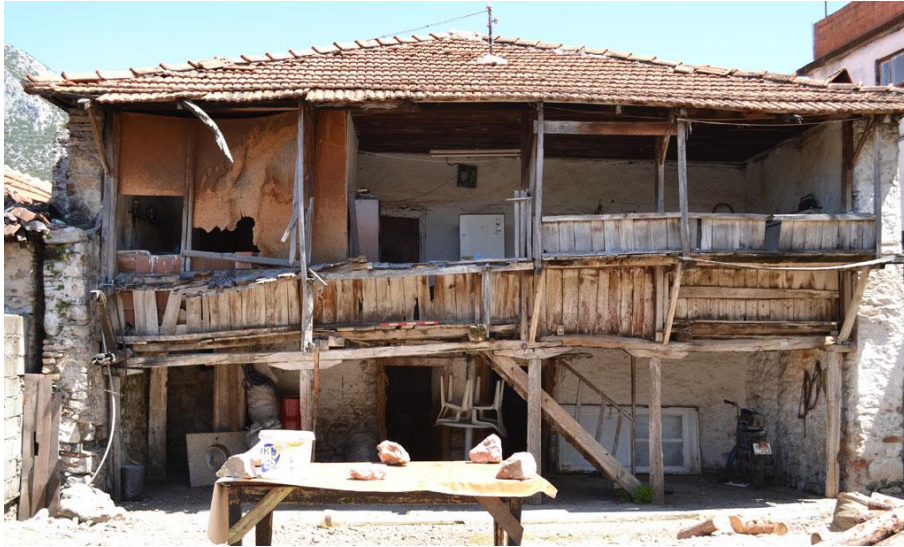
Şekil 4. 40 Cephede ayazlık örneği (Envanter no: 250)
