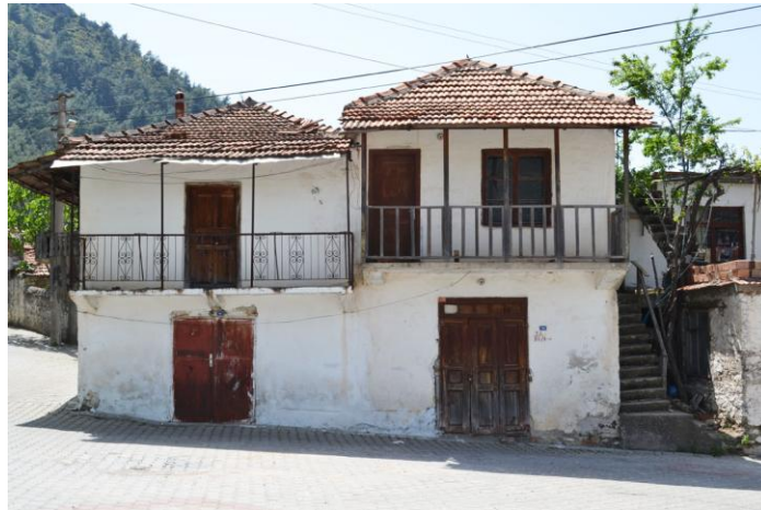
Şekil 4. 23 Çıkmanın yapı boyunca yer aldığı cephe örnekleri
