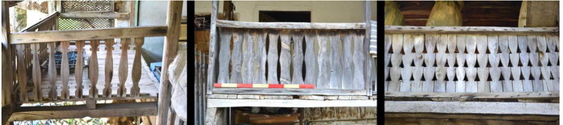
Şekil 4. 43 Ayazlıklarda korkuluk örnekleri
