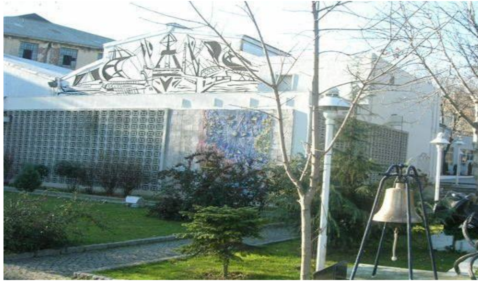
Şekil 37: Deniz Müzesi Tarihi Kayıklar Galerisi Eski Binası
