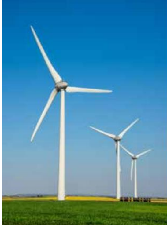
Şekil 9: Rüzgar Enerji Santrali
