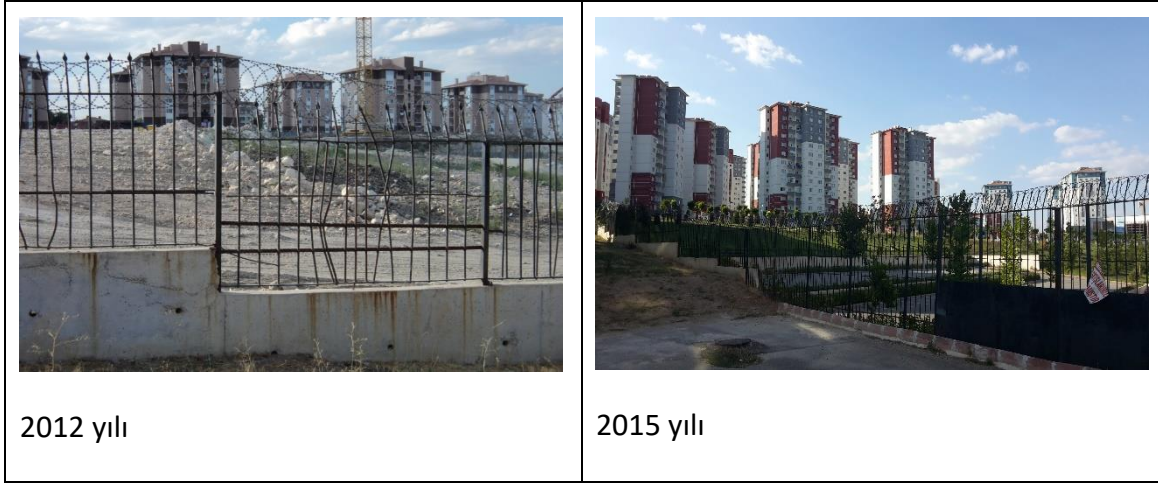
Şekil 5. 7 Site duvarlarından 4. Etaba bakış (Bektaş [164], [165])
