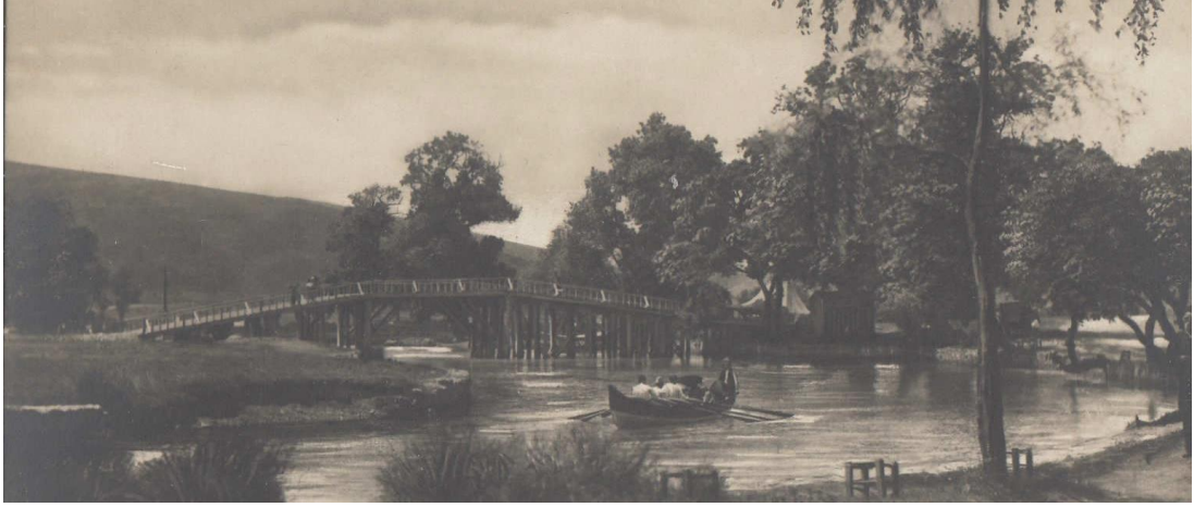
Şekil 2.70 Eskiden Kâğıthane Mesiresi'nde bulunan ahşap köprü [58]
