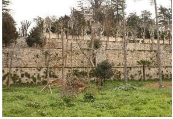
v: 2005 yılında set duvarlarının durumu [61]
