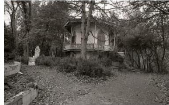
ae: Çadır Köşkü'nün onarım öncesi durumu, 1981 sonrası [61]
