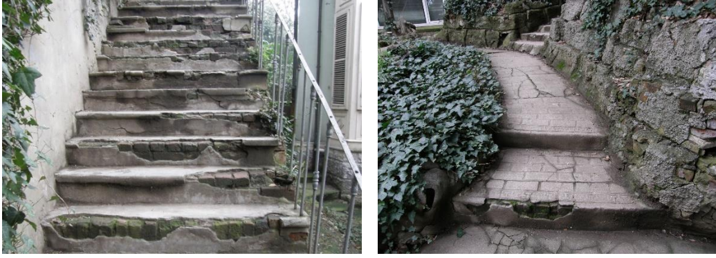
Şekil 3.45 Yıldız Sarayı Şehzade Köşkleri bahçesinde ciddi parça kaybına uğramış muhtemelen çimento bağlayıcılı merdiven sıvaları
