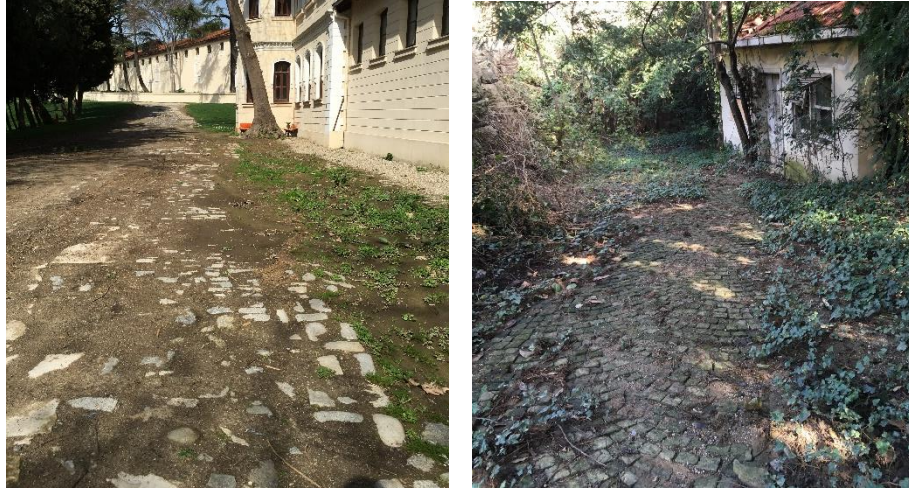
Şekil 3.37 Solda Yıldız Sarayı Has Ahır'ın çevresindeki bozulmuş yer döşemesi, sağda Yıldız Sarayı Şale Köşkü'nün bahçesindeki bozulmuş yer döşemesi
