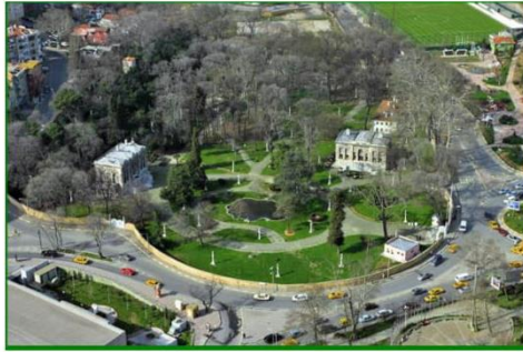
s: Kasır ve çevresinin günümüz durumu [92]
