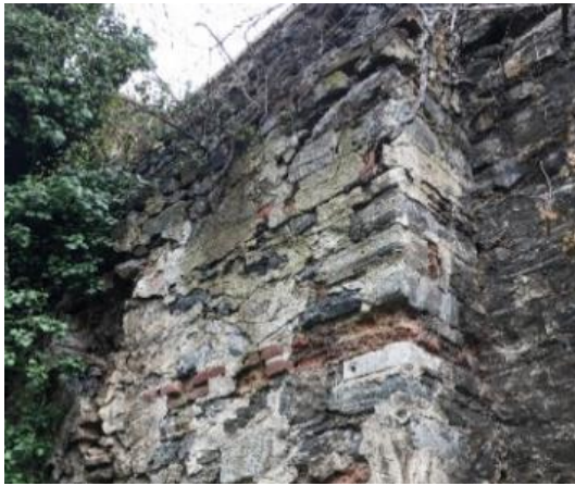
Şekil 3.44 Yıldız Sarayı Şehzade Köşkleri bahçesinde yüzey sıvası ve derz harcı bozulmuş bahçe duvarları
