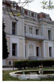
r: Kasrın arka bahçesinde bulunan fiskiyeli havuz [70]
