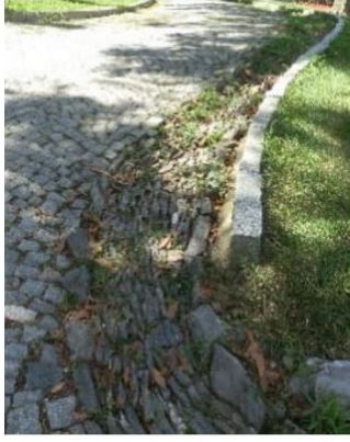
p: Yürüyüş yollarının kenarındaki kanallar
