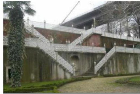
af: II. set bahçesine çıkan merdivenler
