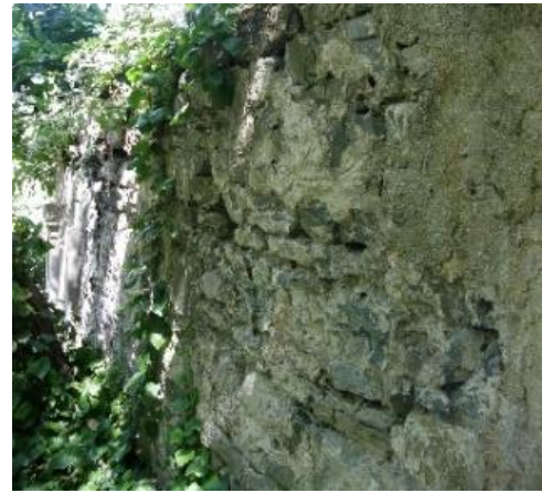
Şekil 3.44 Yıldız Sarayı Şehzade Köşkleri bahçesinde yüzey sıvası ve derz harcı bozulmuş bahçe duvarları
