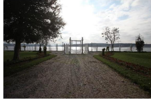
al: Onarım sonrası iskele kapısının hali
